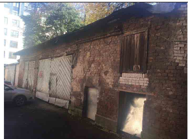
Фото 6. Вид внутреннего двора здания, расположения Объекта оценки
