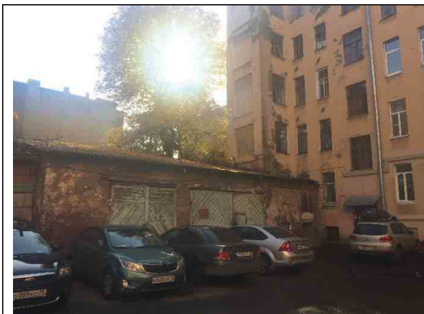
Фото 95. Вид внутреннего двора здания, расположения Объекта оценки
