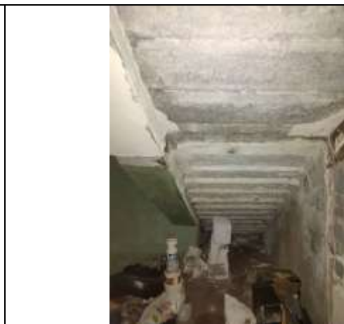
Фото 12 Общий вид и состояние помещения
