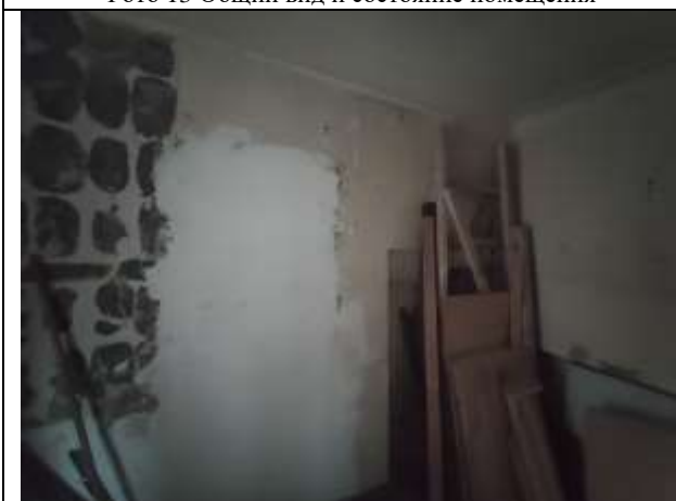
Фото 15 Общий вид и состояние помещения
