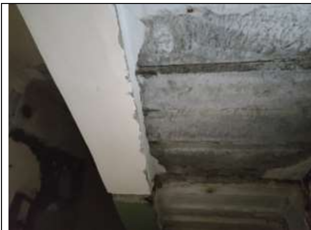
Фото 19 Общий вид и состояние помещения
