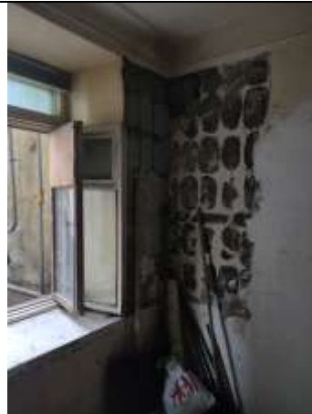
Фото 22 Общий вид и состояние помещения
