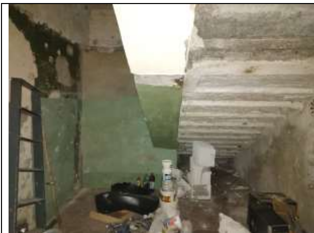
Фото 11 Общий вид и состояние помещения
