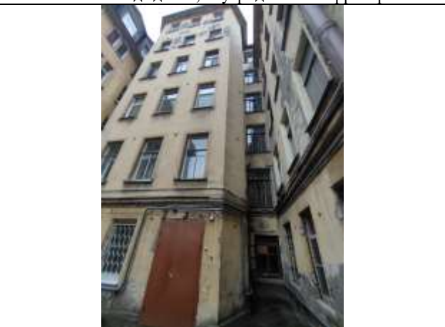
Фото 6 Фасад здания, внутридомовая территория, окно помещения
