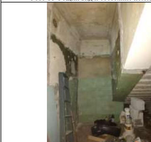
Фото 13 Общий вид и состояние помещения
