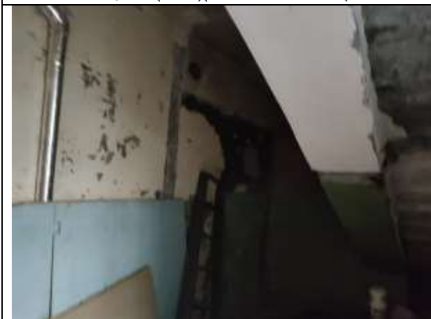
Фото 17 Общий вид и состояние помещения
