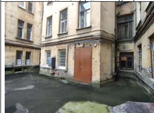
Фото 5 Фасад здания, внутридомовая территория, окно помещения
