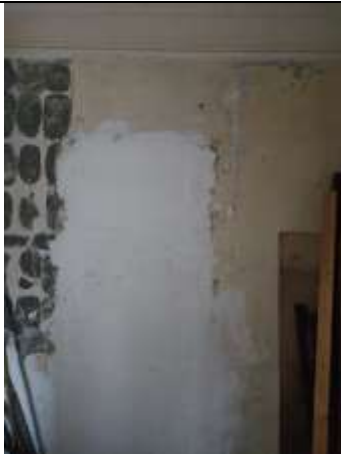
Фото 21 Общий вид и состояние помещения
