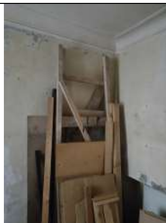
Фото 20 Общий вид и состояние помещения
