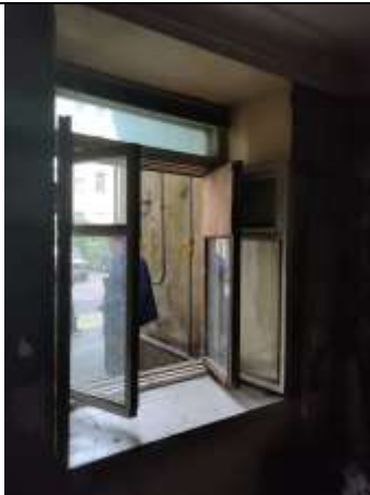
Фото 23 Общий вид и состояние помещения
