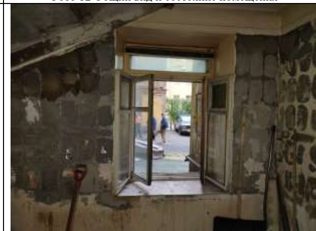
Фото 14 Общий вид и состояние помещения
