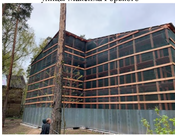
Фото 4. Общий вид оцениваемого здания со двора
