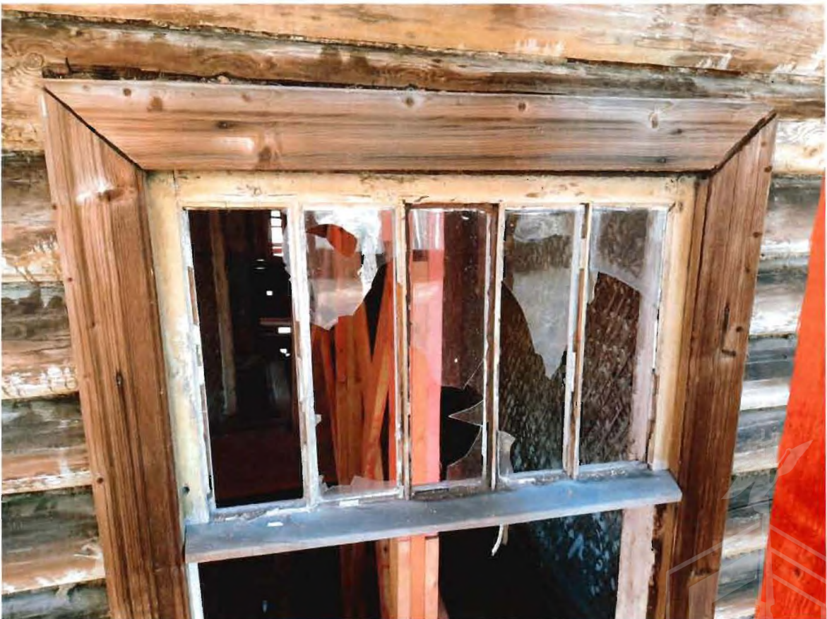
3. Историческая расстекловка оконных проемов
