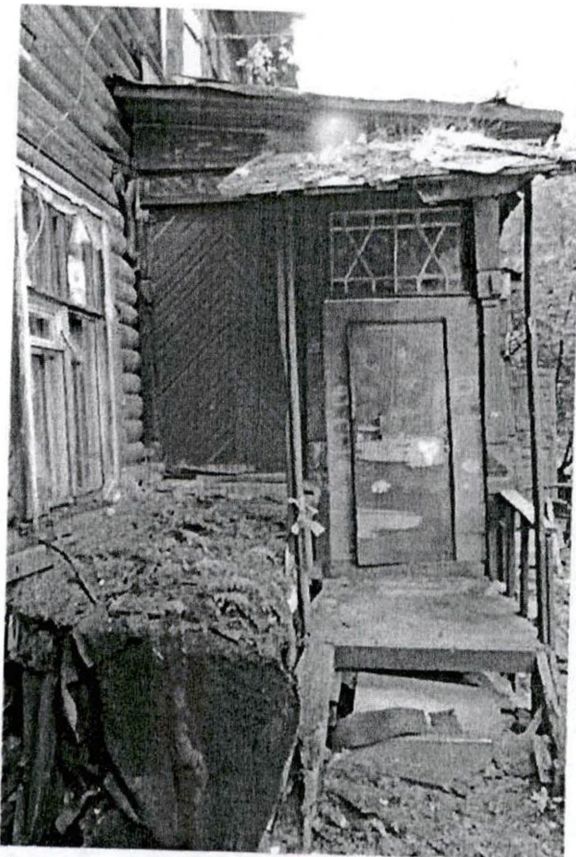
Фото 8. Крыльцо западного фасада
