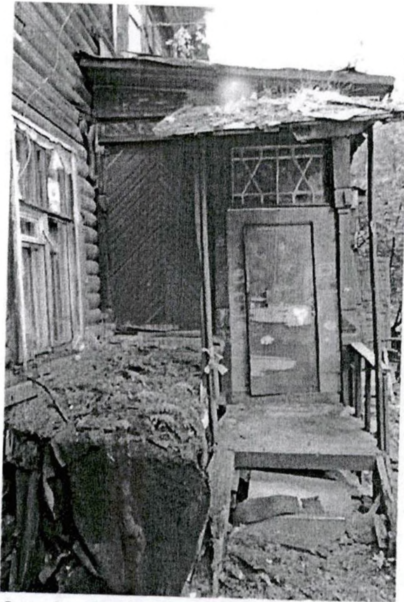
Фото 8. Крыльцо западного фасада
