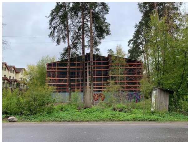
Фото 2. Общий вид оцениваемого здания с улицы Максима Горького
