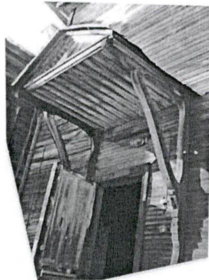
Фото 9. Фрагмент южного фасада. Козырек над крыльцом
