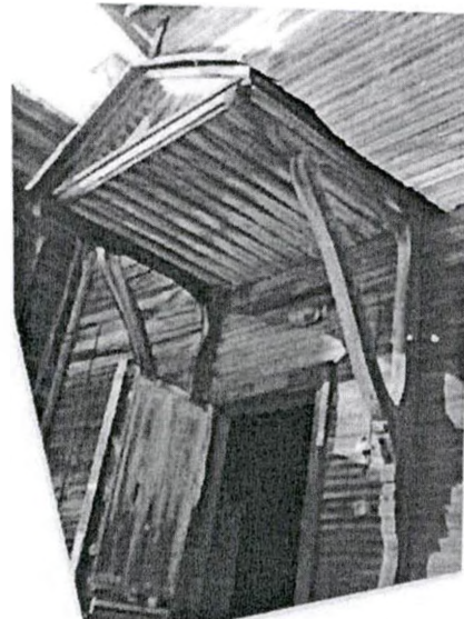
Фото 9. Фрагмент южного фасада. Козырек над крыльцом
