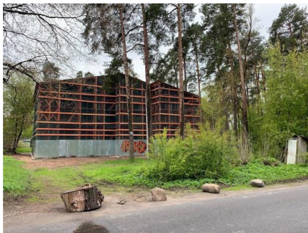
Фото 1. Общий вид оцениваемого здания со стороны улицы Максима Горького
