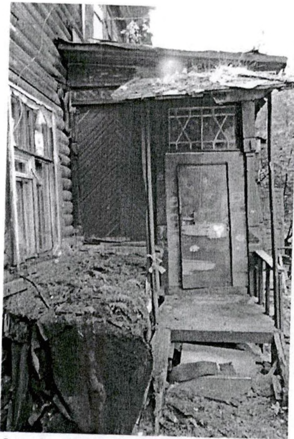
Фото 8. Крыльцо западного фасада
