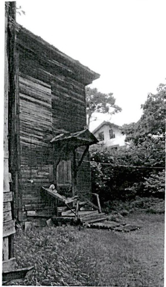
Фото 4. Фрагмент южного фасада
