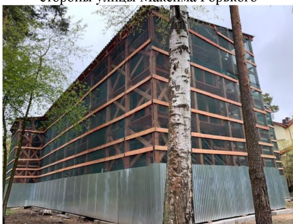
Фото 3. Общий вид оцениваемого здания со двора
