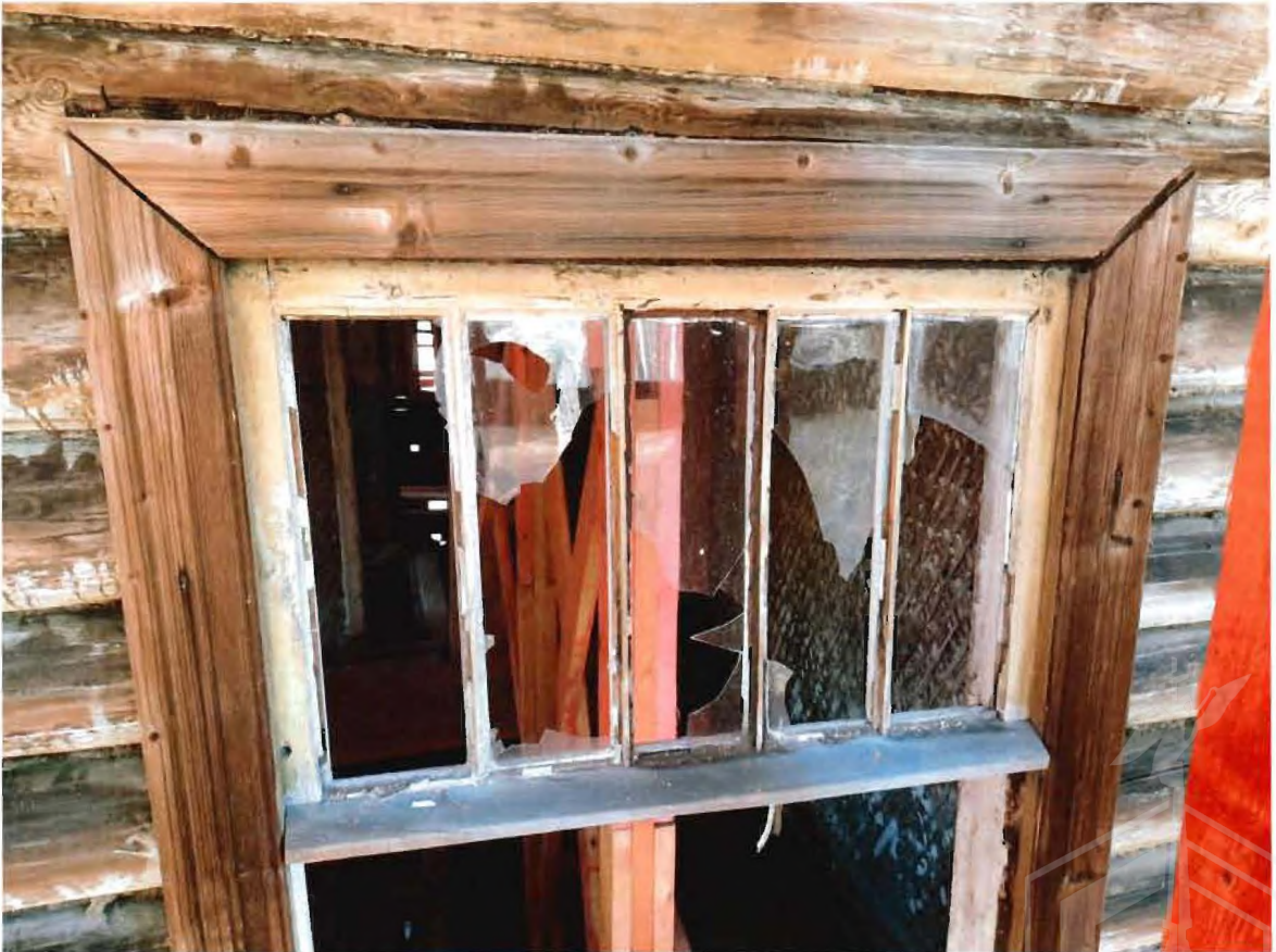
3. Историческая расстекловка оконных проемов
