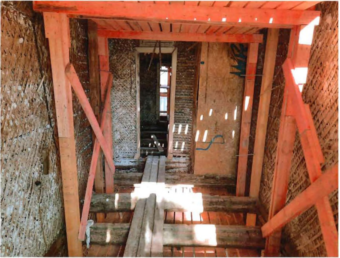
4. Вид на внутренние конструкции
