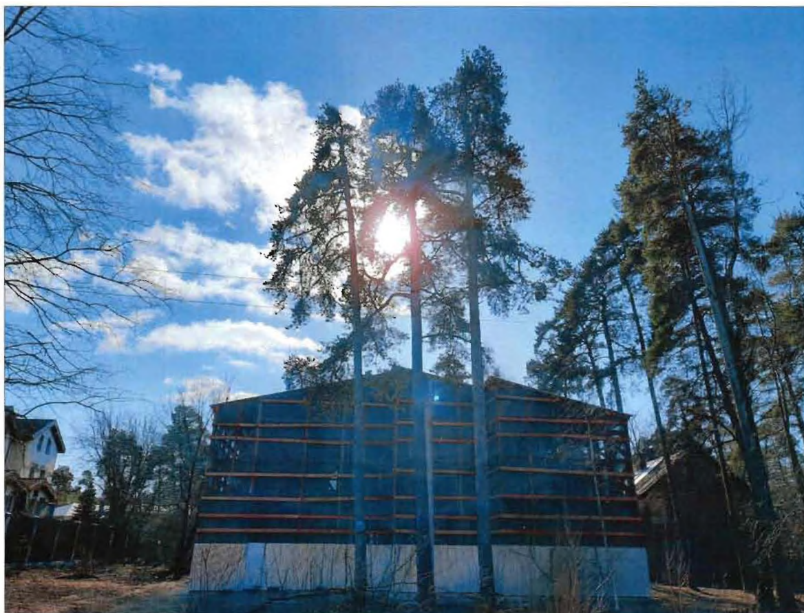
1. Общий вид со стороны северного фасада
