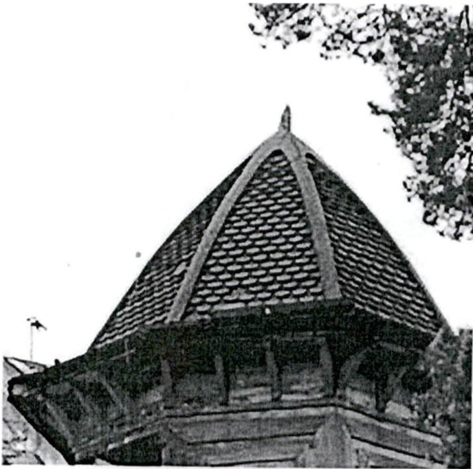
Фото 5. Фрагмент северного фасада. Крыша.
