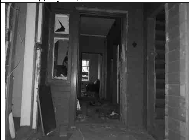
Фото 15. Внутреннее состояние здания
