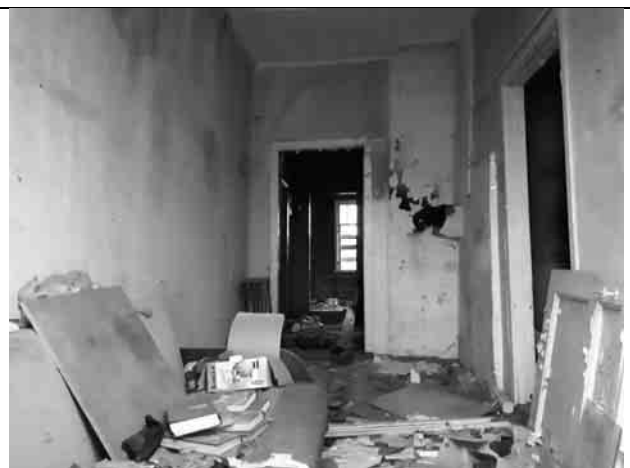
Фото 18. Внутреннее состояние здания
