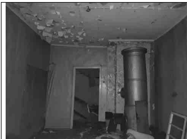
Фото 17. Внутреннее состояние здания
