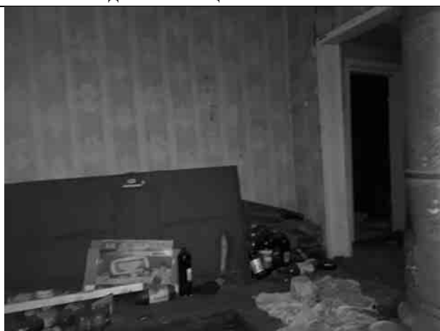
Фото 16. Внутреннее состояние здания
