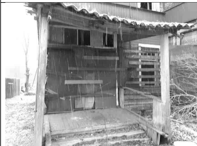
Фото 13. Доступ в здание
