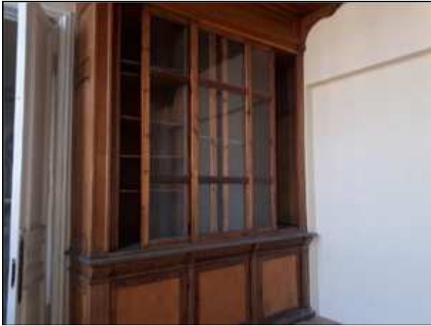
Фото 180. Сохранившиеся интерьеры 3 парадного этажа
