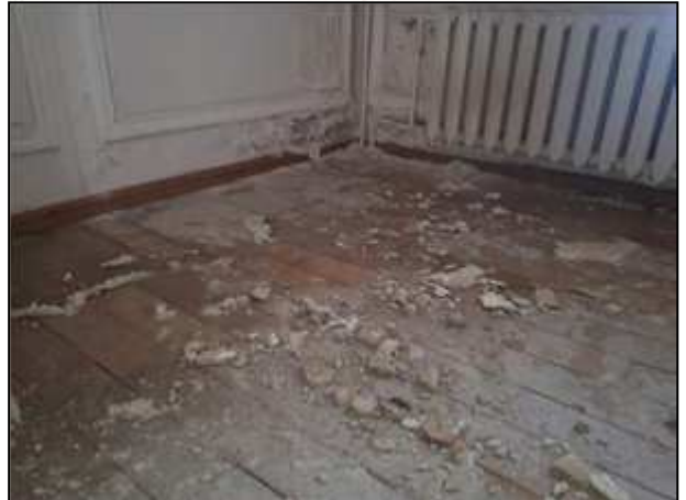
Фото 199. Состояние помещений 3 парадного этажа
