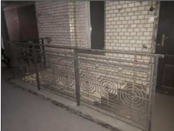
Фото 25. Вход в подвал со стороны двора
