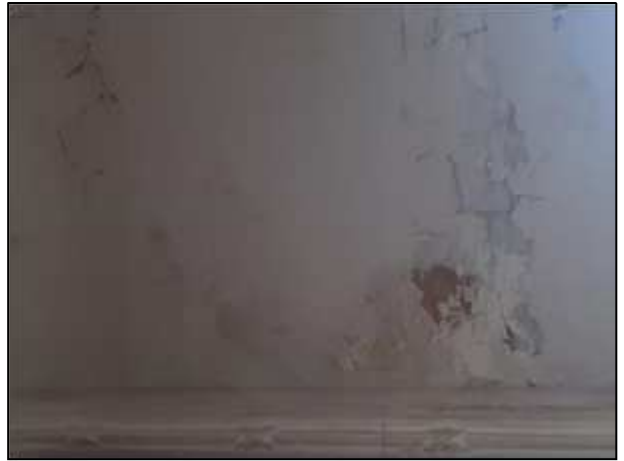
Фото 195. Состояние помещений 3 парадного этажа
