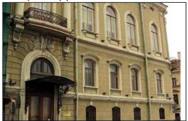
Фото 5. Вход в здание со стороны набережной Кутузова – не используется
