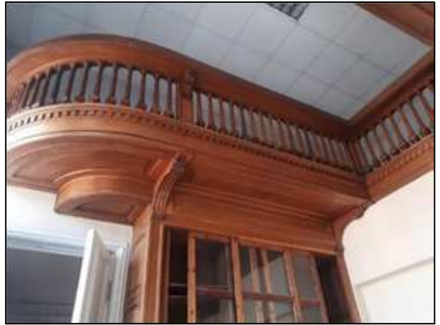
Фото 179. Сохранившиеся интерьеры 3 парадного этажа
