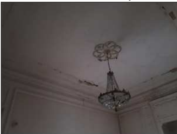
Фото 192. Состояние помещений 3 парадного этажа
