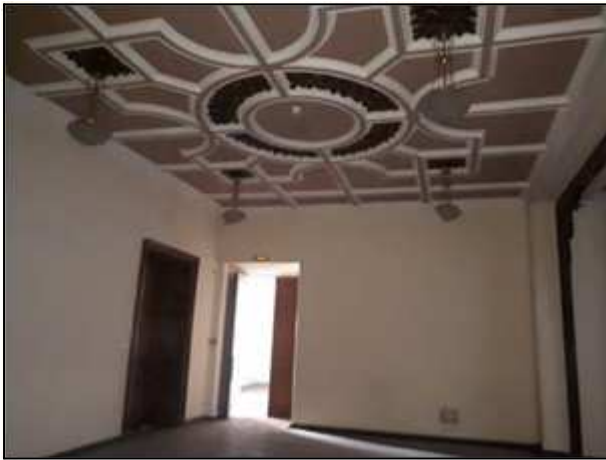
Фото 112. Состояние административных помещений на 2 этаже
