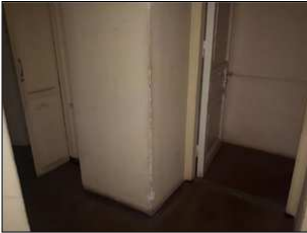
Фото 84. Состояние административных помещений на 2 этаже
