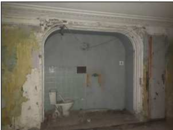
Фото 66. Неиспользуемые помещения в составе пом. 13-Н, 1 этаж
