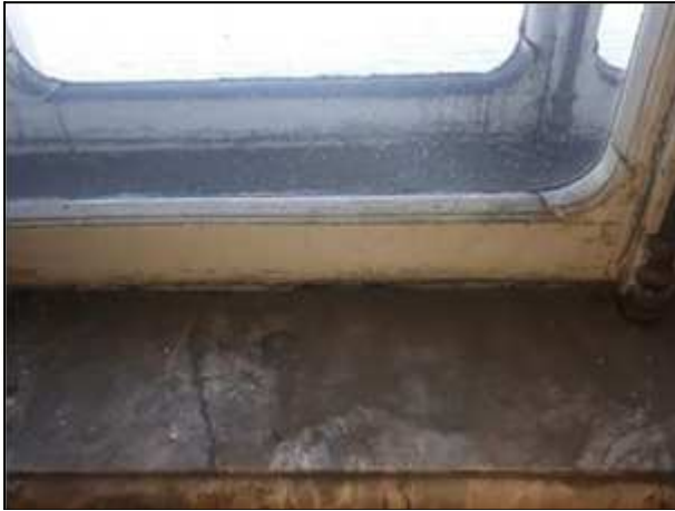
Фото 156. Сохранившиеся интерьеры 3 парадного этажа
