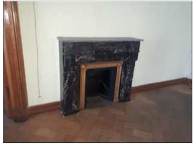
Фото 125. Состояние административных помещений на 2 этаже
