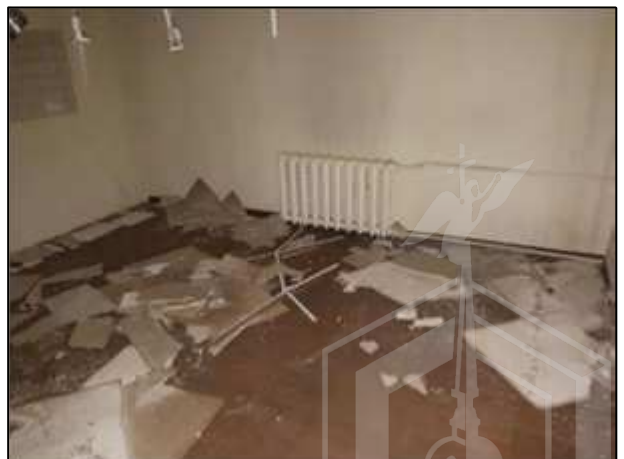
Фото 91. Состояние административных помещений на 2 этаже
