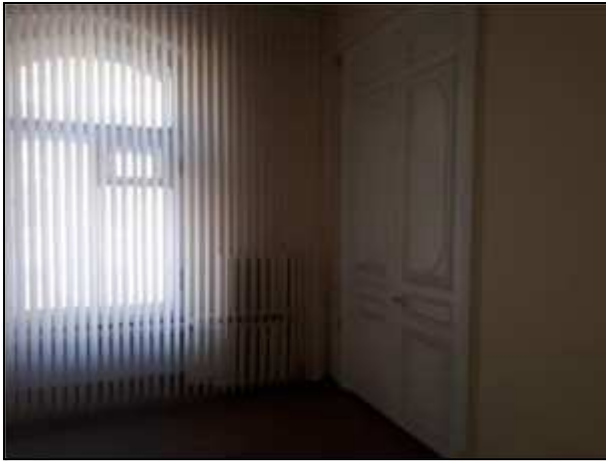
Фото 100. Состояние административных помещений на 2 этаже
