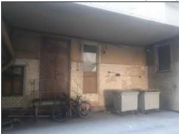
Фото 16. Вход в помещение теплоцентра (пом. 8-Н, не входит в состав Объекта оценки)
