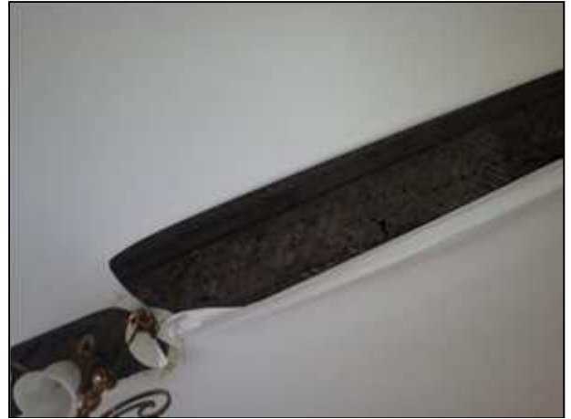
Фото 95. Состояние административных помещений на 2 этаже
