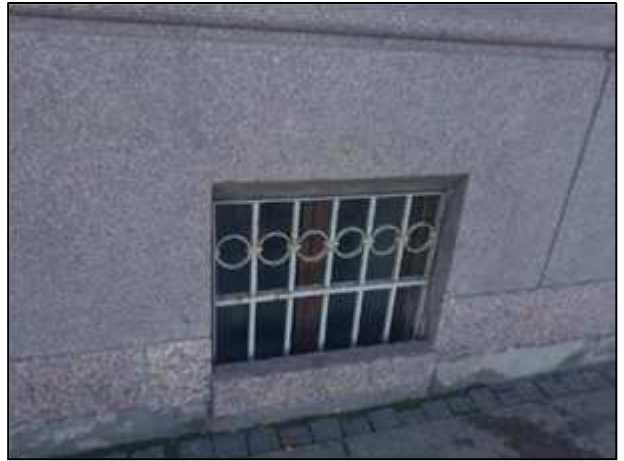
Фото 9. Окна подвала, вид со стороны наб. Кутузова
