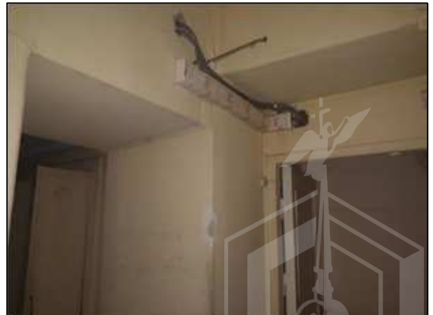
Фото 83. Состояние административных помещений на 2 этаже
