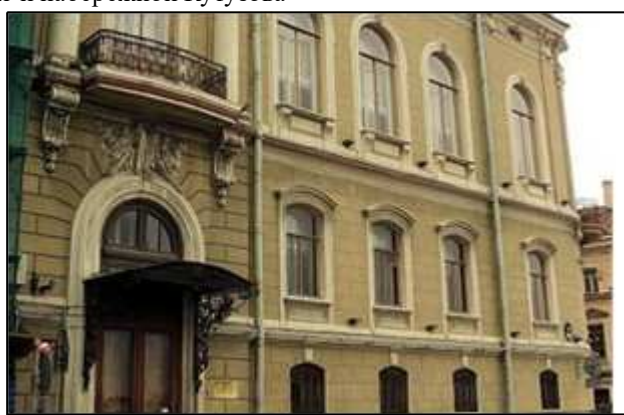
Фото 5. Вход в здание со стороны набережной Кутузова – не используется
