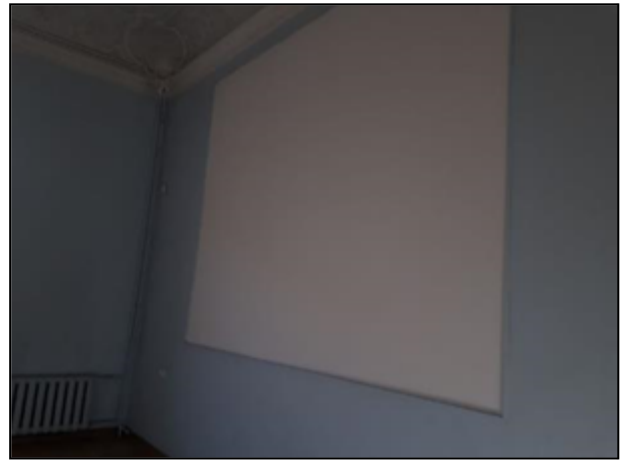
Фото 175. Сохранившиеся интерьеры 3 парадного этажа
