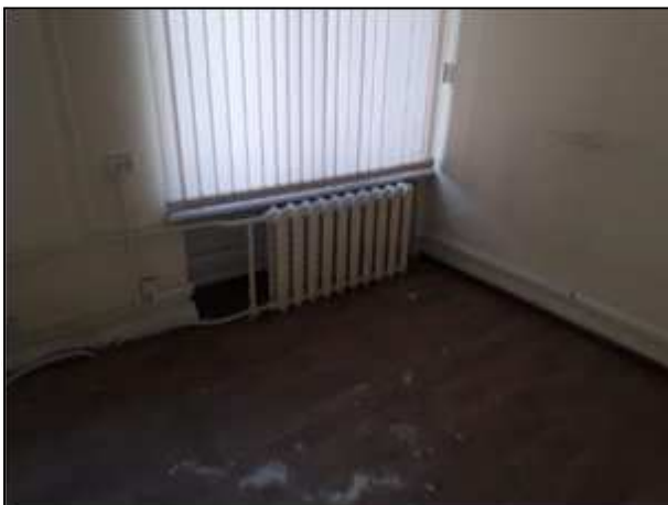
Фото 98. Состояние административных помещений на 2 этаже
