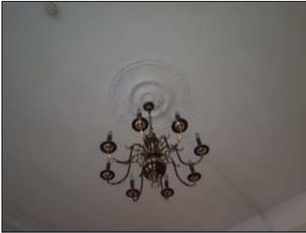
Фото 108. Состояние административных помещений на 2 этаже
