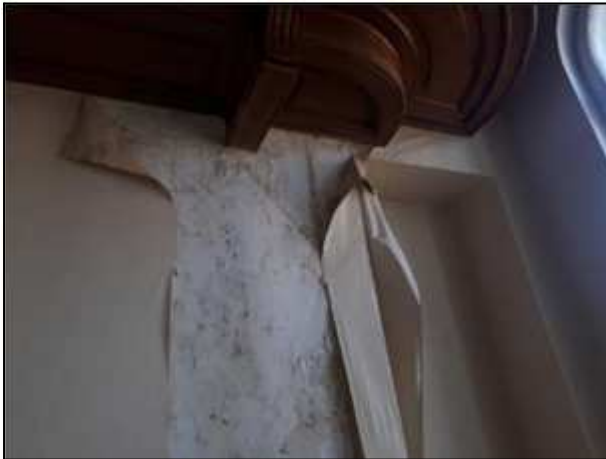
Фото 184. Состояние помещений 3 парадного этажа
