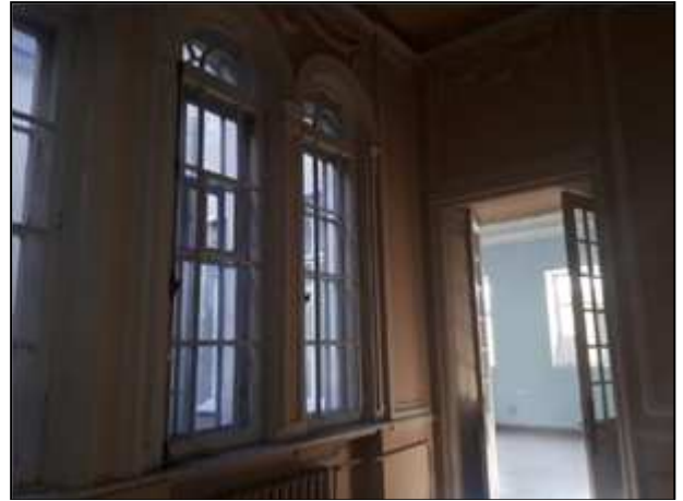
Фото 173. Сохранившиеся интерьеры 3 парадного этажа
