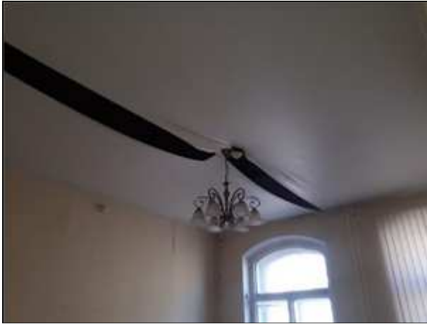
Фото 94. Состояние административных помещений на 2 этаже
