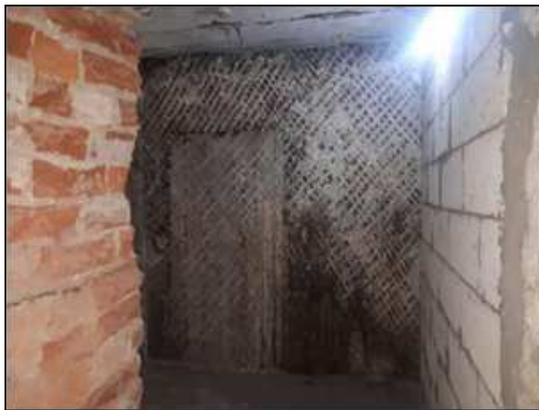
Фото 65. Неиспользуемые помещения в составе пом. 13-Н, 1 этаж
