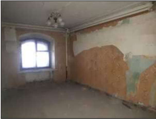
Фото 68. Неиспользуемые помещения в составе пом. 13-Н, 1 этаж
