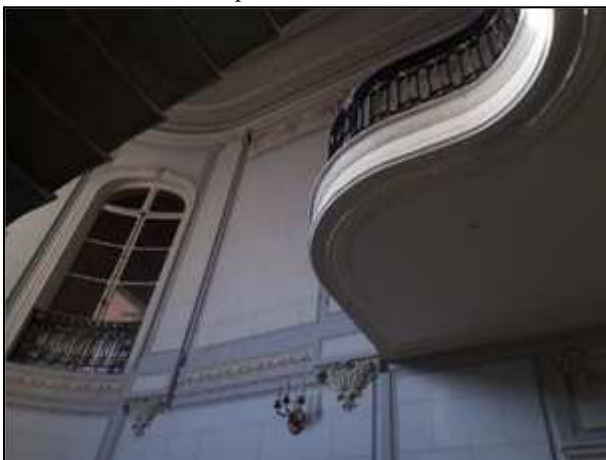
Фото 135. Парадная лестница в здании
