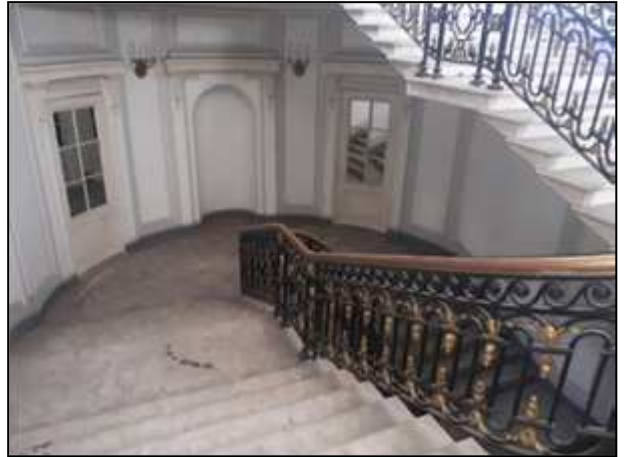
Фото 134. Парадная лестница в здании
