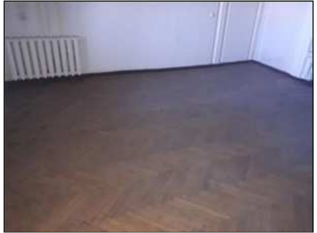
Фото 149. Состояние помещений 3 этажа
