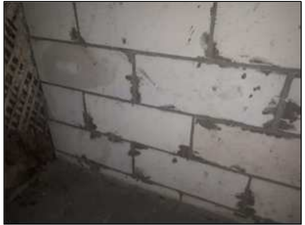
Фото 62. Неиспользуемые помещения в составе пом. 13-Н, 1 этаж
