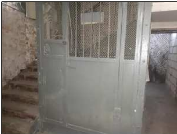
Фото 225. Лифт в здании (не используется)
