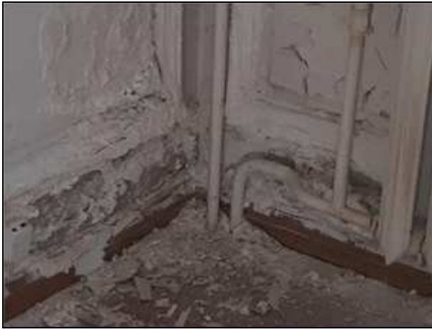
Фото 194. Состояние помещений 3 парадного этажа
