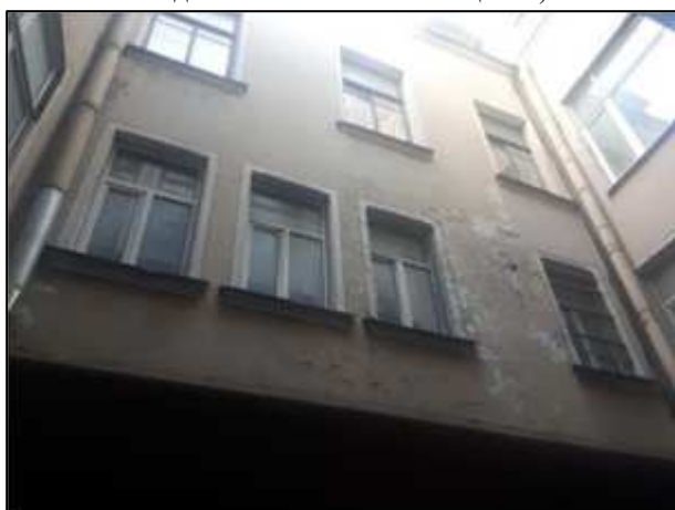
Фото 19. Состояние дворовых фасадов
