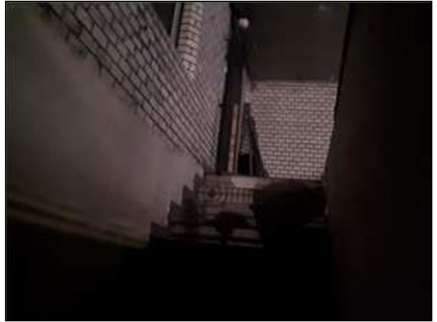
Фото 26. Вход в подвал, вид изнутри
