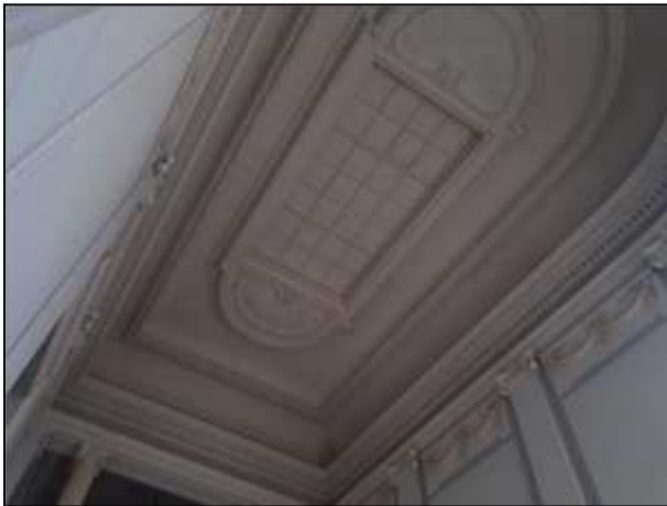
Фото 142. Парадная лестница в здании
