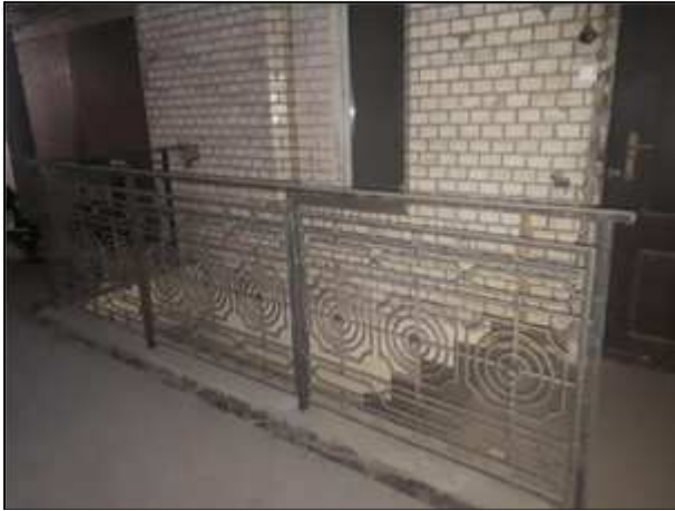
Фото 25. Вход в подвал со стороны двора
