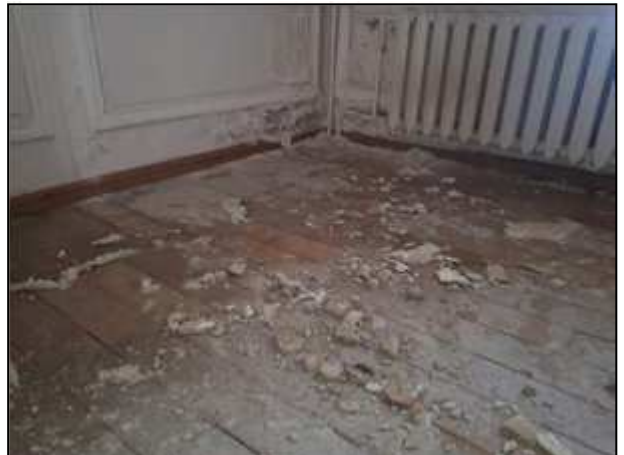
Фото 199. Состояние помещений 3 парадного этажа
