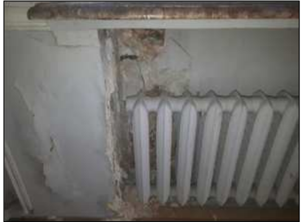
Фото 189. Состояние помещений 3 парадного этажа
