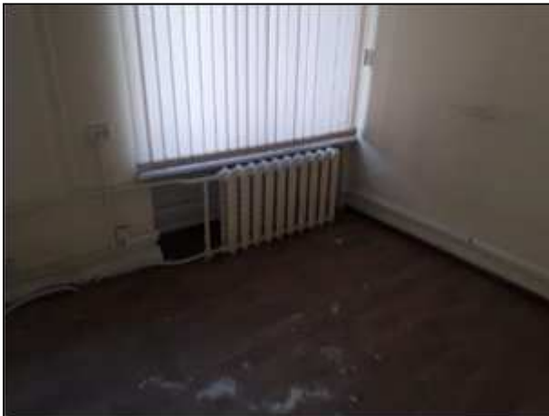
Фото 98. Состояние административных помещений на 2 этаже
