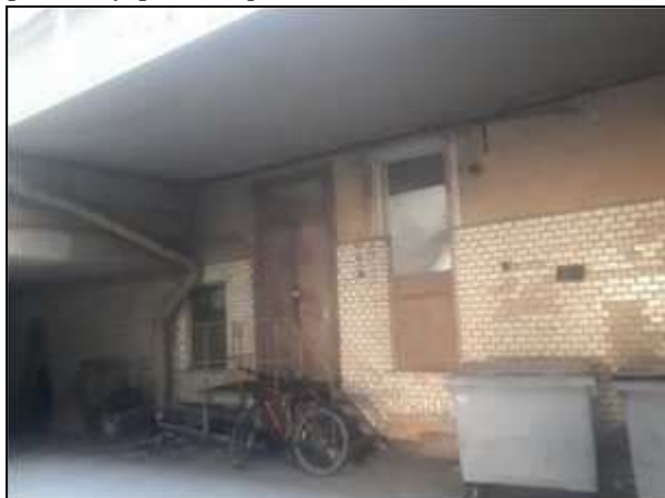
Фото 17. Вход в помещение теплоцентра (пом. 8-Н, не входит в состав Объекта оценки)
