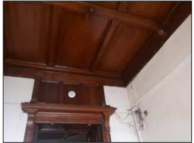
Фото 117. Состояние административных помещений на 2 этаже
