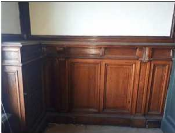
Фото 120. Состояние административных помещений на 2 этаже
