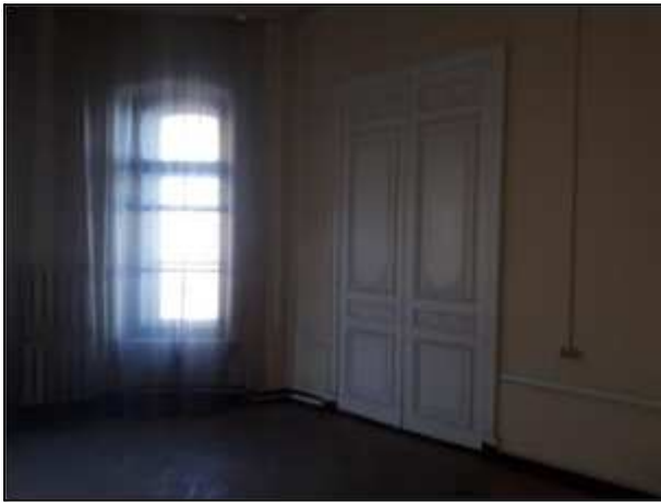
Фото 104. Состояние административных помещений на 2 этаже
