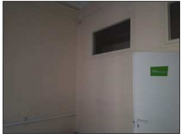
Фото 105. Состояние административных помещений на 2 этаже
