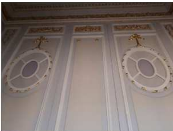
Фото 168. Сохранившиеся интерьеры 3 парадного этажа
