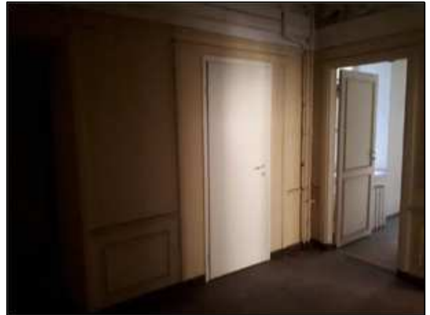
Фото 71. Состояние административных помещений на 2 этаже
