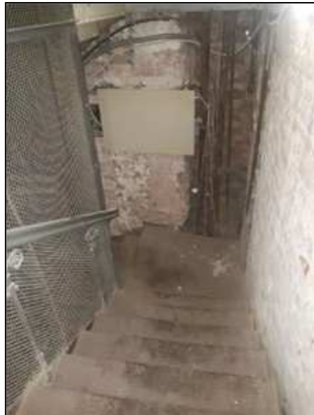
Фото 223. Лестничные переходы между этажами (черная лестница)
