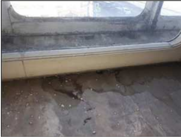
Фото 164. Сохранившиеся интерьеры 3 парадного этажа
