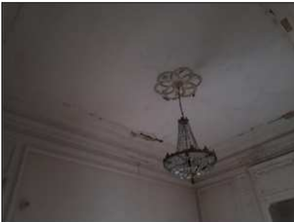
Фото 192. Состояние помещений 3 парадного этажа
