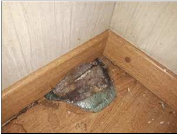
Фото 186. Состояние помещений 3 парадного этажа
