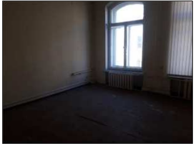
Фото 93. Состояние административных помещений на 2 этаже
