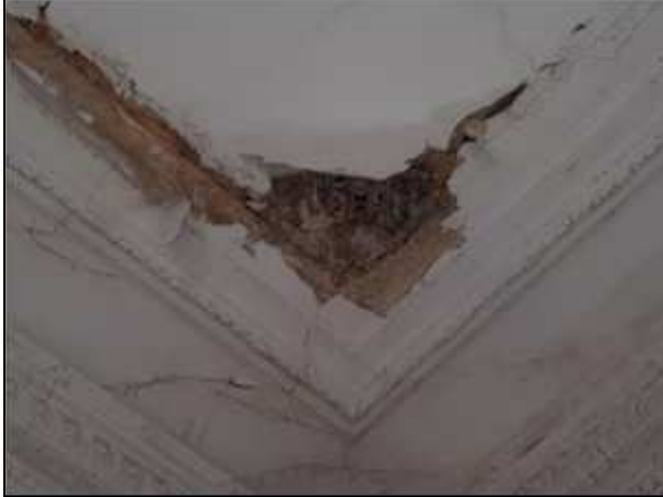
Фото 196. Состояние помещений 3 парадного этажа
