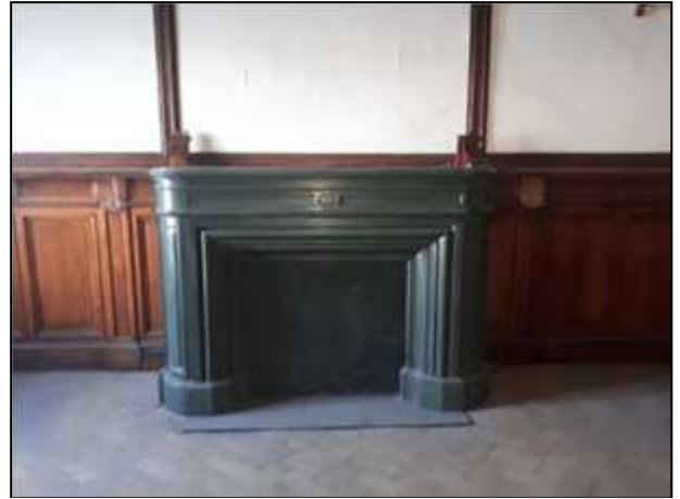
Фото 119. Состояние административных помещений на 2 этаже
