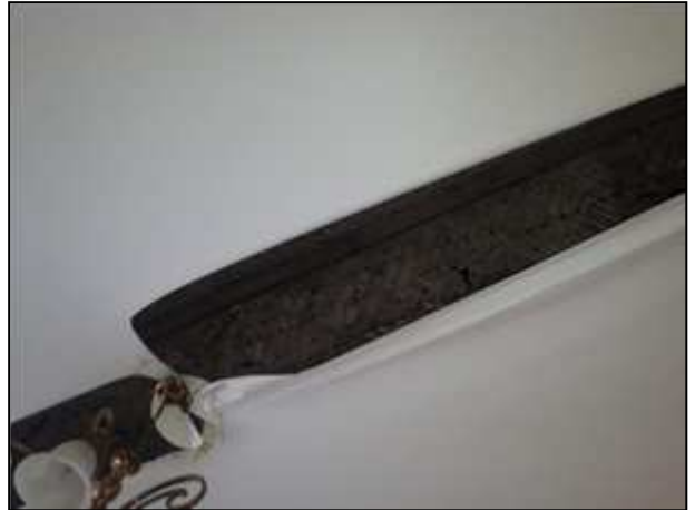
Фото 95. Состояние административных помещений на 2 этаже
