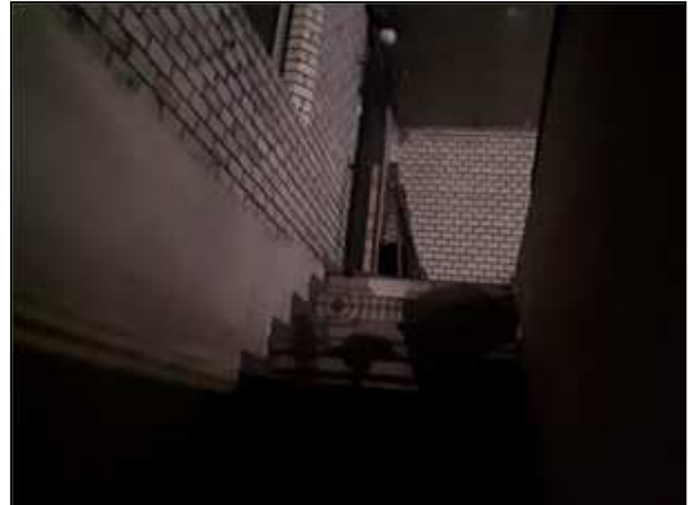
Фото 26. Вход в подвал, вид изнутри
