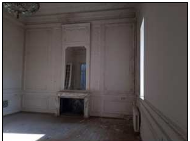
Фото 191. Состояние помещений 3 парадного этажа
