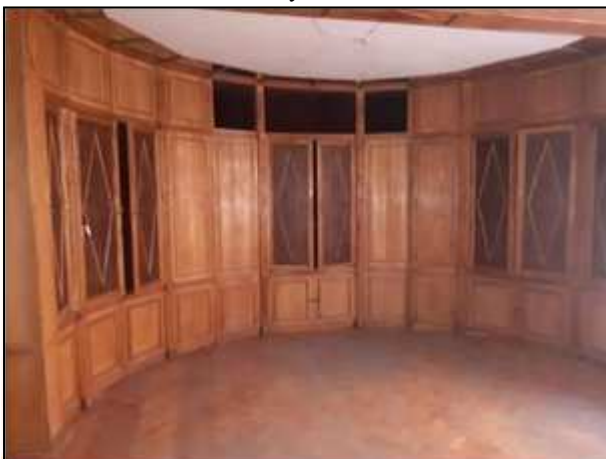
Фото 74. Состояние административных помещений на 2 этаже
