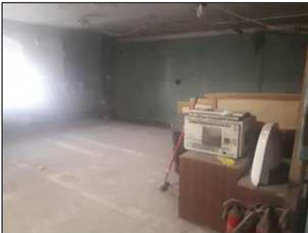
Фото 56. Помещение 11-Н, общий вид (гараж)
