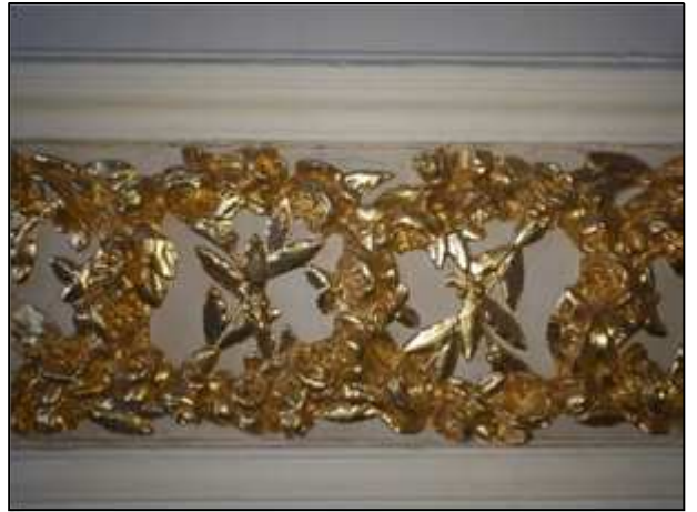
Фото 163. Сохранившиеся интерьеры 3 парадного этажа
