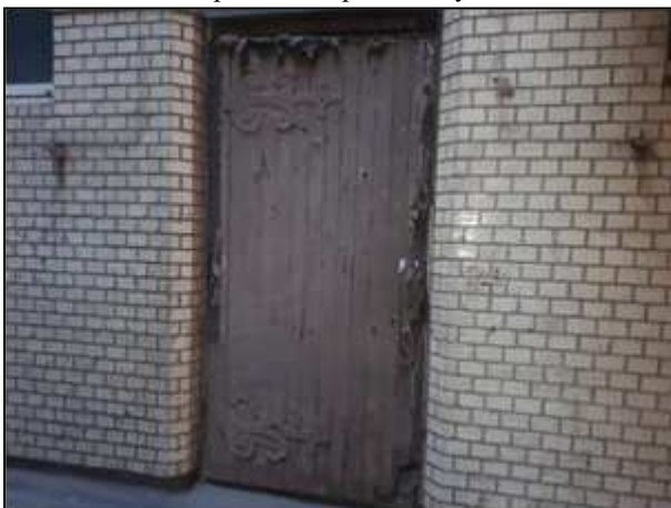
Фото 14. Вход в помещение 9-Н со двора (не используется)
