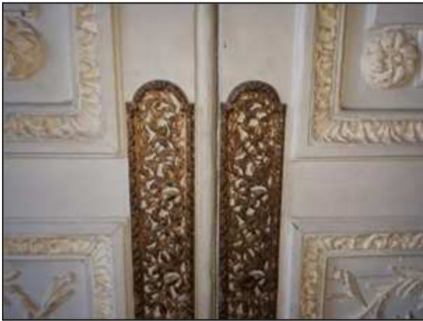
Фото 158. Сохранившиеся интерьеры 3 парадного этажа
