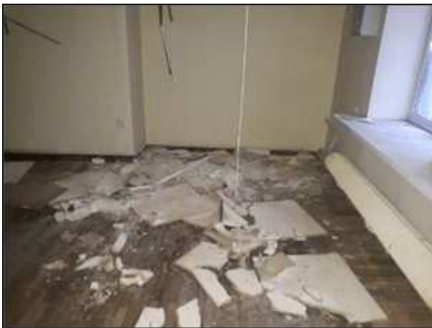
Фото 88. Состояние административных помещений на 2 этаже
