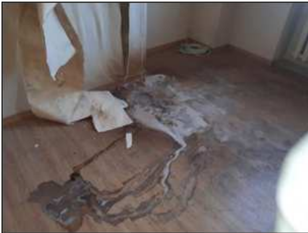
Фото 182. Состояние помещений 3 парадного этажа
