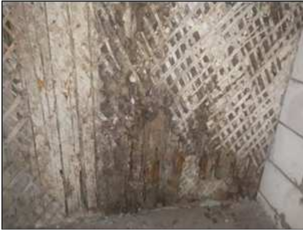
Фото 63. Неиспользуемые помещения в составе пом. 13-Н, 1 этаж
