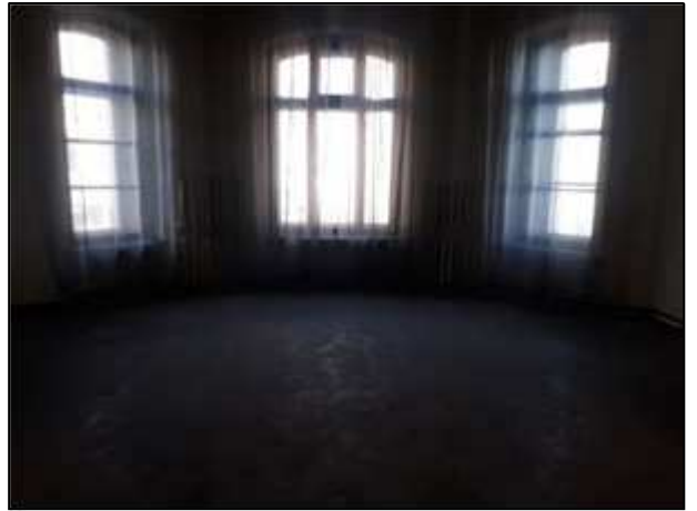
Фото 109. Состояние административных помещений на 2 этаже
