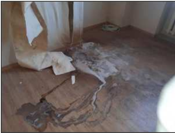
Фото 182. Состояние помещений 3 парадного этажа
