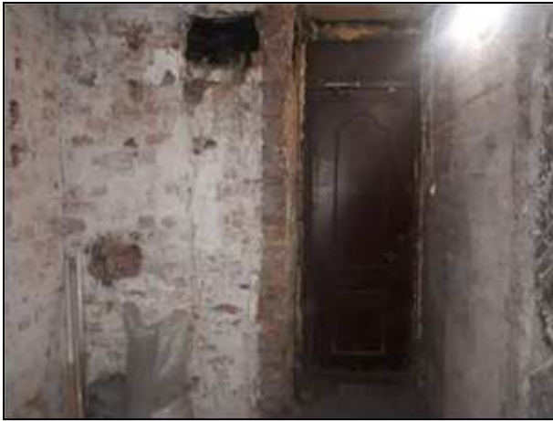
Фото 61. Неиспользуемые помещения в составе пом. 13-Н, 1 этаж
