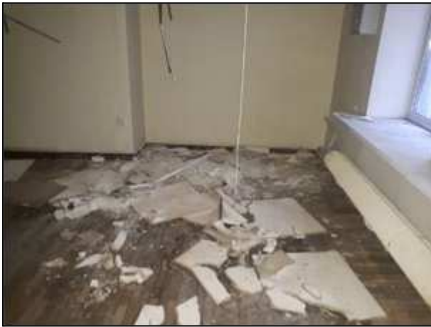
Фото 88. Состояние административных помещений на 2 этаже
