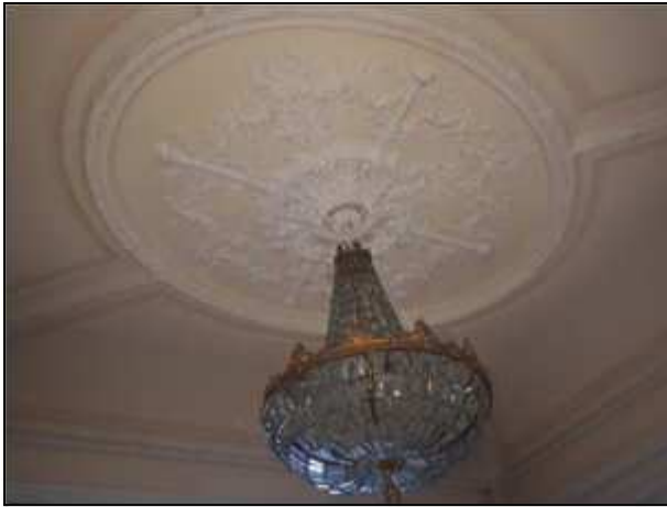
Фото 146. Сохранившиеся интерьеры 3 парадного этажа
