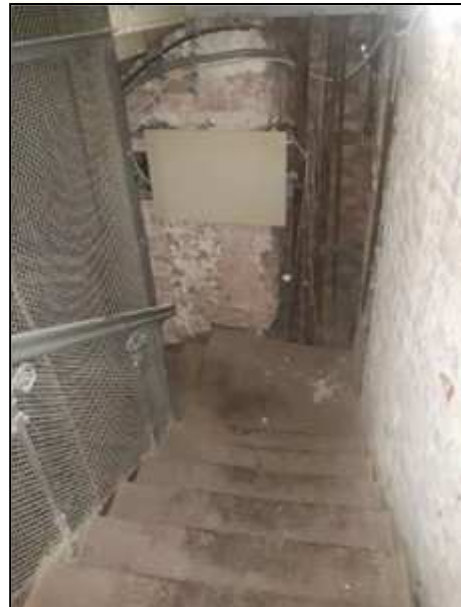
Фото 223. Лестничные переходы между этажами (черная лестница)
