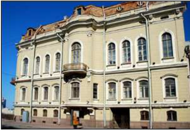
Фото 1. Общий вид здания со стороны Гагаринской улицы
