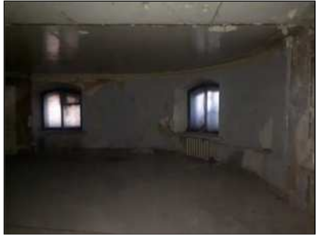
Фото 64. Неиспользуемые помещения в составе пом. 13-Н, 1 этаж
