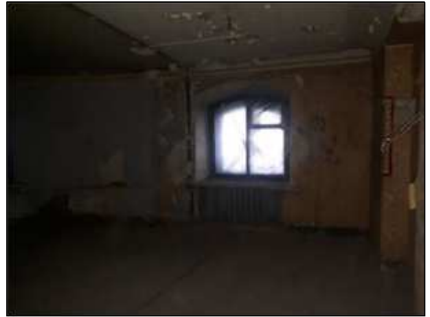
Фото 69. Неиспользуемые помещения в составе пом. 13-Н, 1 этаж
