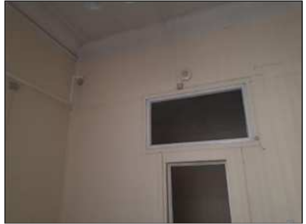
Фото 103. Состояние административных помещений на 2 этаже
