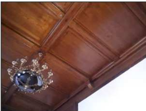
Фото 122. Состояние административных помещений на 2 этаже
