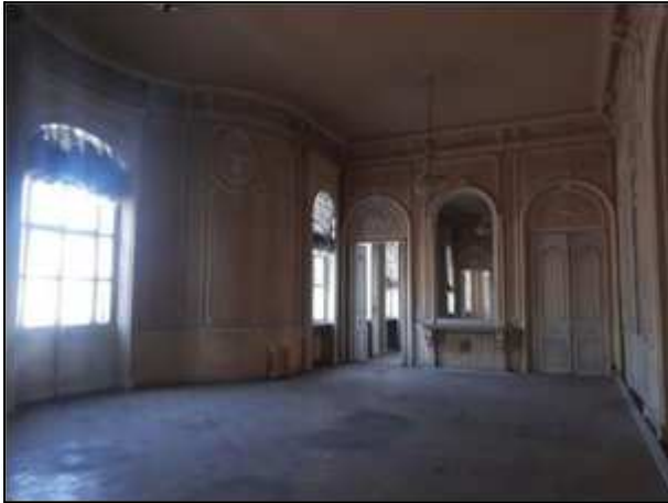
Фото 188. Сохранившиеся интерьеры 3 парадного этажа
