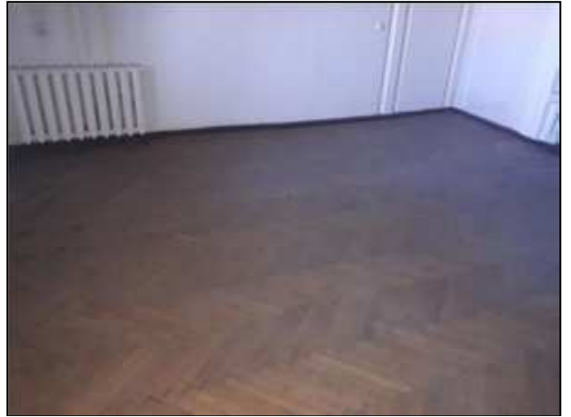
Фото 149. Состояние помещений 3 этажа
