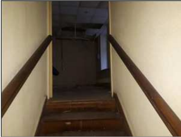
Фото 86. Состояние административных помещений на 2 этаже
