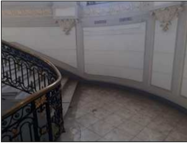
Фото 139. Парадная лестница в здании
