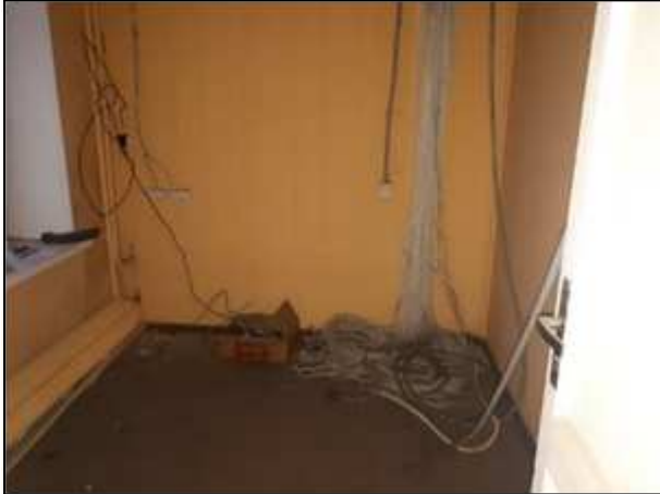
Фото 80. Состояние административных помещений на 2 этаже
