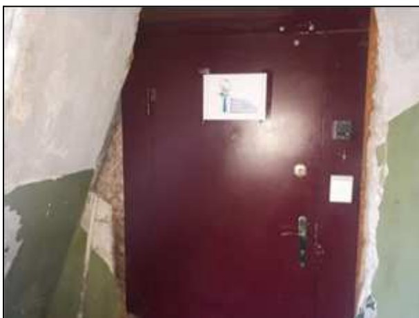
Фото 212. 5 этаж – вход в помещения в собственности ООО «Неохим»
