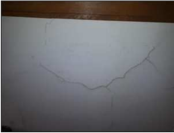
Фото 76. Состояние административных помещений на 2 этаже
