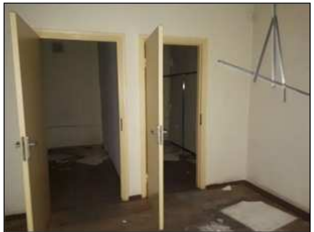
Фото 89. Состояние административных помещений на 2 этаже
