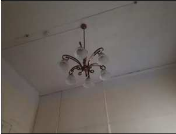
Фото 102. Состояние административных помещений на 2 этаже
