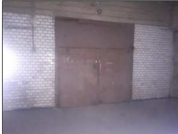
Фото 55. Вход в помещение 11-Н (гараж)
