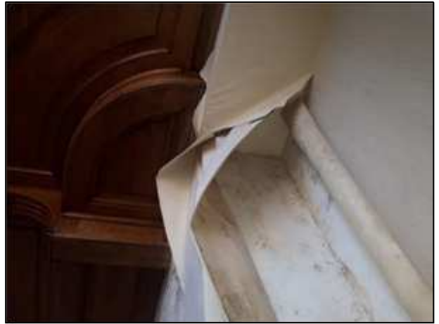
Фото 187. Состояние помещений 3 парадного этажа
