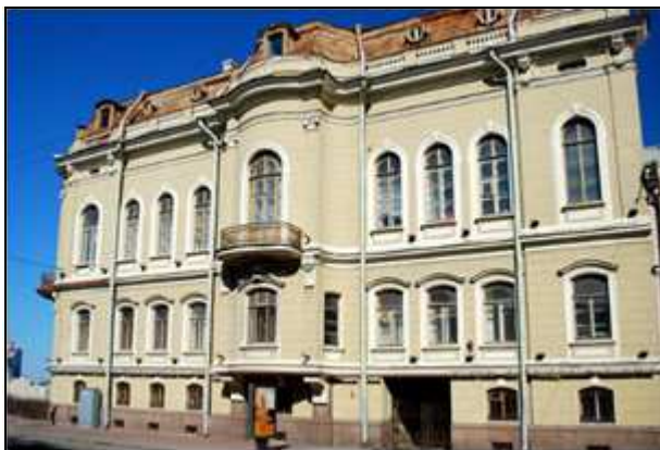
Фото 1. Общий вид здания со стороны Гагаринской улицы
