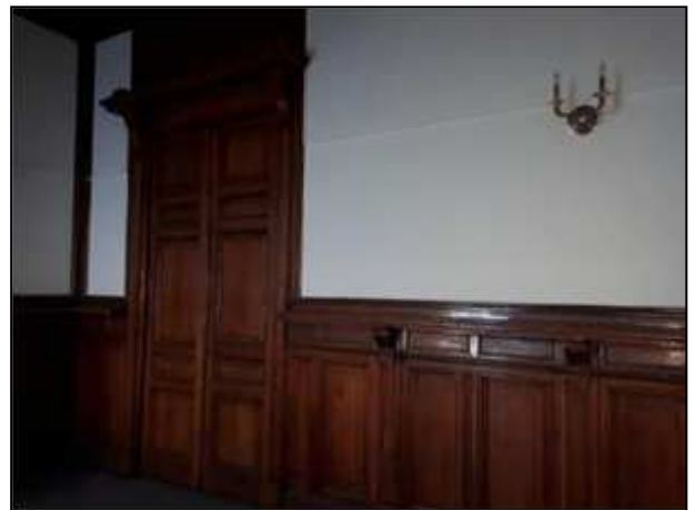
Фото 121. Состояние административных помещений на 2 этаже
