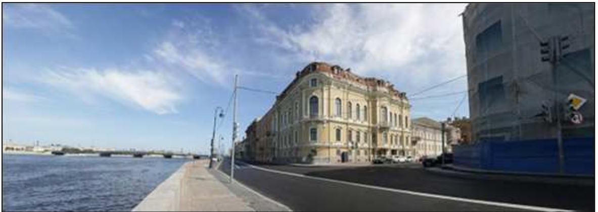
Фото 3. Общий вид здания и набережной Кутузова
