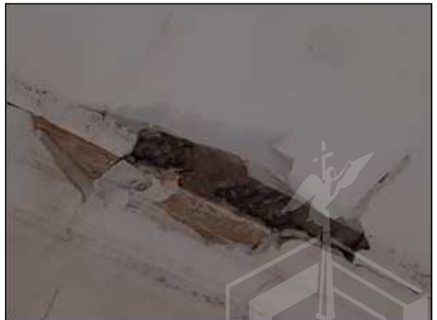
Фото 193. Состояние помещений 3 парадного этажа
