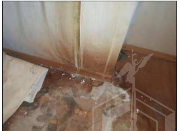
Фото 185. Состояние помещений 3 парадного этажа
