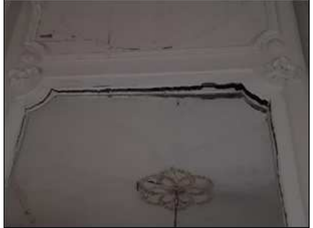
Фото 197. Состояние помещений 3 парадного этажа
