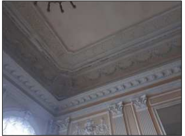
Фото 155. Сохранившиеся интерьеры 3 парадного этажа
