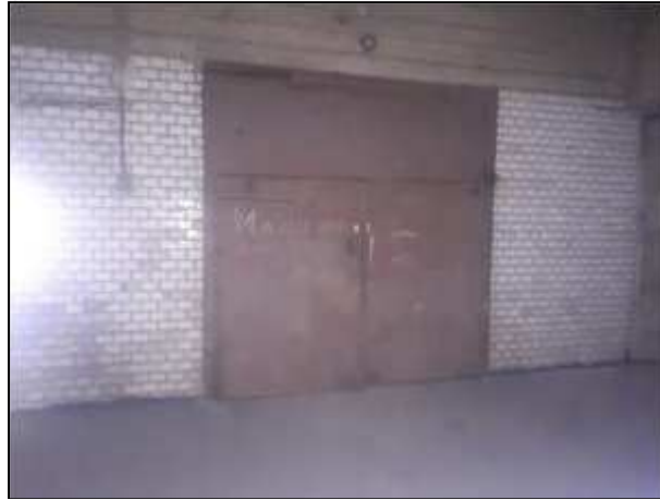
Фото 55. Вход в помещение 11-Н (гараж)
