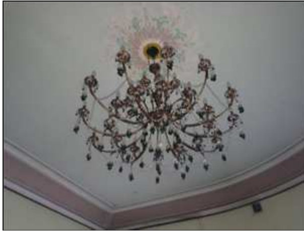
Фото 126. Состояние административных помещений на 2 этаже
