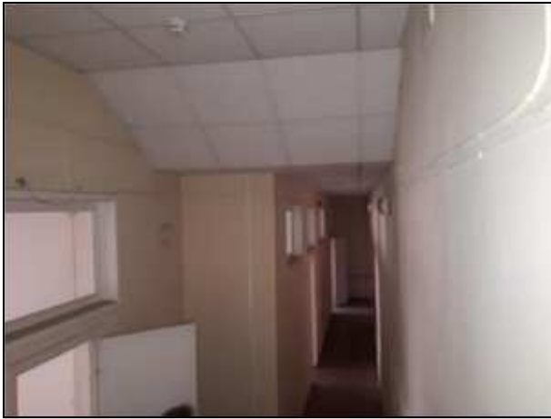
Фото 92. Состояние административных помещений на 2 этаже
