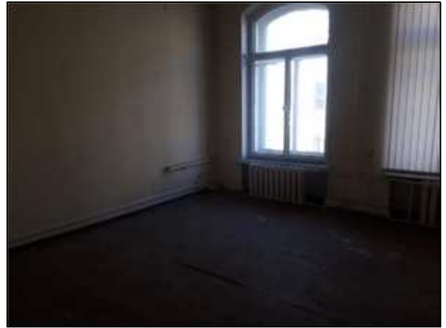
Фото 93. Состояние административных помещений на 2 этаже
