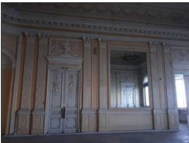
Фото 152. Сохранившиеся интерьеры 3 парадного этажа
