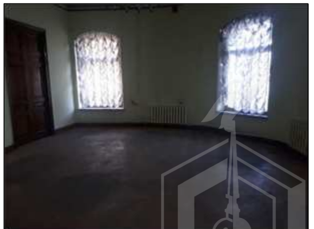
Фото 115. Состояние административных помещений на 2 этаже
