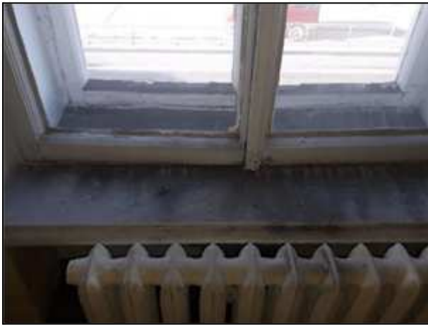
Фото 96. Состояние административных помещений на 2 этаже
