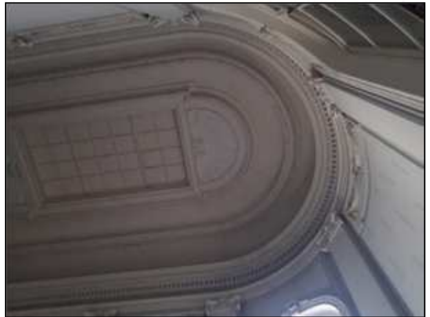
Фото 143. Парадная лестница в здании
