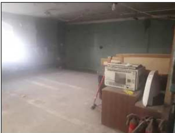
Фото 56. Помещение 11-Н, общий вид (гараж)
