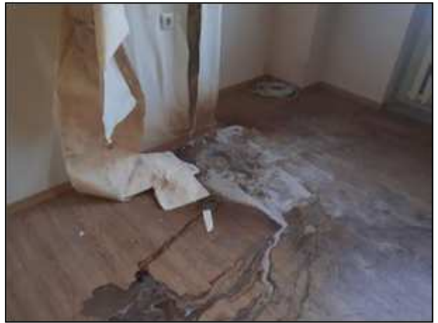
Фото 183. Состояние помещений 3 парадного этажа
