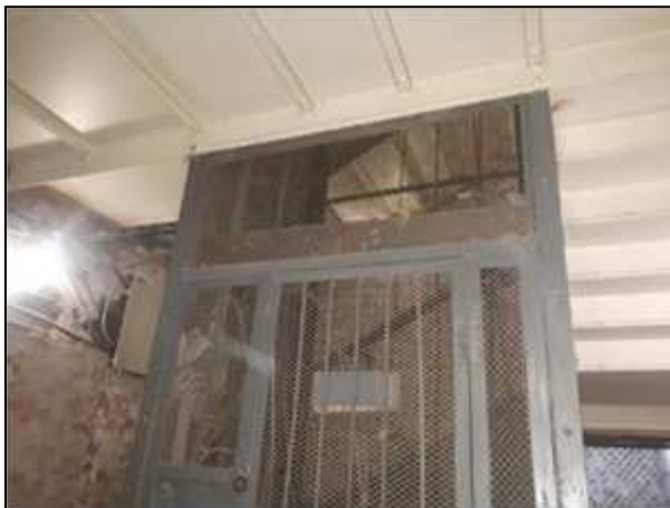
Фото 224. Лифт в здании (не используется)
