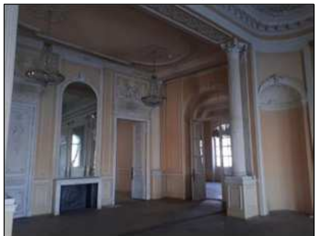
Фото 151. Сохранившиеся интерьеры 3 парадного этажа
