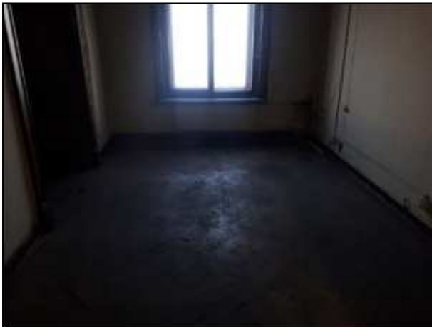
Фото 114. Состояние административных помещений на 2 этаже
