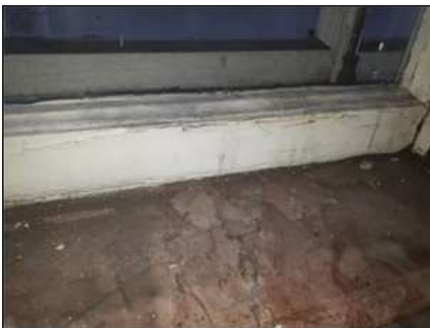
Фото 190. Состояние помещений 3 парадного этажа
