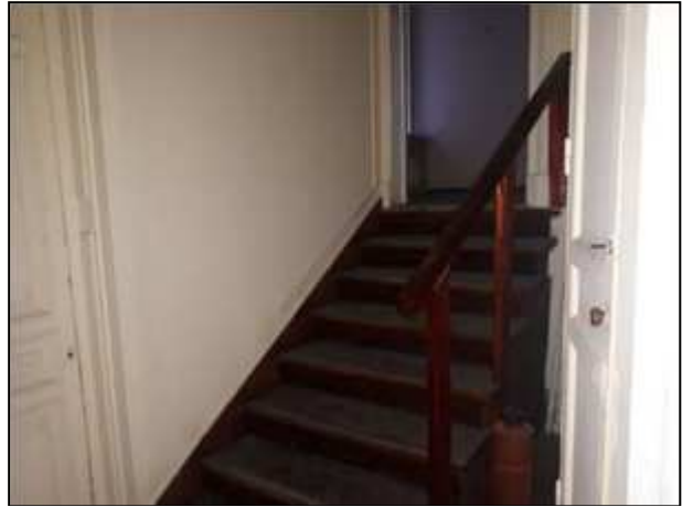
Фото 111. Состояние административных помещений на 2 этаже
