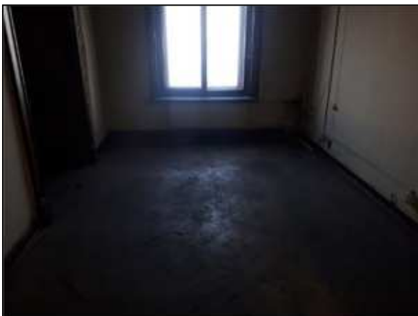
Фото 114. Состояние административных помещений на 2 этаже
