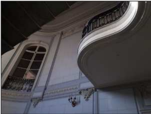
Фото 135. Парадная лестница в здании
