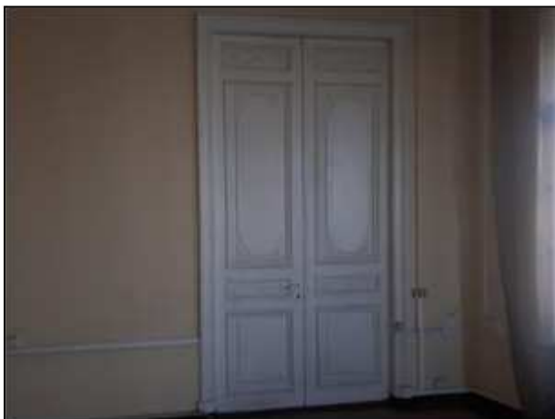
Фото 106. Состояние административных помещений на 2 этаже
