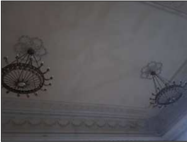
Фото 154. Сохранившиеся интерьеры 3 парадного этажа
