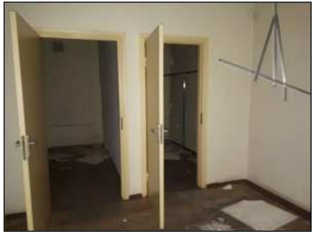
Фото 89. Состояние административных помещений на 2 этаже
