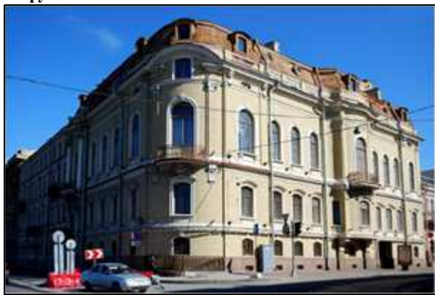
Фото 2. Общий вид здания со стороны наб. Кутузова / Гагаринской улицы
