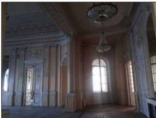
Фото 171. Сохранившиеся интерьеры 3 парадного этажа
