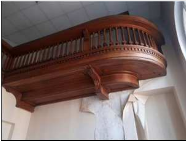
Фото 178. Сохранившиеся интерьеры 3 парадного этажа
