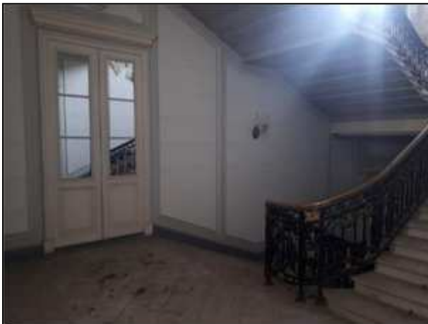
Фото 127. Парадная лестница в здании
