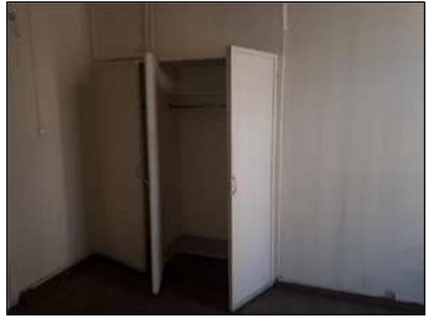
Фото 101. Состояние административных помещений на 2 этаже
