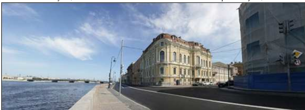
Фото 3. Общий вид здания и набережной Кутузова
