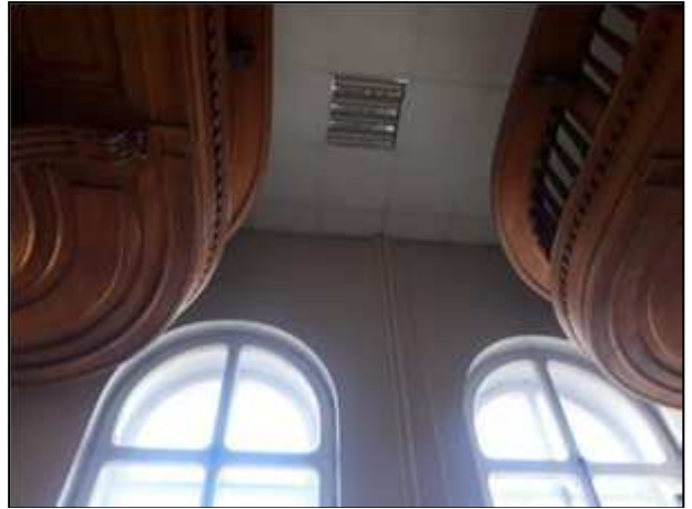
Фото 181. Сохранившиеся интерьеры 3 парадного этажа
