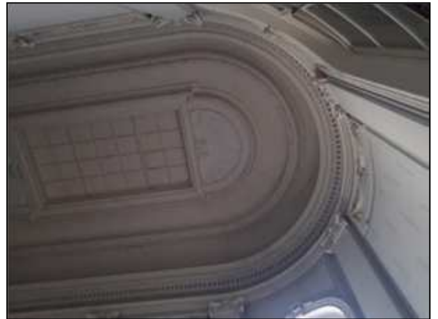
Фото 143. Парадная лестница в здании
