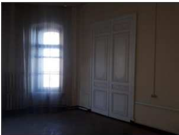
Фото 104. Состояние административных помещений на 2 этаже
