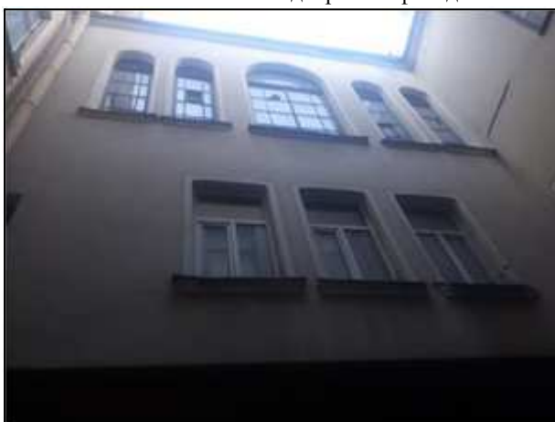
Фото 20. Состояние дворовых фасадов
