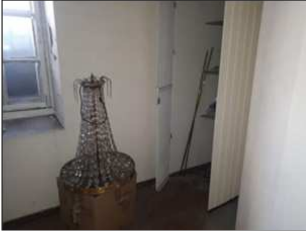
Фото 78. Состояние административных помещений на 2 этаже
