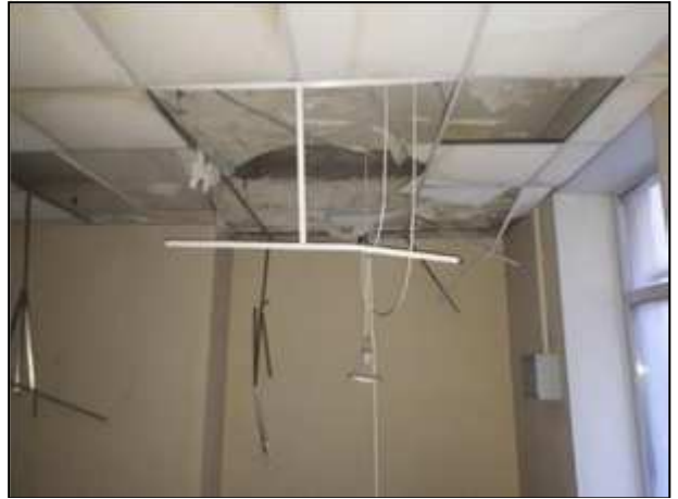
Фото 87. Состояние административных помещений на 2 этаже
