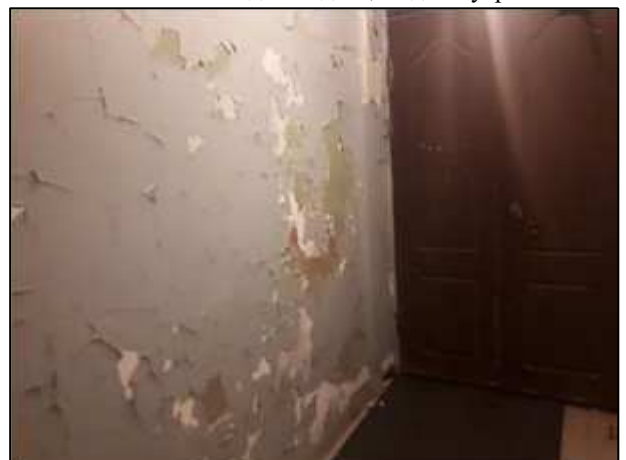
Фото 28. Вход в подвал, вид изнутри
