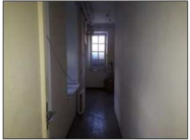
Фото 77. Состояние административных помещений на 2 этаже
