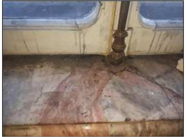
Фото 157. Сохранившиеся интерьеры 3 парадного этажа
