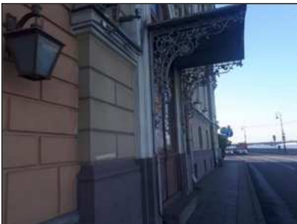
Фото 6. Вход в здание со стороны набережной Кутузова – не используется
