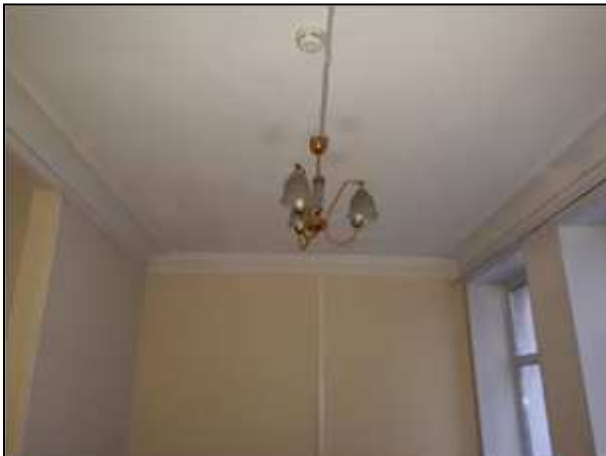
Фото 82. Состояние административных помещений на 2 этаже
