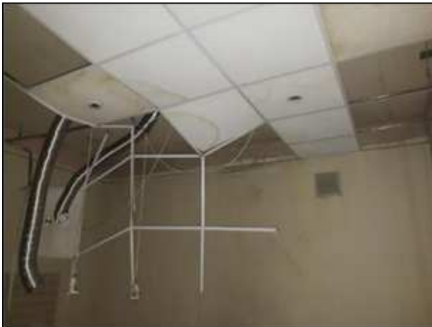
Фото 90. Состояние административных помещений на 2 этаже
