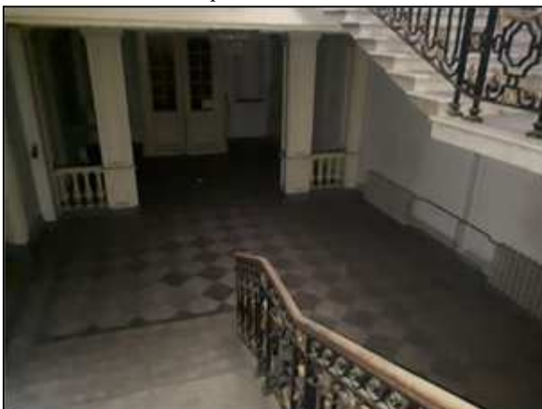
Фото 129. Вход в здание (вид изнутри)
