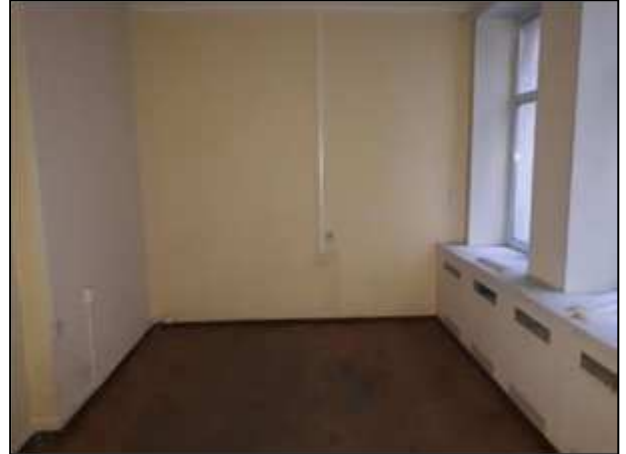
Фото 81. Состояние административных помещений на 2 этаже
