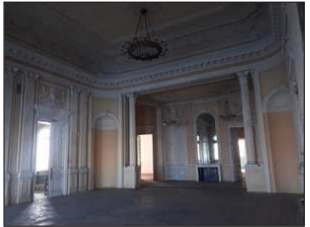
Фото 159. Сохранившиеся интерьеры 3 парадного этажа
