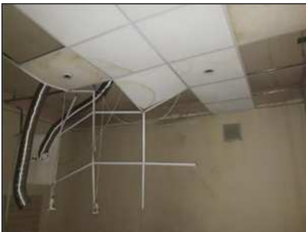
Фото 90. Состояние административных помещений на 2 этаже
