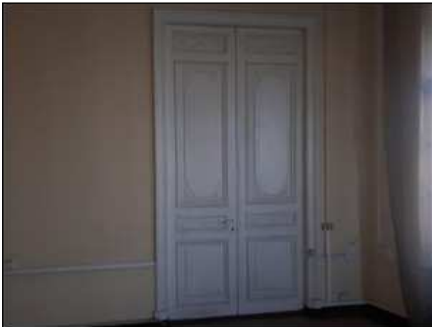
Фото 106. Состояние административных помещений на 2 этаже
