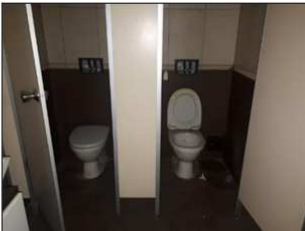
Фото 72. Санузлы на 2 этаже
