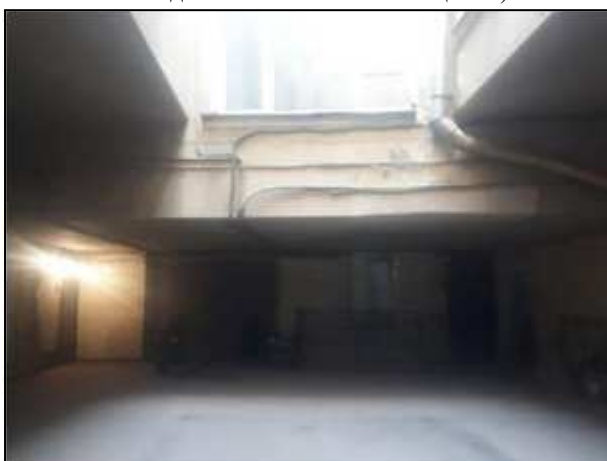
Фото 18. Состояние дворовых фасадов
