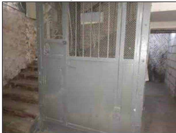
Фото 225. Лифт в здании (не используется)
