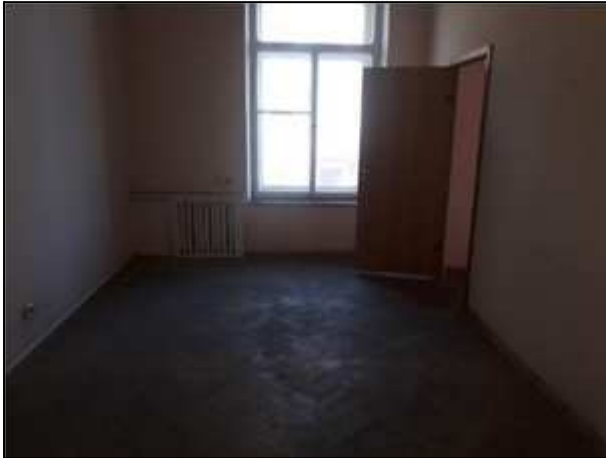
Фото 110. Состояние административных помещений на 2 этаже
