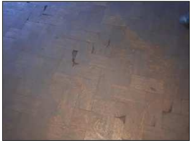
Фото 113. Состояние административных помещений на 2 этаже
