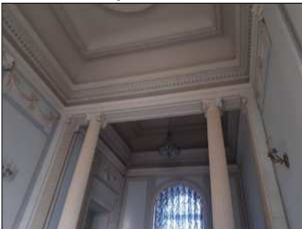
Фото 144. Парадная лестница в здании
