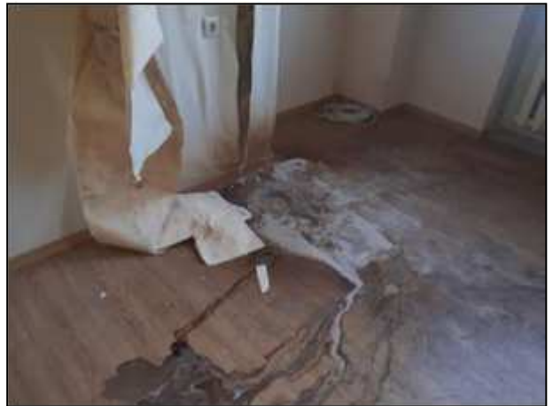
Фото 183. Состояние помещений 3 парадного этажа
