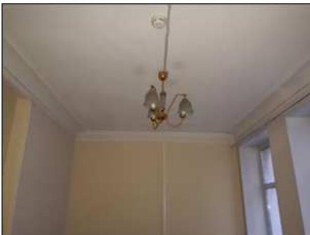
Фото 82. Состояние административных помещений на 2 этаже
