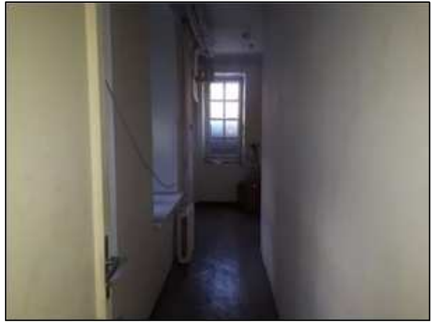
Фото 77. Состояние административных помещений на 2 этаже
