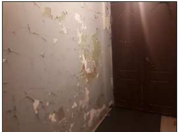
Фото 28. Вход в подвал, вид изнутри
