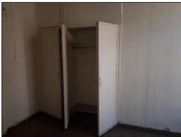
Фото 101. Состояние административных помещений на 2 этаже
