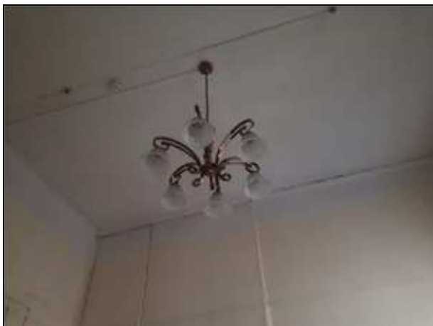
Фото 102. Состояние административных помещений на 2 этаже
