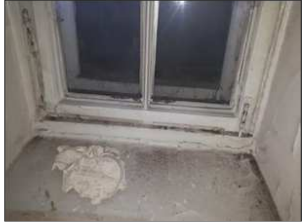
Фото 79. Состояние административных помещений на 2 этаже
