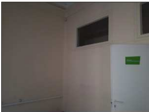
Фото 105. Состояние административных помещений на 2 этаже
