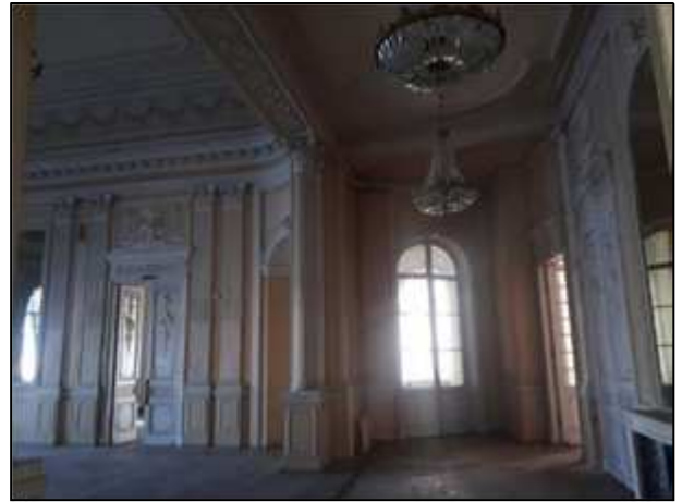
Фото 171. Сохранившиеся интерьеры 3 парадного этажа
