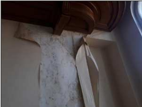
Фото 184. Состояние помещений 3 парадного этажа
