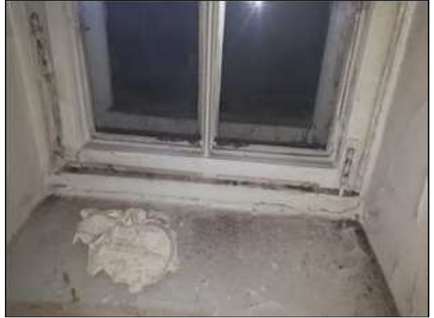
Фото 79. Состояние административных помещений на 2 этаже
