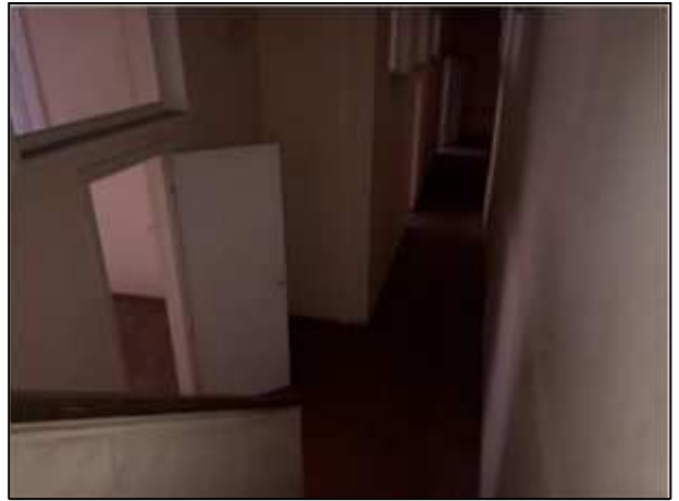
Фото 85. Состояние административных помещений на 2 этаже
