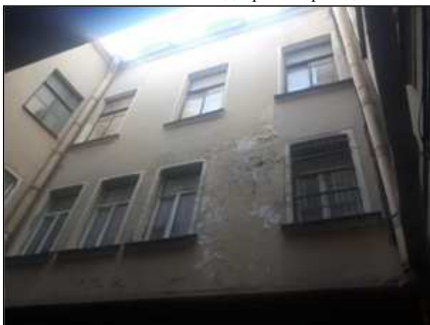
Фото 22. Состояние дворовых фасадов
