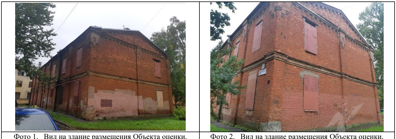
Фото 1. Вид на здание размещения Объекта оценки.
