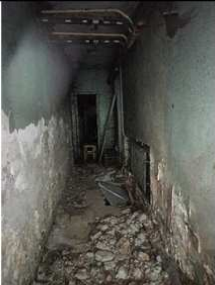
Фото №11 Внутреннее состояние Объекта оценки
