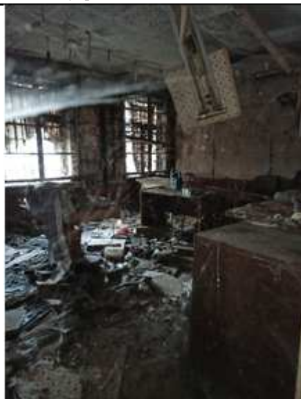
Фото №10 Внутреннее состояние Объекта оценки
