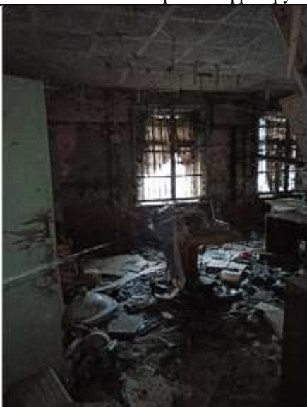
Фото №9 Внутреннее состояние Объекта оценки
