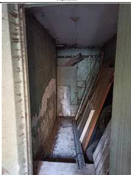
Фото №5 Помещение около входа
