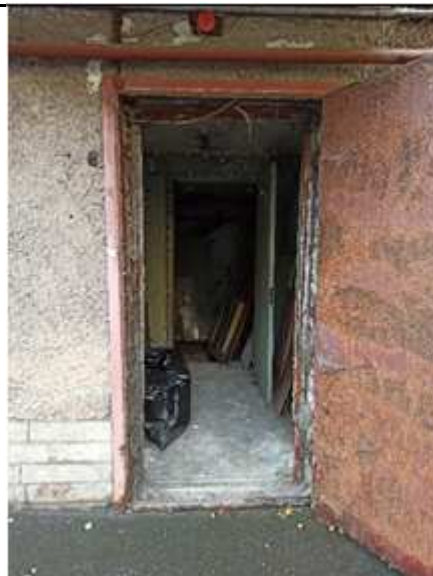
Фото №4 Вход в помещение
