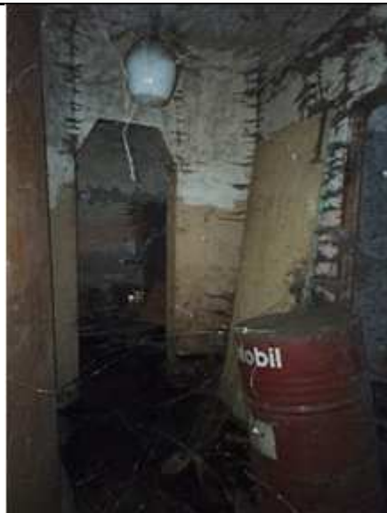
Фото №8 Внутреннее состояние Объекта оценки
