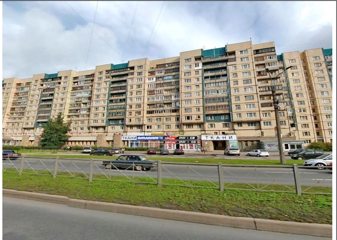
Вил на здание по адресу: Санкт-Петербург, проспект Косыгина, дом 26, корпус 1, литера А
