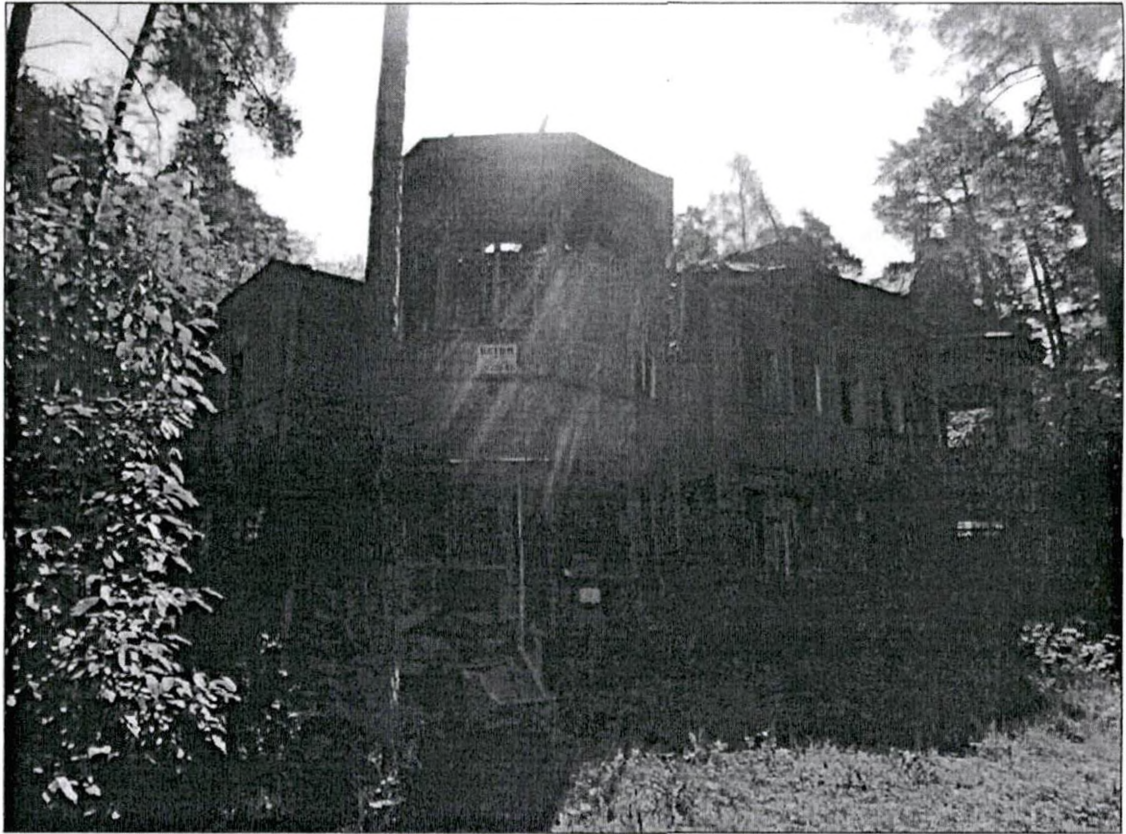
2. "Загородный дом Л.А. Змигродского". Вид с северо-запада.
