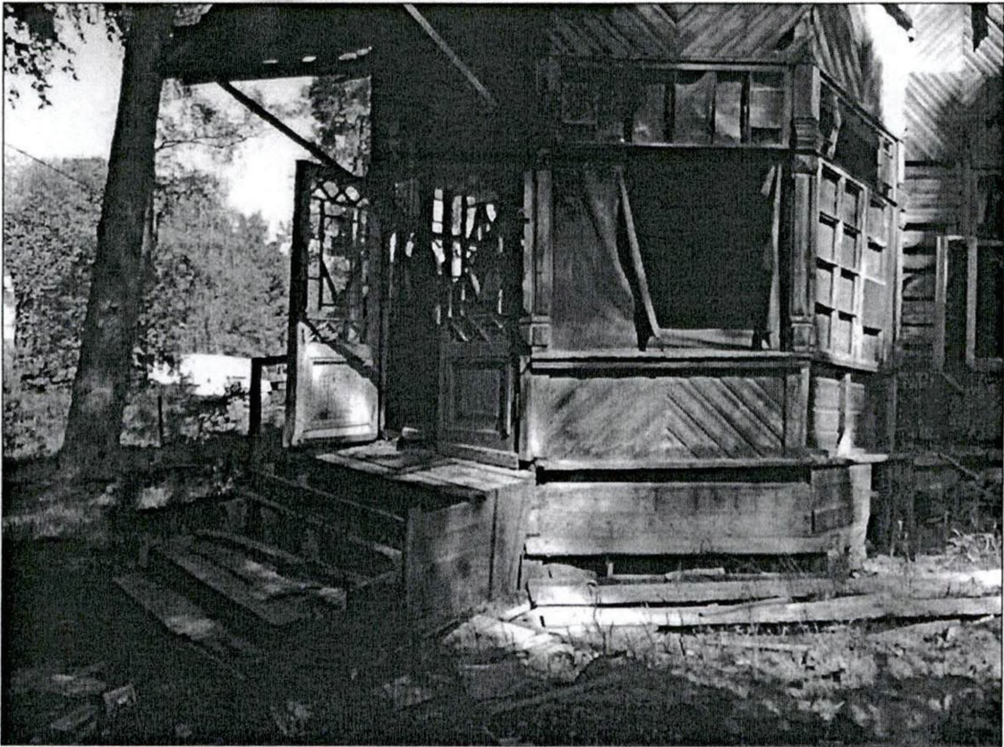
6. "Загородный дом Л.А. Змигродского". Юго-западное крыльцо.
