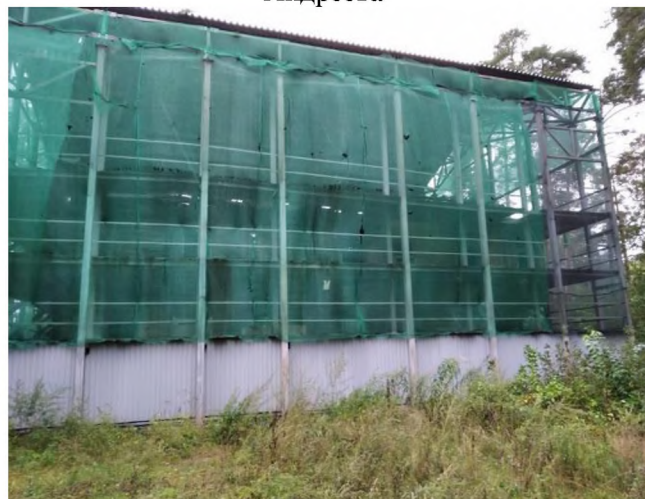
Фото 4. Общий вид оцениваемого здания со двора
