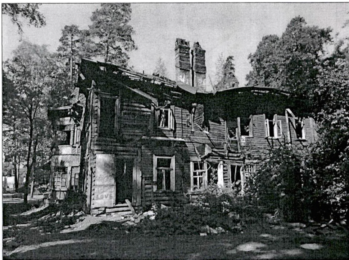
4. "Загородный дом Л.А. Змигородского". Восточный фасад.
