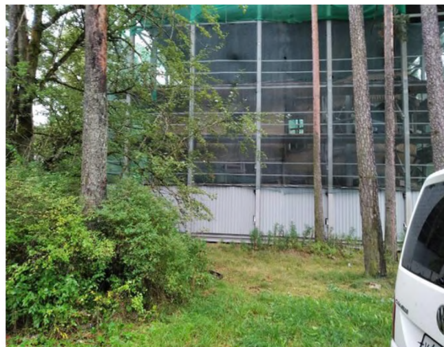
Фото 2. Общий вид оцениваемого здания с улицы Андреева
