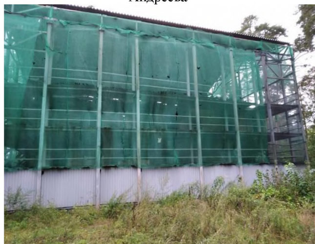
Фото 4. Общий вид оцениваемого здания со двора
