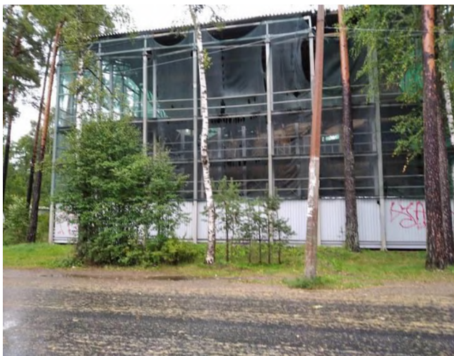
Фото 1. Общий вид оцениваемого здания со стороны улицы Андреева
