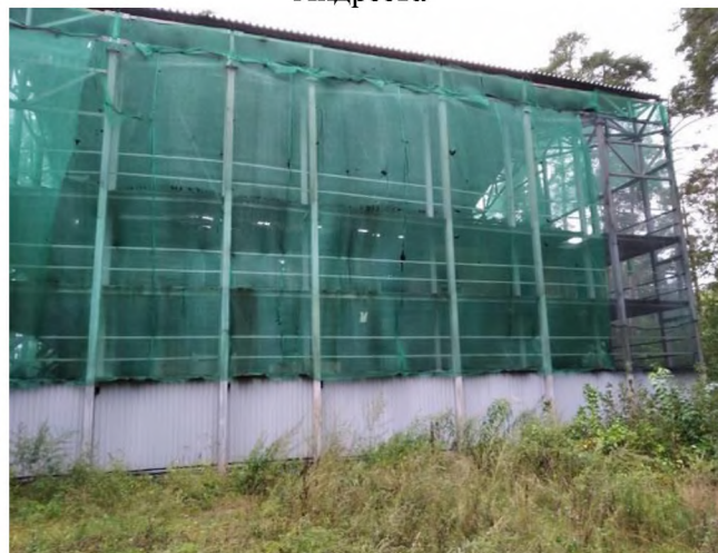
Фото 4. Общий вид оцениваемого здания со двора
