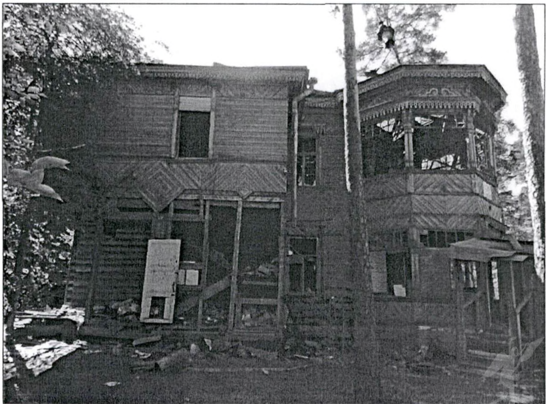
3. "Загородный дом Л.А. Змигродского". Северный фасад.
