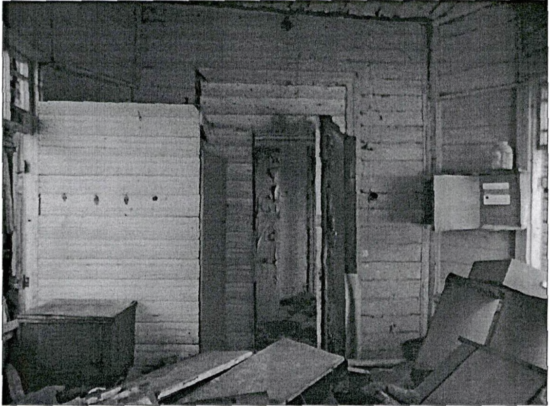
9. Северо-западная веранда в уровне первого этажа.
