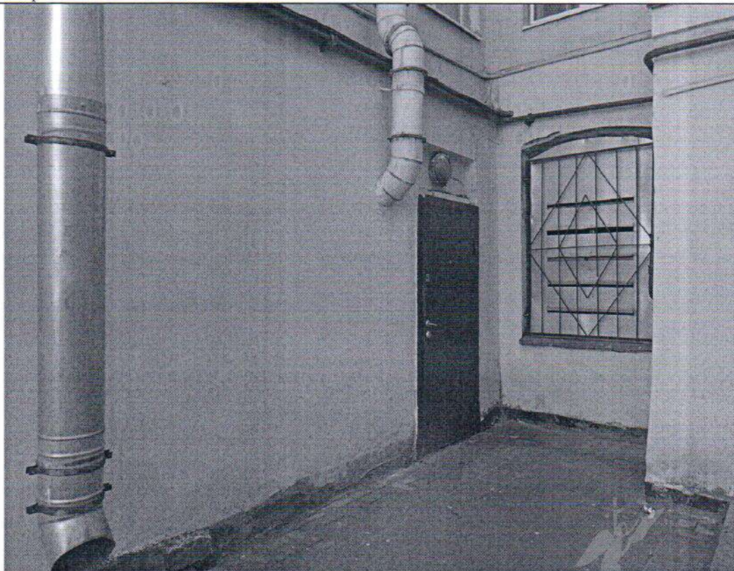
Описание: Вход на Объект со двора.
