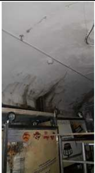
Фото №15 Внутреннее состояние Объекта оценки
