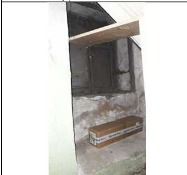
Фото №27 Оконный проем Объекта оценки
