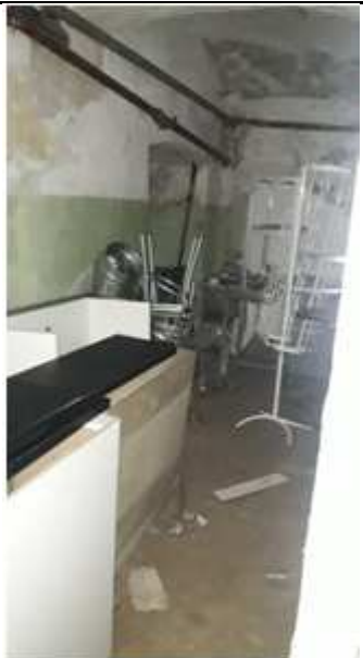
Фото №17 Внутреннее состояние Объекта оценки
