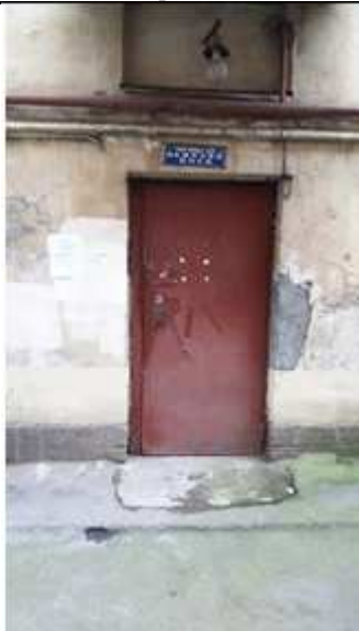
Фото №9 Вход в подъезд жилого дома во дворе Объекта оценки
