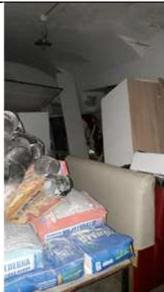
Фото №32 Внутреннее состояние Объекта оценки
