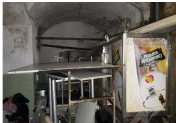
Фото №12 Внутреннее состояние Объекта оценки
