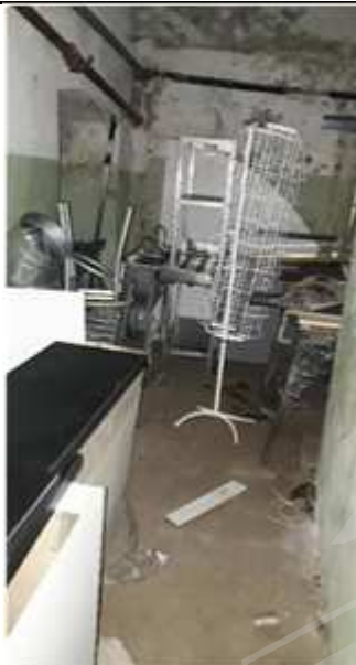
Фото №18 Внутреннее состояние Объекта оценки
