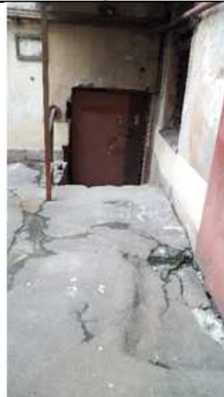
Фото №10 Вход в соседнее помещение
