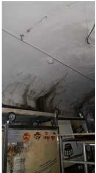
Фото №15 Внутреннее состояние Объекта оценки
