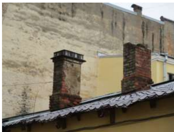
Фото 6. Вид здания, в котором расположен Объект оценки, со двора
