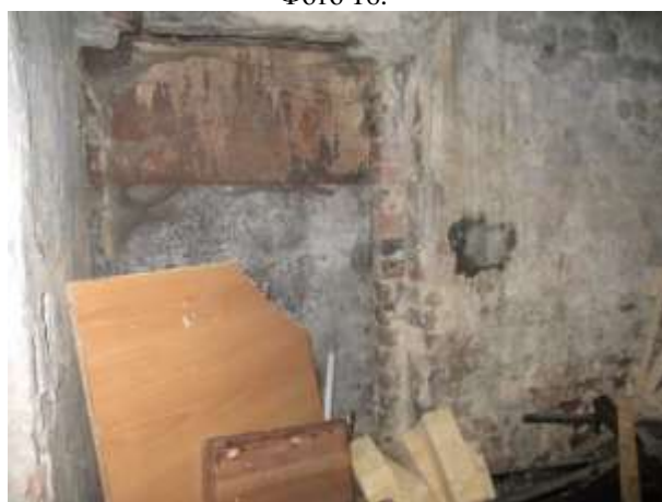
Фото 18. Оконный проем заложен, вид из помещения
