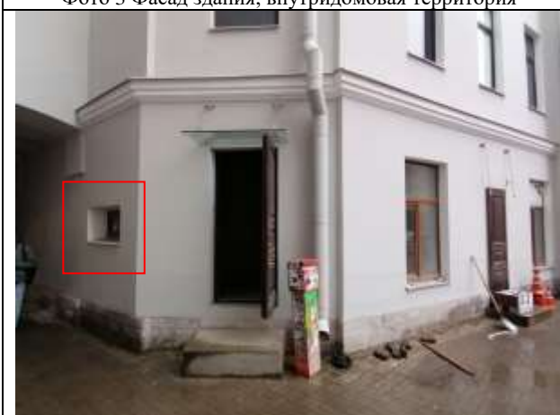
Фото 5 Фасад здания, внутридомовая территория, окно помещения
