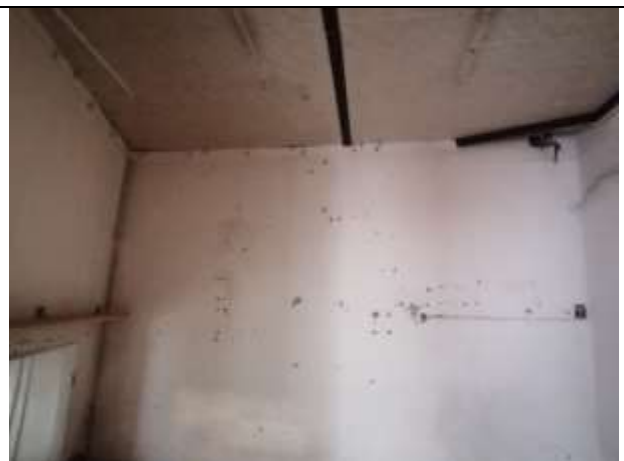
Фото 10 Общий вид и состояние помещения
