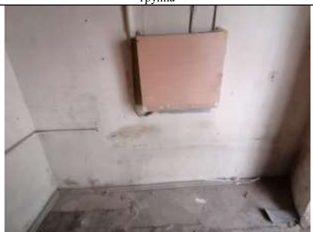
Фото 14 Общий вид и состояние помещения
