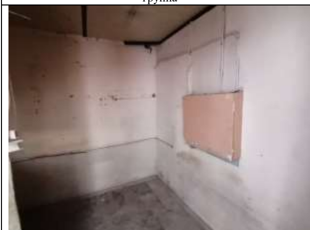
Фото 13 Общий вид и состояние помещения
