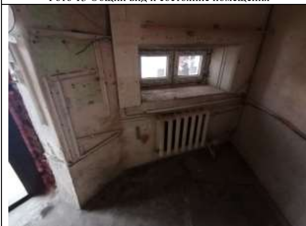
Фото 15 Общий вид и состояние помещения, окно
