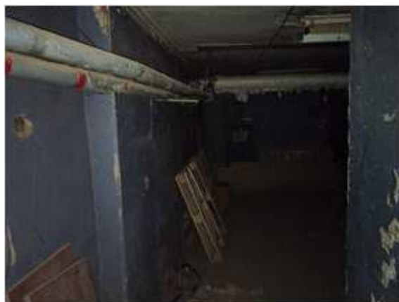
Фото №16 Помещение на цокольном этаже
