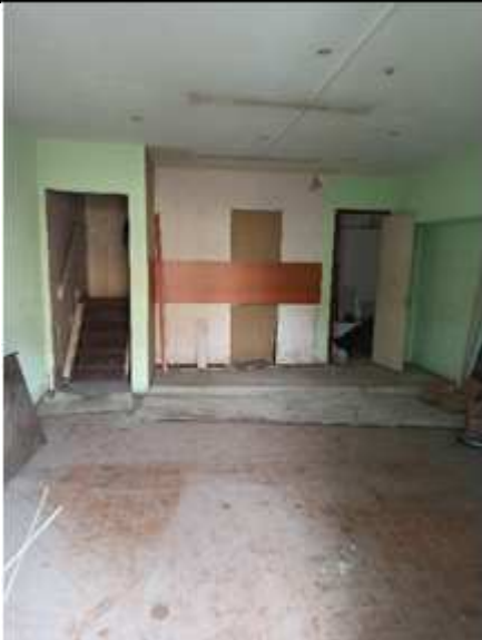
Фото №7 Помещение на цокольном этаже
