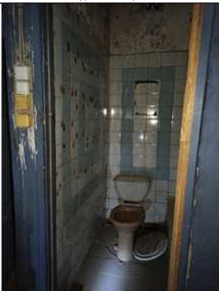
Фото №15 Сан. узел на цокольном этаже
