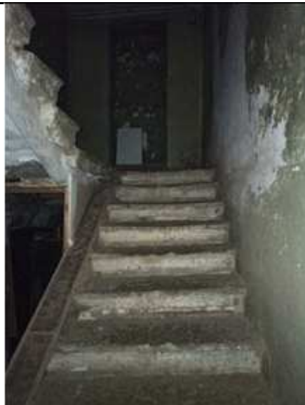
Фото №32 Лестница между первым и цокольным этажами
