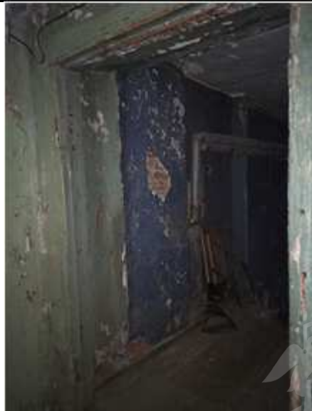
Фото №12 Помещение на цокольном этаже
