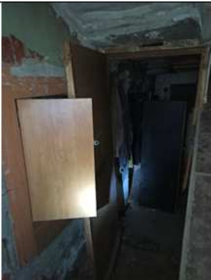
Фото №13 Кладовая на цокольном этаже
