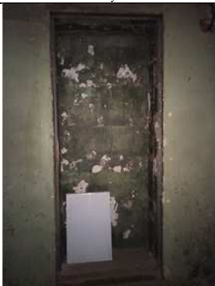
Фото №33 Заложенный дверной проем
