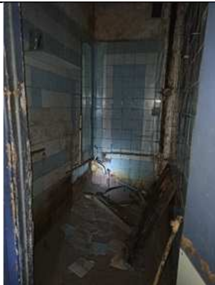
Фото №14 Сан. узел на цокольном этаже
