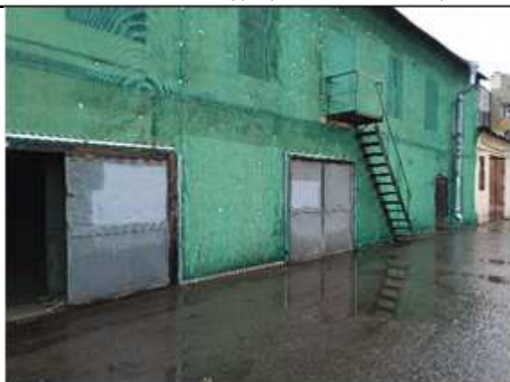
Фото №3 Входы в помещение
