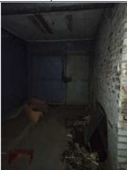
Фото №17 Помещение на цокольном этаже
