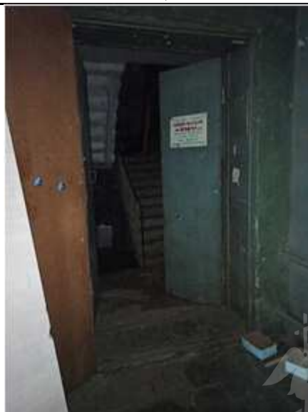
Фото №30 Выход на лестницу с 1 этажа
