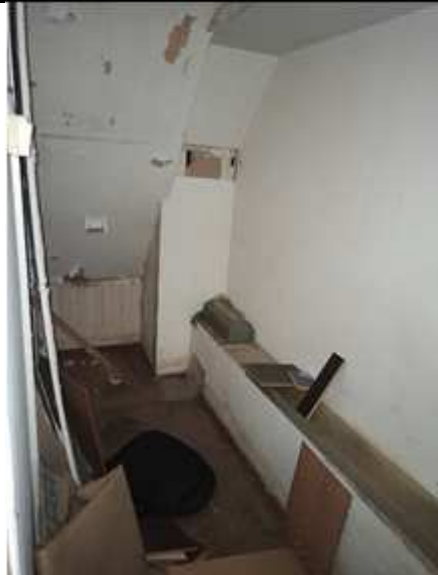
Фото №8 Кладовая на цокольном этаже
