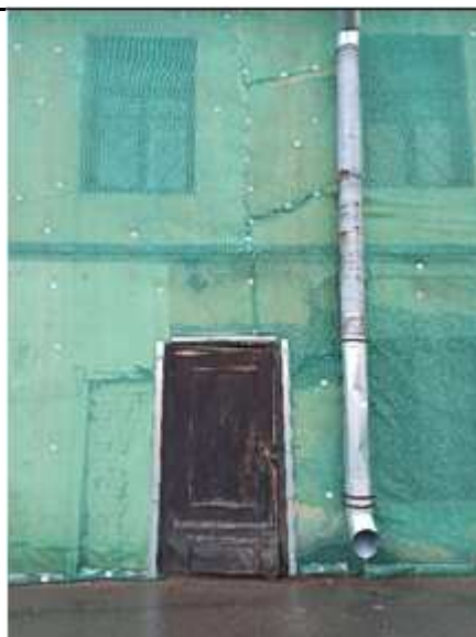
Фото №2 Вход в помещение
