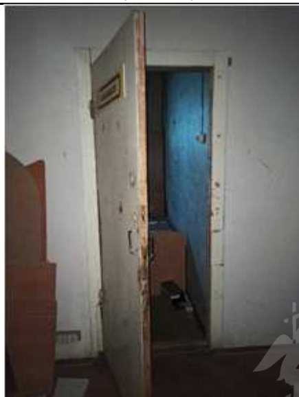
Фото №18 Вход во внутреннее помещение на 1 этаже
