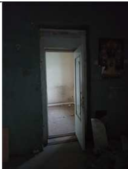
Фото №26 Вход в помещение на 1 этаже
