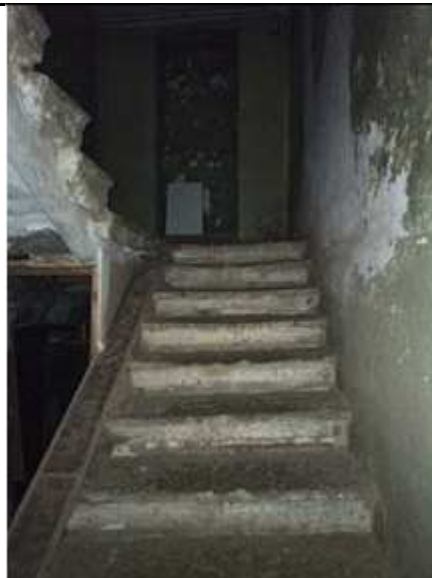
Фото №32 Лестница между первым и цокольным этажами
