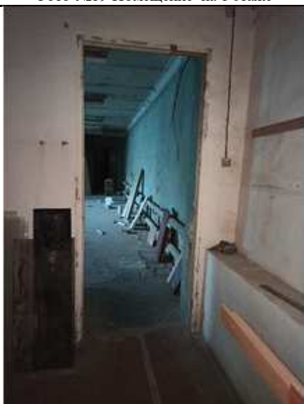
Фото №21 Вход во внутреннее помещение на 1 этаже
