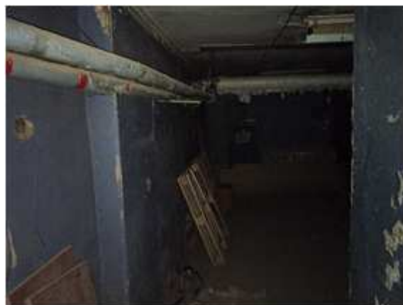
Фото №16 Помещение на цокольном этаже
