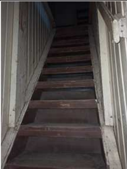
Фото №11 Лестница на первый этаж
