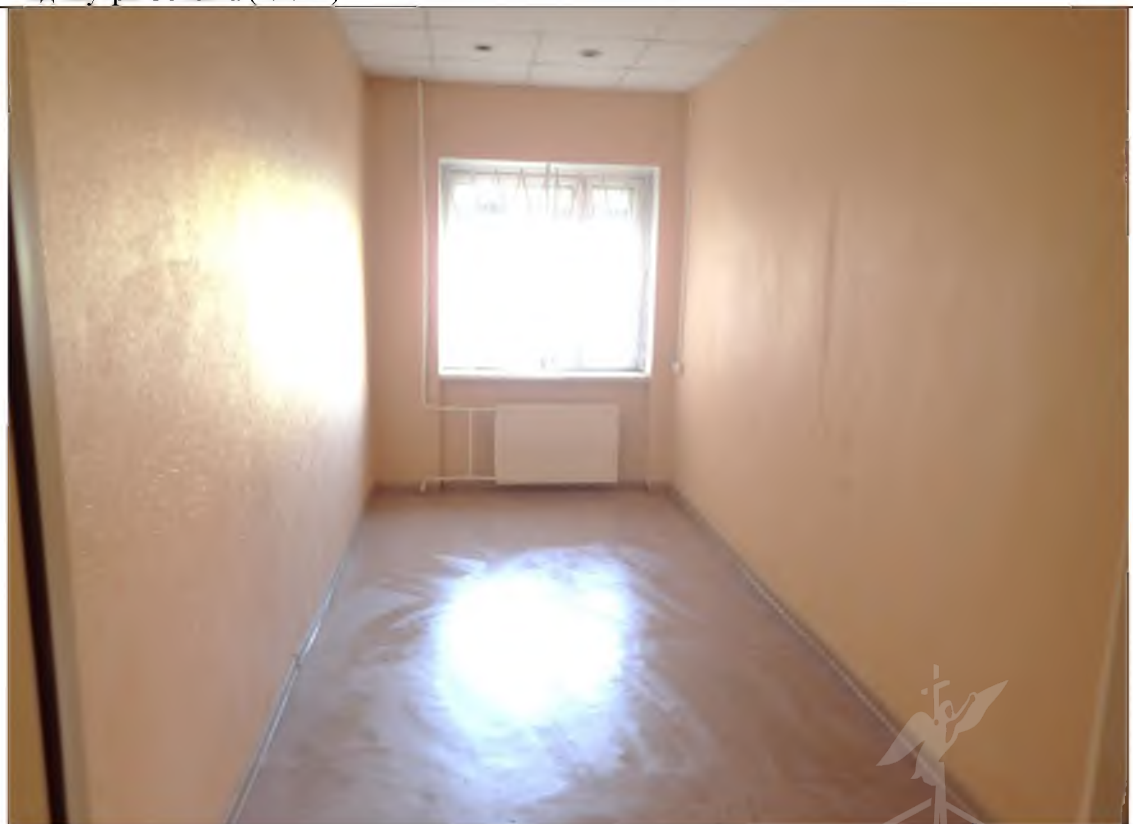
Описание: В ч.п. 9 Объекта в стене, обладающей признаками капитальности, оборудован оконный проем
