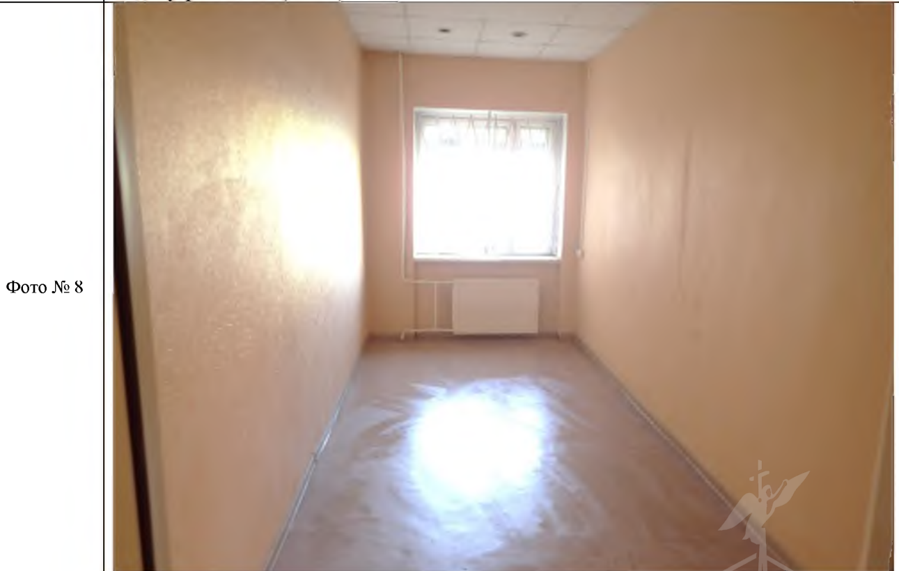
Описание: В ч.п. 9 Объекта в стене, обладающей признаками капитальности, оборудован оконный проем
