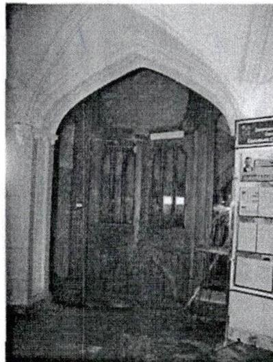
заполнение дверного проема - деревянное, полусветлое четырехчастное, филленчатое с фрамугой и застекленными боковыми частями криволинейных очертаний;
