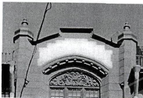
воротный проезд лучкового завершения, с профилированными ребрами по перекрытию и коваными воротами;
