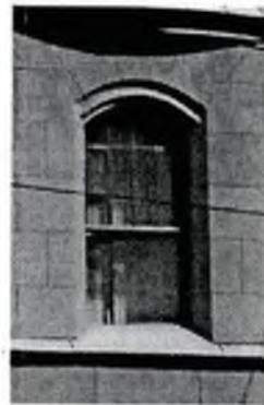
фигурная подоконная доска с шарообразными фиалами, архивольт со стилизованными кронштейнами растительного характера в оформлении оконных проемов 5-го этажа;
