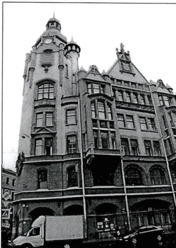
3. Фрагмент. Юго-восточный фасад.
