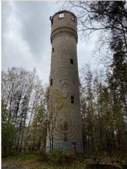
Фото №11: Водонапорная башня (лит. Б)
