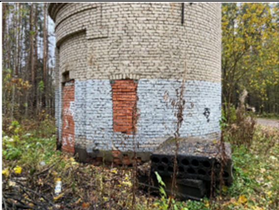
Фото №13 Водонапорная башня (лит. Б)
