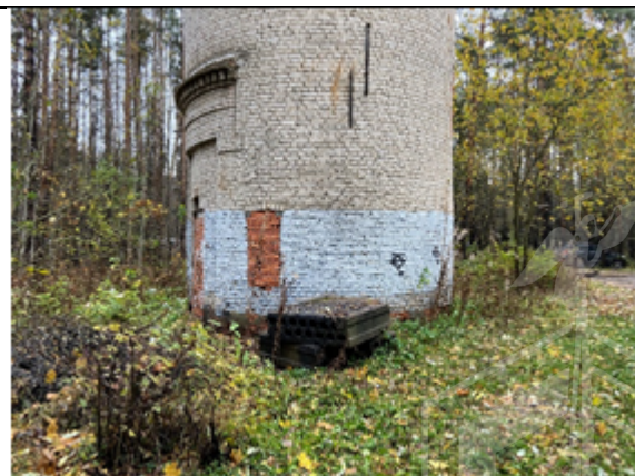
Фото №8. Заложенный оконный проем, лит. Б
