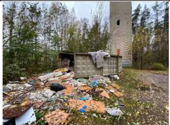
Фото №14: Водонапорная башня (лит. Б)
