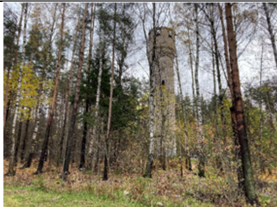
Фото №1: Вид на водонапорную башню (лит. Б)
