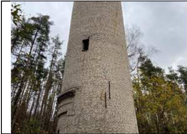
Фото №9: Водонапорная башня (лит. Б)
