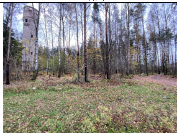
Фото №6. Вид на водонапорную башню (лит. Б)
