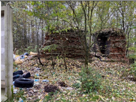
Фото №15: Здание шатра над арт. Скважиной (лит. А)
