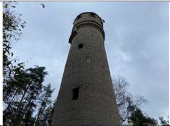
Фото №10: Водонапорная башня (лит. Б)
