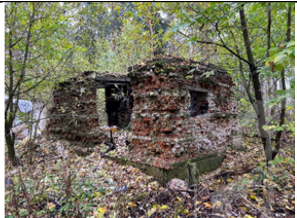
Фото №16: Здание шатра над арт. Скважиной (лит. А)
