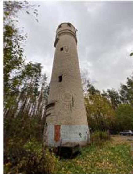
Фото №12: Водонапорная башня (лит. Б)
