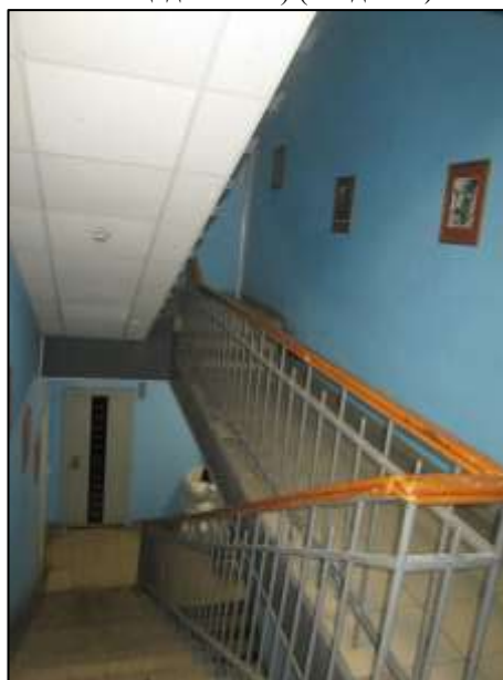
Фото 18. Лестница 3ЛК (Вход №3 в пом. 2-Н)
