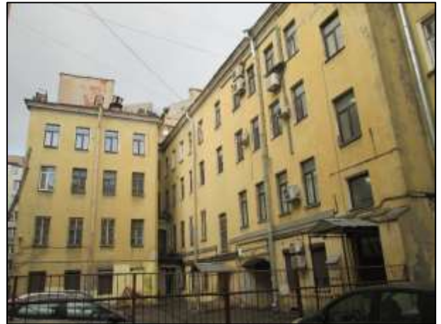
Фото 8. Общий вид дома со двора. 13 оконных проемов 2 этажа во двор
