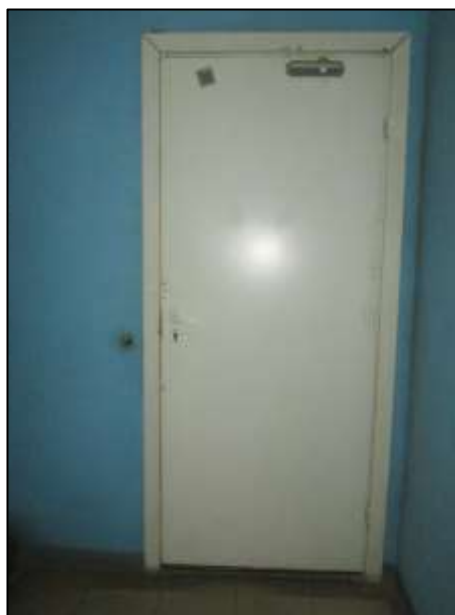
Фото 16. Входная дверь снаружи (с лестничной площадки 3ЛК ) (вход № 3)
