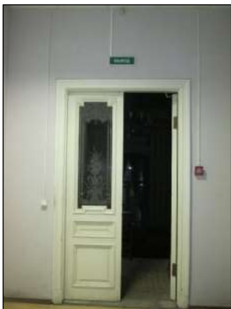
Фото 15. Входная дверь изнутри пом. 2-Н, на лестничную площадку 1ЛК (вход № 1)
