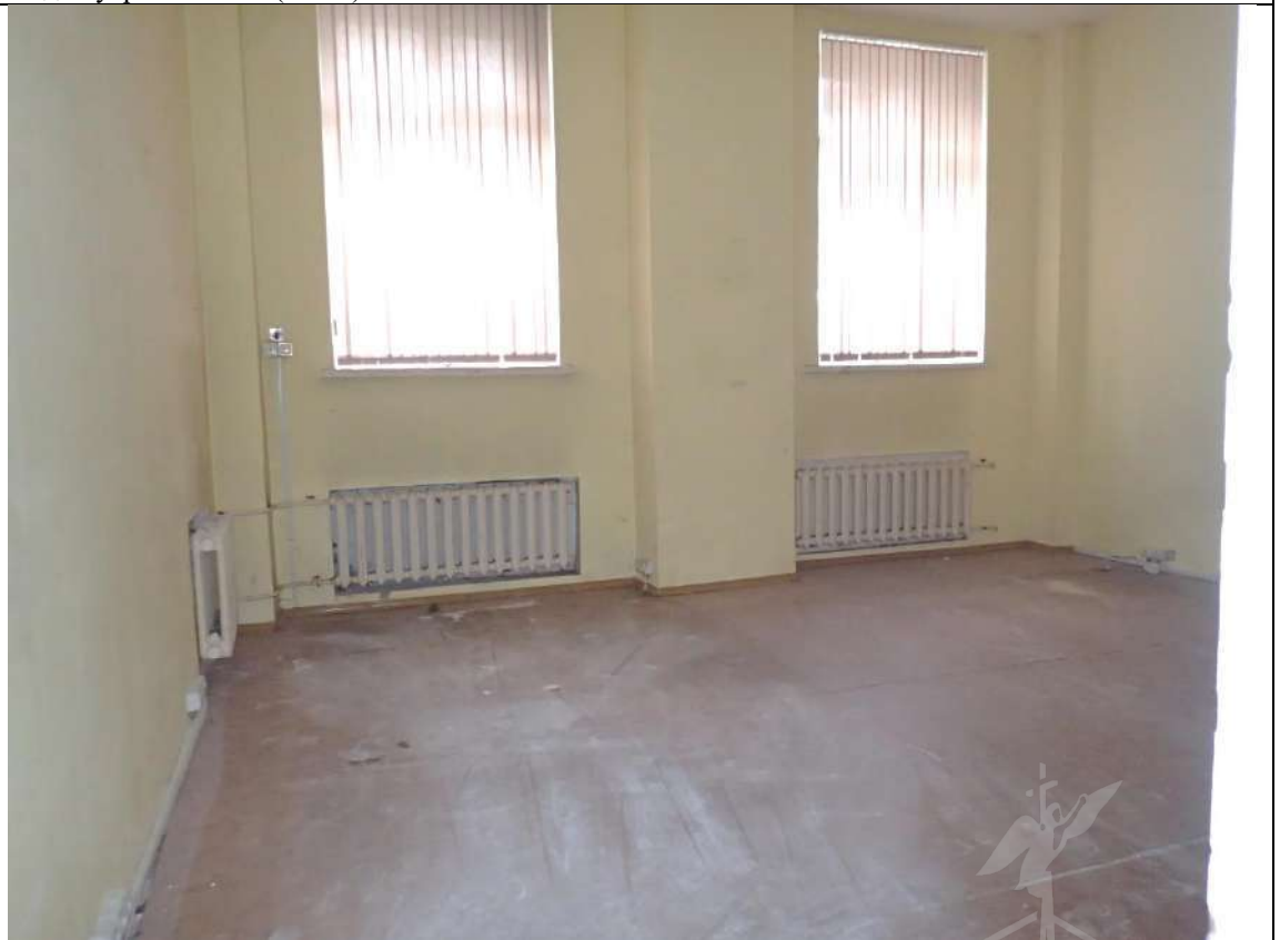
Описание: Вид внутри Объекта (ч.п. 7)
