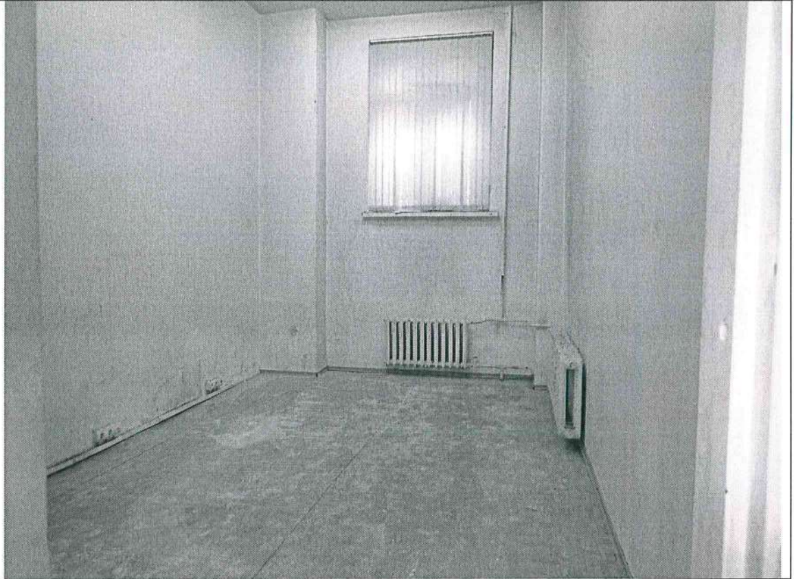
Описание: Вид внутри Объекта (ч.п. 6)
