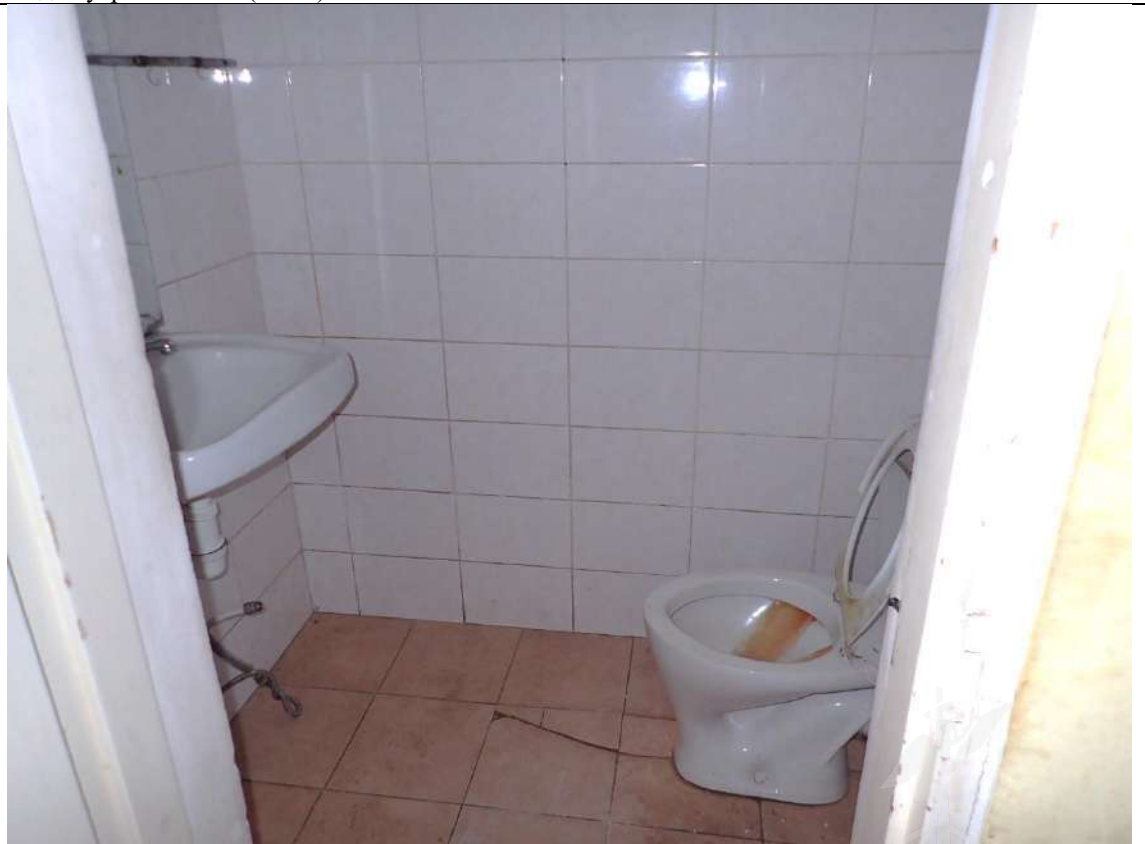
Описание: Вид внутри Объекта (ч.п. 3)
