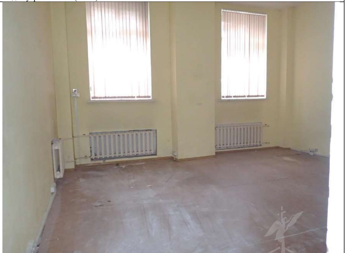
Описание: Вид внутри Объекта (ч.п. 7)
