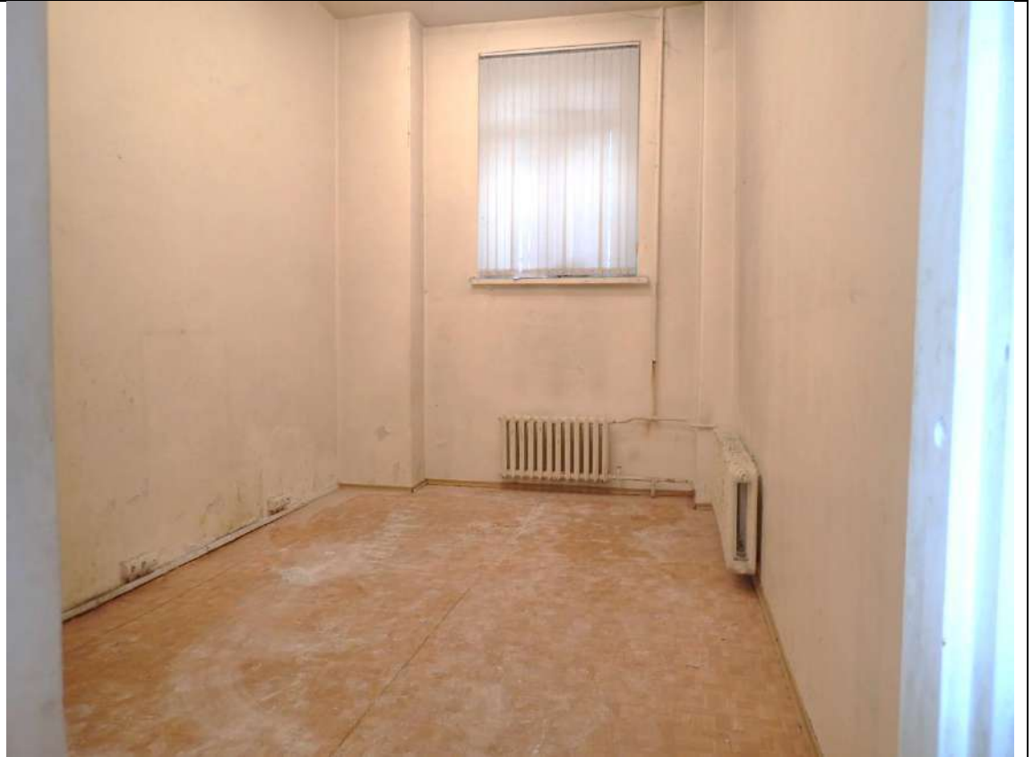
Описание: Вид внутри Объекта (ч.п. 6)
