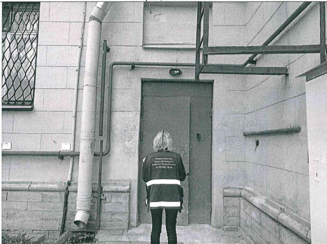
Описание: Вход на Объект (со двора)
