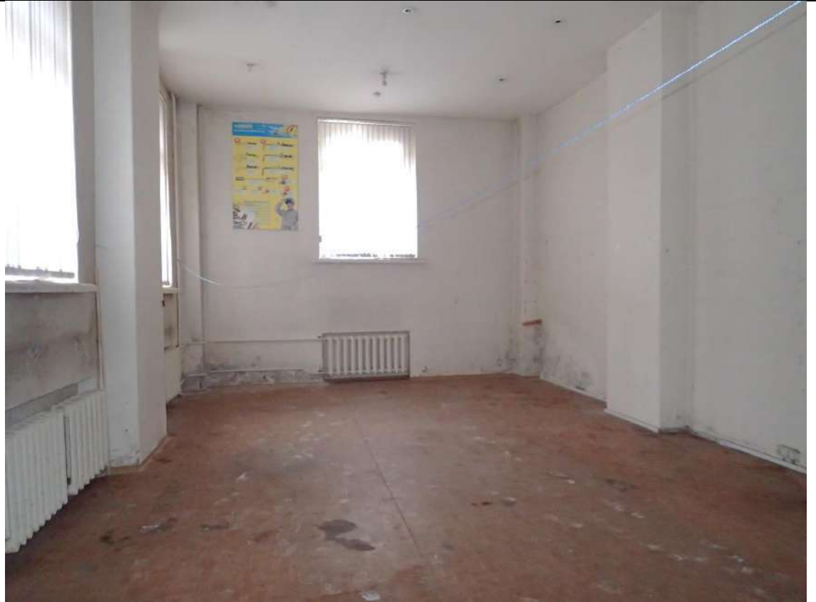
Описание: Вид внутри Объекта (ч.п. 8)
