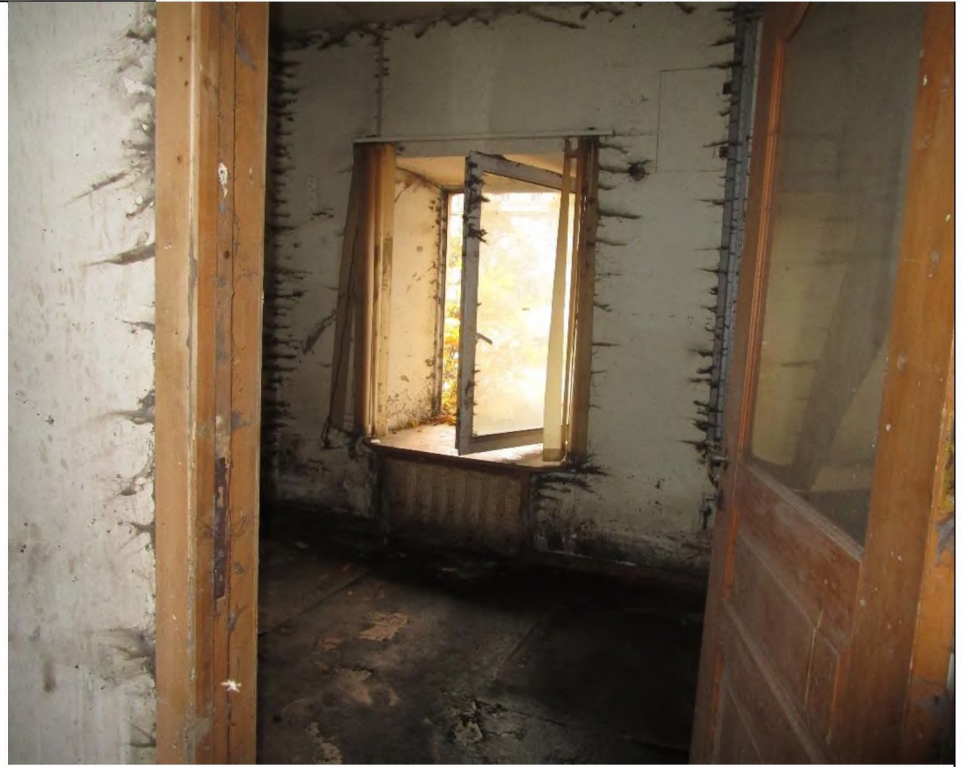
Описание: Вид внутри Объекта (ч.п. 4)
