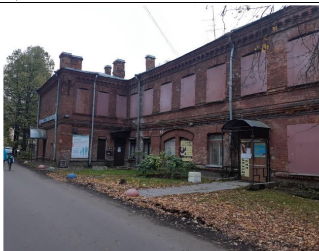
то 4. Вид здания, в котором расположен Объект оценки
