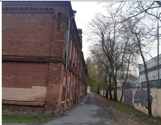
то 12. Вид здания, в котором расположен Объект оценки
