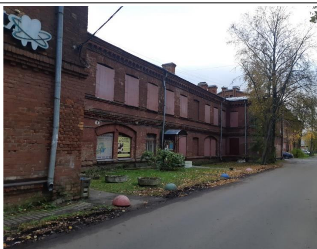
то 2. Вид здания, в котором расположен Объект оценки
