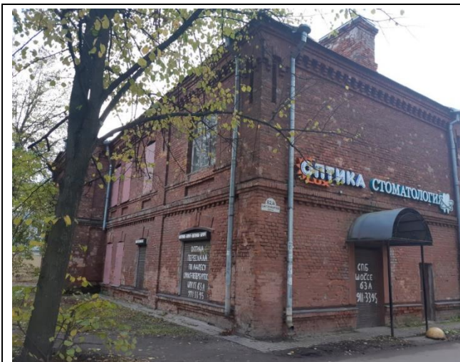
то 1. Вид здания, в котором расположен Объект оценки
