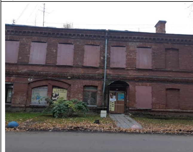
то 3. Вид здания, в котором расположен Объект оценки
