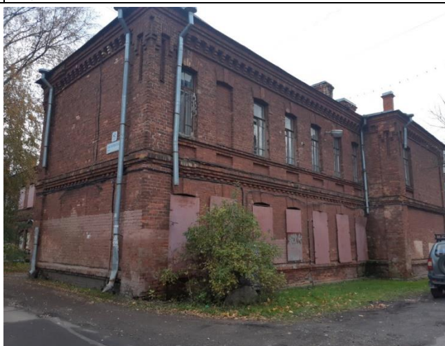
то 9. Вид здания, в котором расположен Объект оценки
