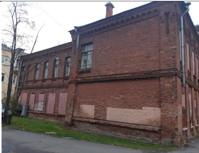
то 11. Вид здания, в котором расположен Объект оценки
