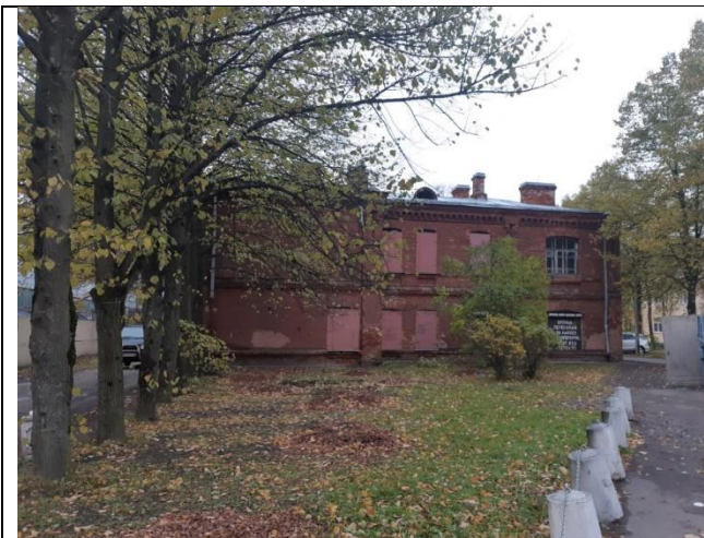
то 7. Вид здания, в котором расположен Объект оценки
