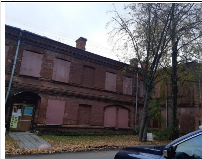
то 5. Вид здания, в котором расположен Объект оценки
