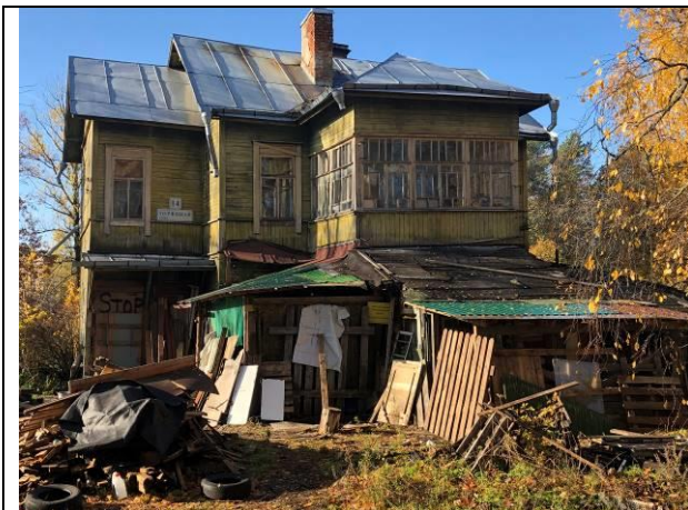
Фото 1. Вид на здание размещения Объекта оценки.
