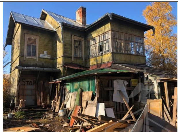
Фото 2. Вид на здание размещения Объекта оценки.
