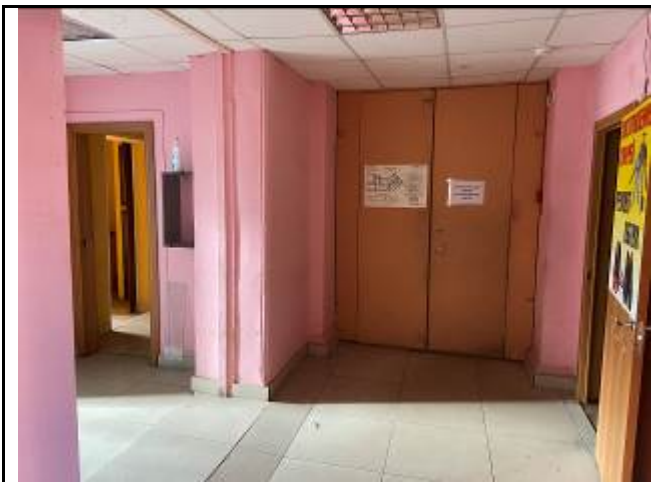
Фото №31 Входы в помещение
