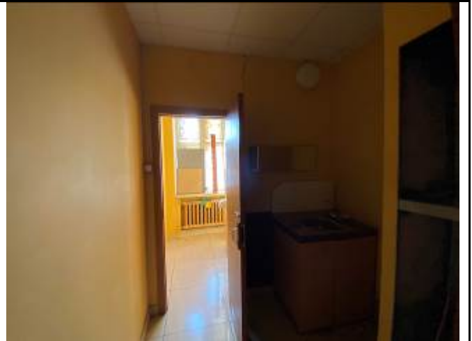
Фото №26 Входы в помещение
