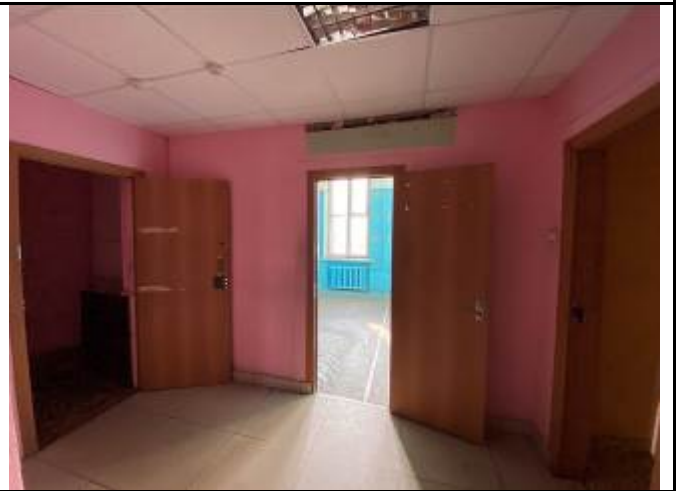
Фото №28. Входы в помещение
