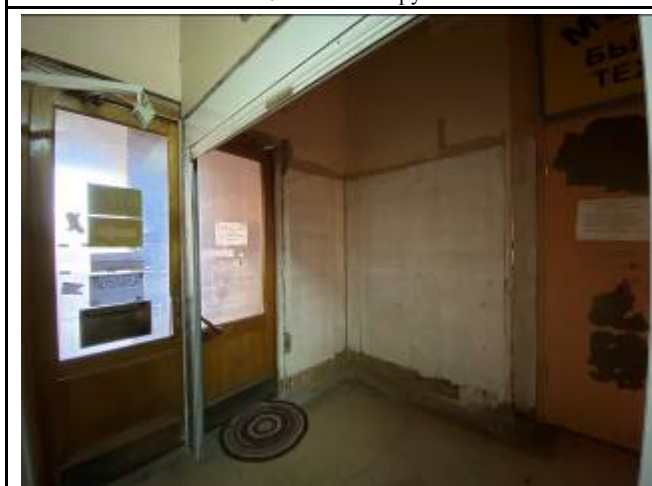
Фото №5 Входы в помещение
