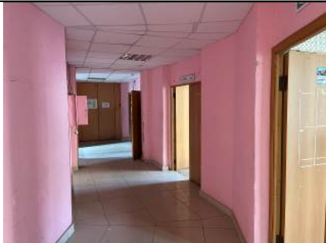
Фото №35 Входы в помещение
