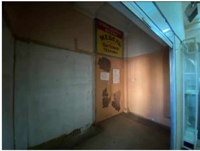
Фото №7 Входы в помещение
