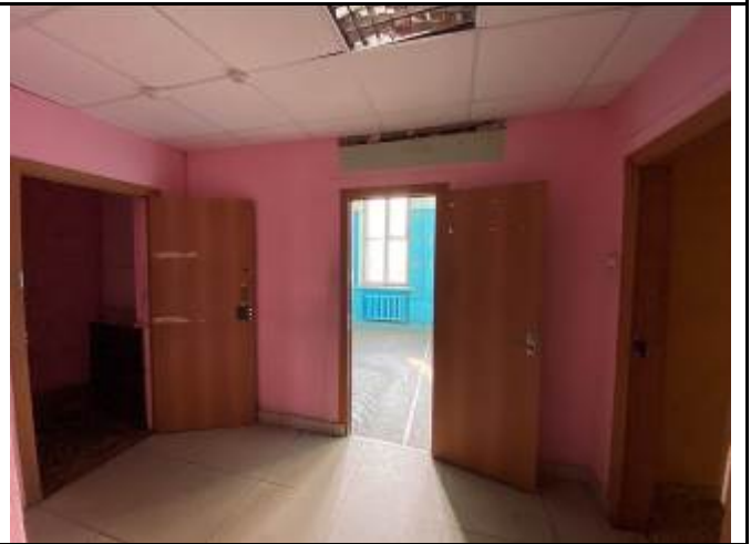
Фото №28. Входы в помещение
