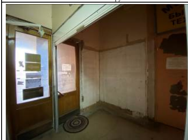
Фото №5 Входы в помещение
