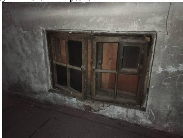
Фото 12. Оконные проемы (вид из помещения)
