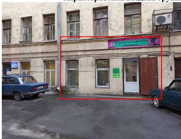
Фото 7. Отдельный вход со двора и оконные проемы
