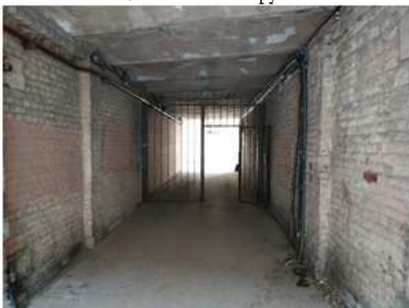
Фото 5. Арочный проезд (вид с дворовой территории на М. Посадскую ул.)
