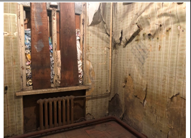
Фото 10 Вид помещения 3-Н
