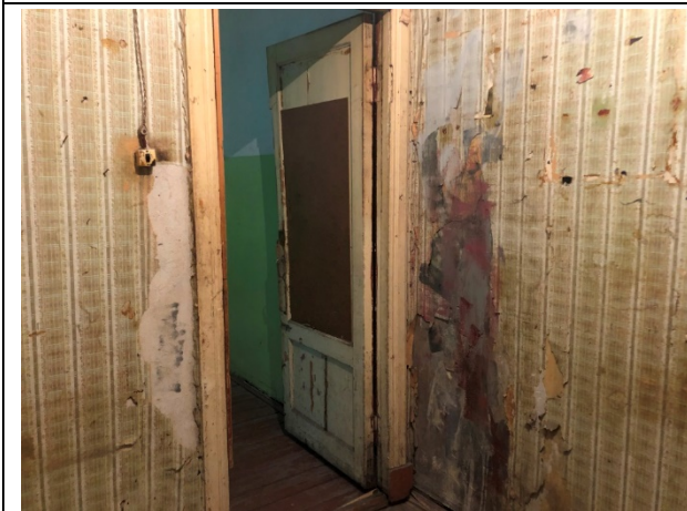
Фото 11 Вид помещения 3-Н
