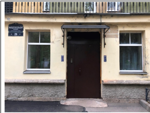
Фото 7 Общий вход со двора
