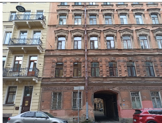
Фото №2 Здание, в котором располагается Объект оценки
