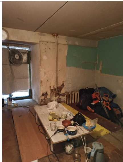
Фото №8 Внутреннее состояние пом. 2-Н
