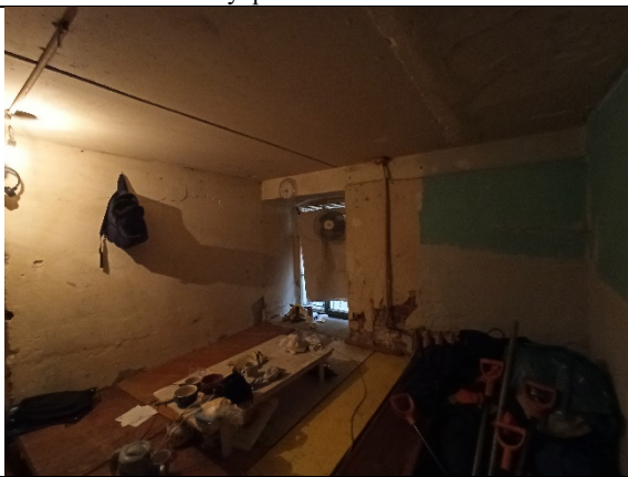
Фото №9 Внутреннее состояние пом. 2-Н
