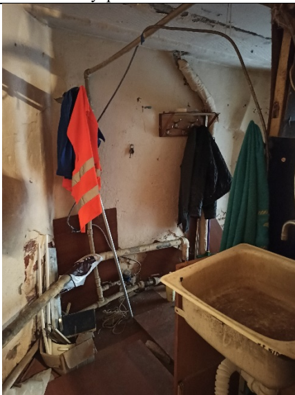
Фото №11 Внутреннее состояние пом. 2-Н
