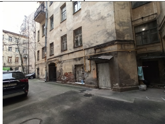
Фото №4. Вход со двора в пом. 2-Н
