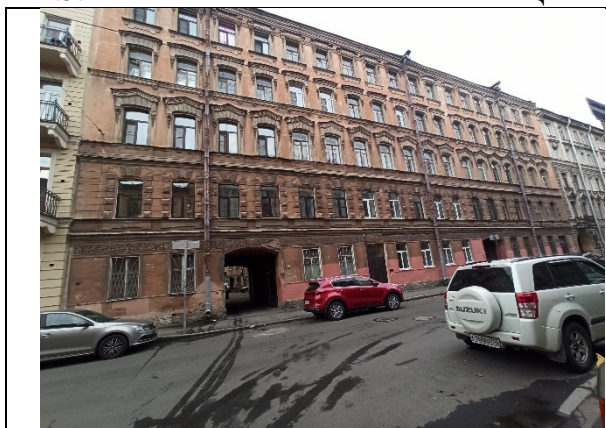
Фото №1 Здание, в котором располагается Объект оценки
