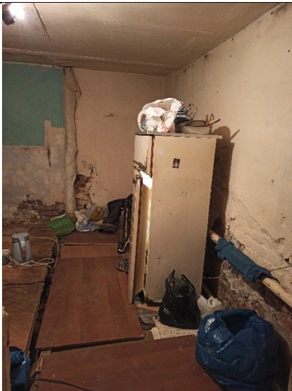
Фото №7. Внутреннее состояние пом. 2-Н
