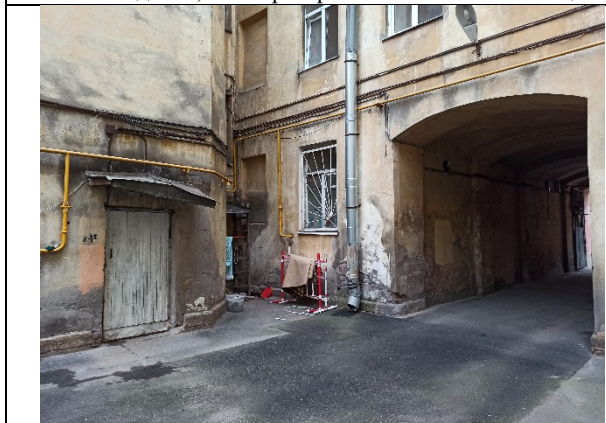
Фото №3 Вход в помещение 2-Н
