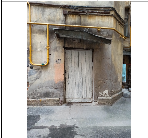
Фото №5 Вход в помещение 2-Н
