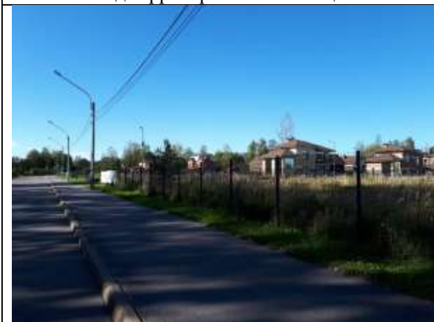
Фото 13. Вид подъездных путей и ближайшего окружения
