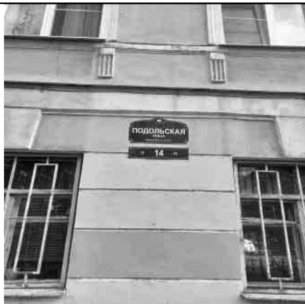
Фото №2 Здание, в котором располагается Объект оценки
