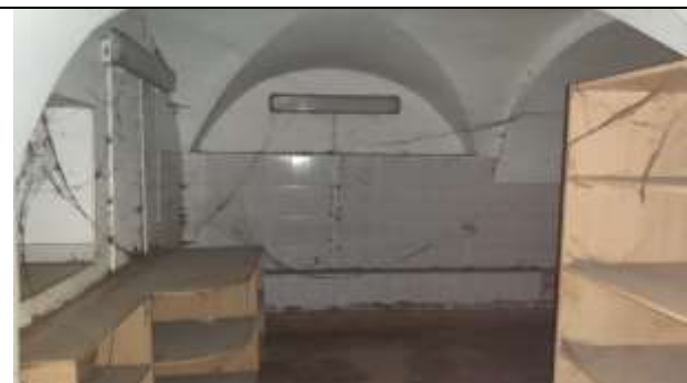
Фото 25 Общий вид и состояние помещения
