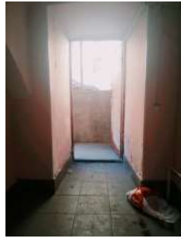
Фото 8. Вход в помещение
