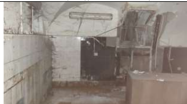
Фото 27 Общий вид и состояние помещения
