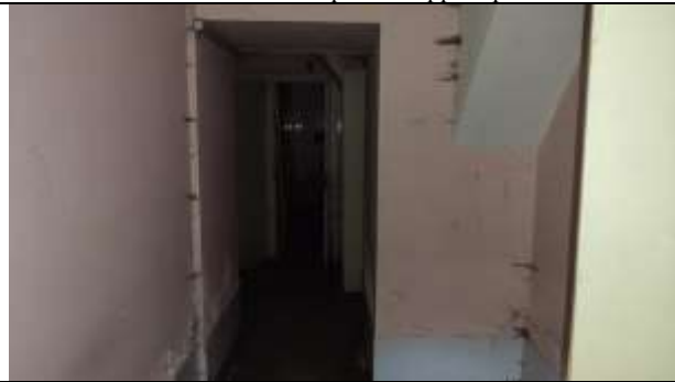
Фото 11 Общий вид и состояние помещений
