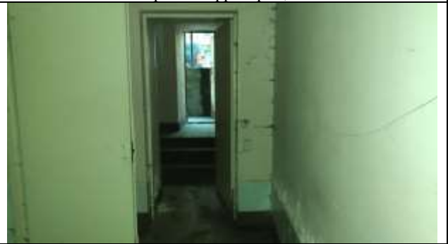
Фото 12 Общий вид и состояние помещений
