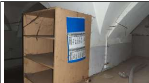
Фото 24 Общий вид и состояние помещения
