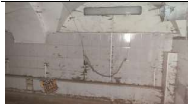
Фото 26 Общий вид и состояние помещения
