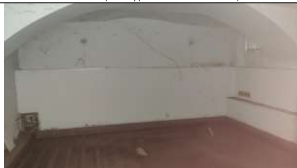
Фото 13 Общий вид и состояние помещения
