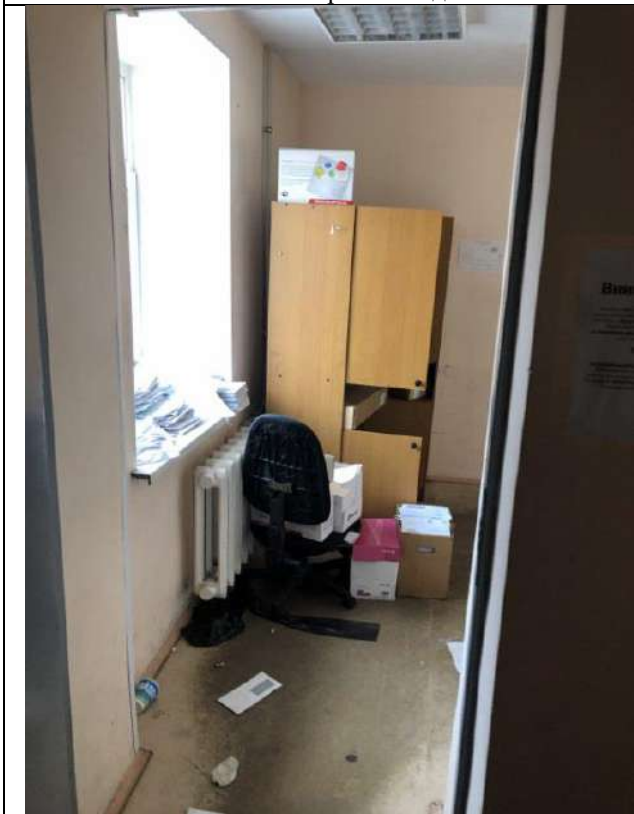
Фото 59. Состояние внутренней отделки пом. 3-Н (третий этаж)
