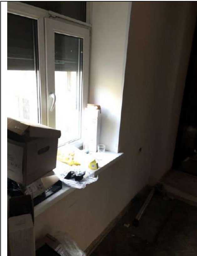
Фото 25. Состояние внутренней отделки пом. 3-Н (первый этаж)
