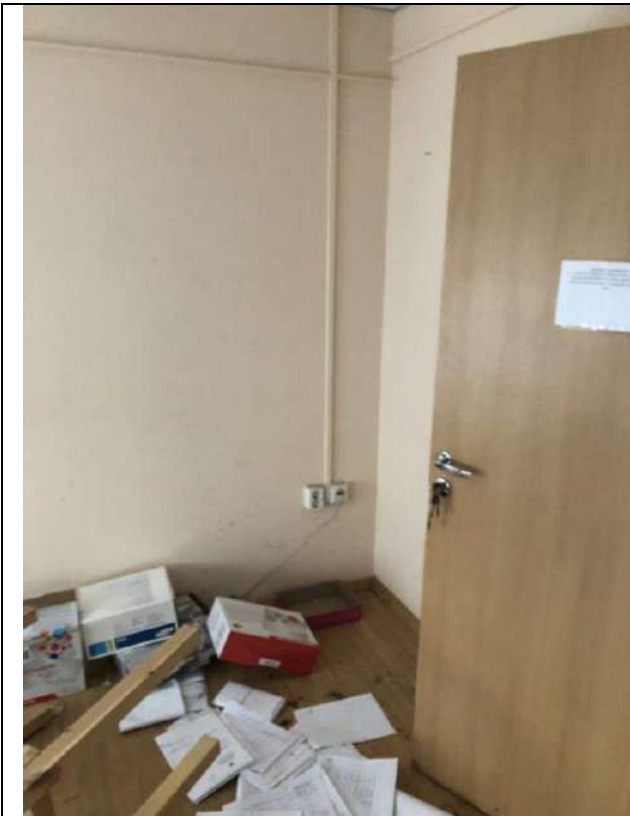
Фото 29. Состояние внутренней отделки пом. 3-Н (первый этаж)
