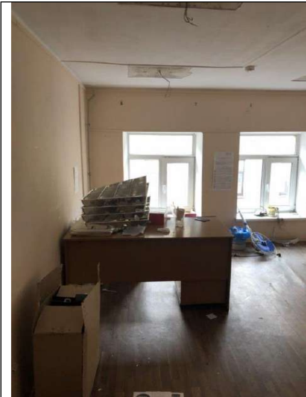
Фото 73. Состояние внутренней отделки пом. 3-Н (третий этаж)
