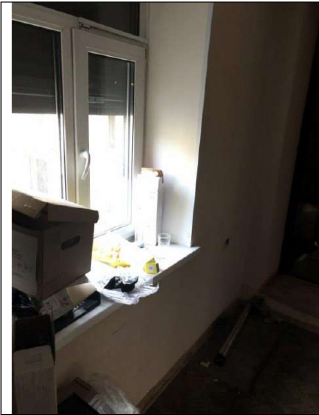
Фото 25. Состояние внутренней отделки пом. 3-Н (первый этаж)
