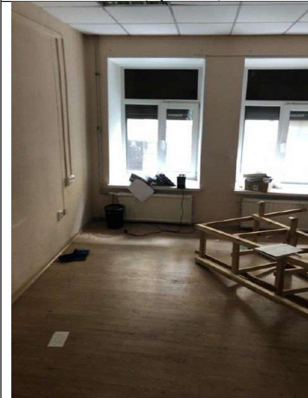
Фото 27. Состояние внутренней отделки пом. 3-Н (первый этаж)
