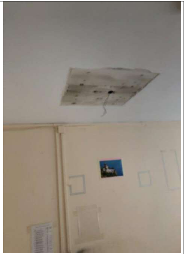
Фото 78. Состояние внутренней отделки пом. 3-Н (третий этаж)
