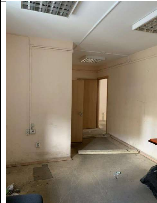
Фото 11. Состояние внутренней отделки пом. 3-Н (первый этаж)
