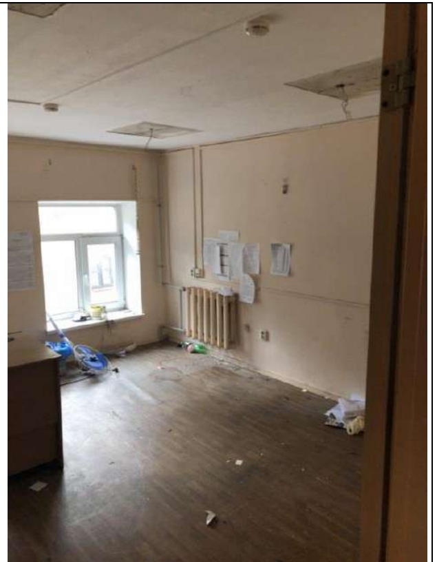
Фото 74. Состояние внутренней отделки пом. 3-Н (третий этаж)
