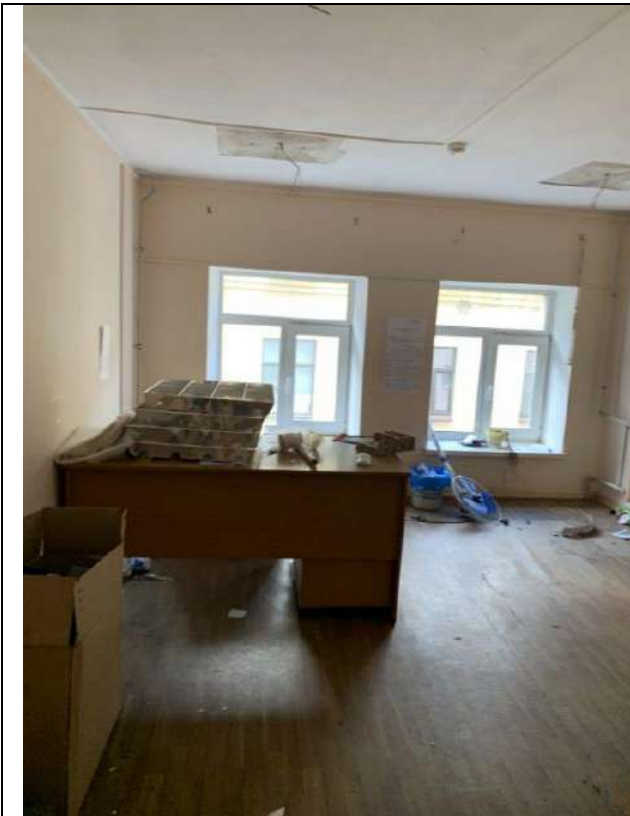
Фото 69. Состояние внутренней отделки пом. 3-Н (третий этаж)
