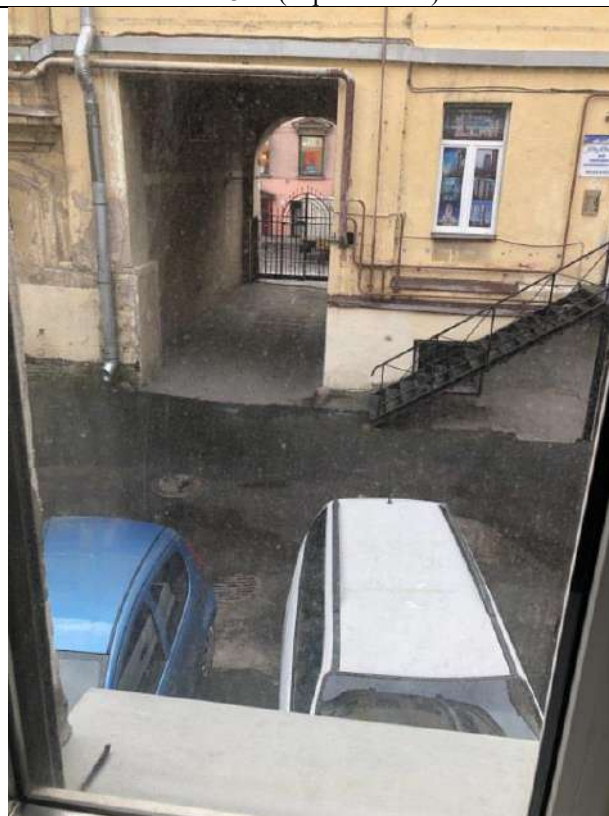
Фото 16. Вид из окон 1-го этажа
