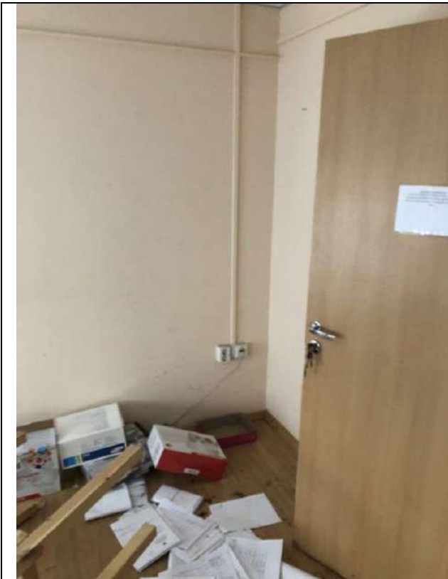
Фото 29. Состояние внутренней отделки пом. 3-Н (первый этаж)
