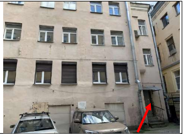
Фото 6. Вид на здание размещения Объекта оценки (вход №2)
