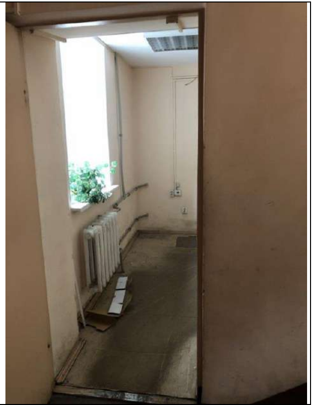
Фото 10. Подход к ч.п. 3-Н, расположенным на 1 этаже
