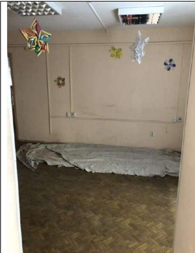
Фото 17. Состояние внутренней отделки пом. 3-Н (первый этаж)
