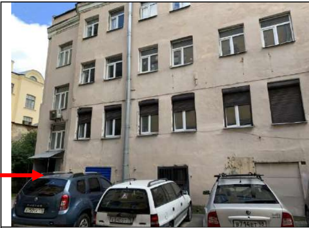
Фото 5. Вид на здание размещения Объекта оценки (вход №1)
