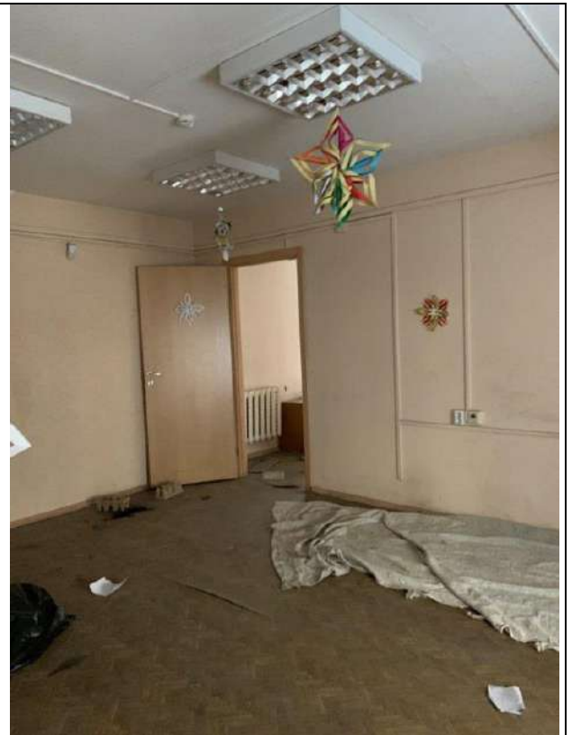
Фото 18. Состояние внутренней отделки пом. 3-Н (первый этаж)
