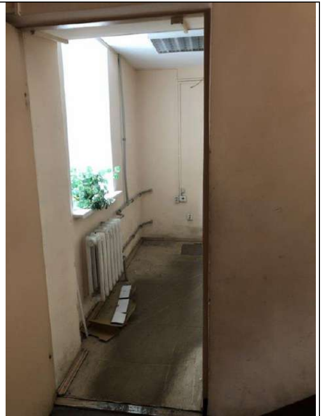
Фото 10. Подход к ч.п. 3-Н, расположенным на 1 этаже
