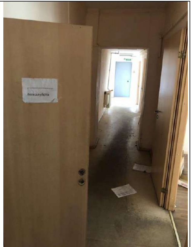
Фото 66. Состояние внутренней отделки пом. 3-Н (третий этаж)
