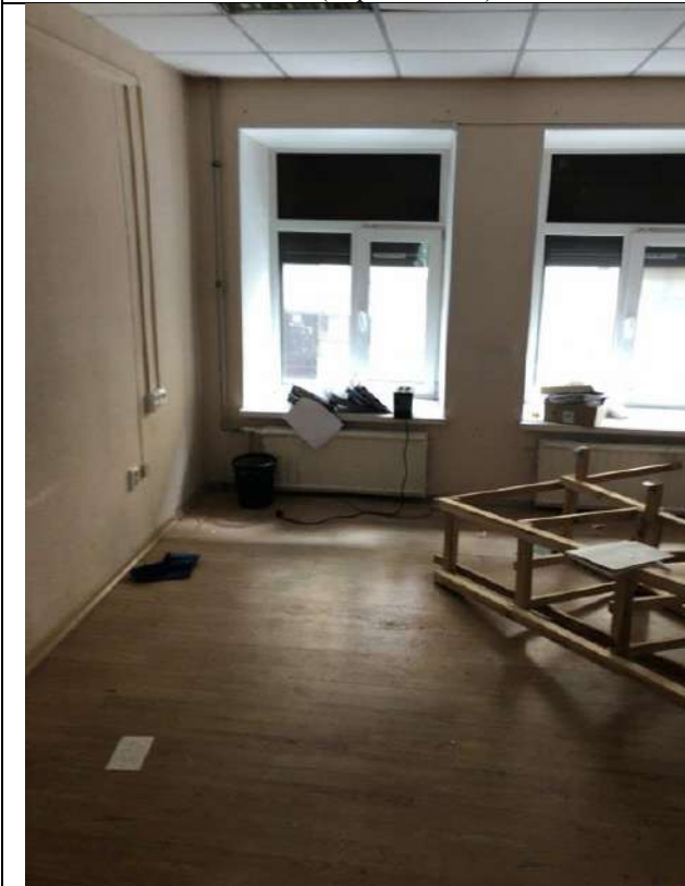
Фото 27. Состояние внутренней отделки пом. 3-Н (первый этаж)
