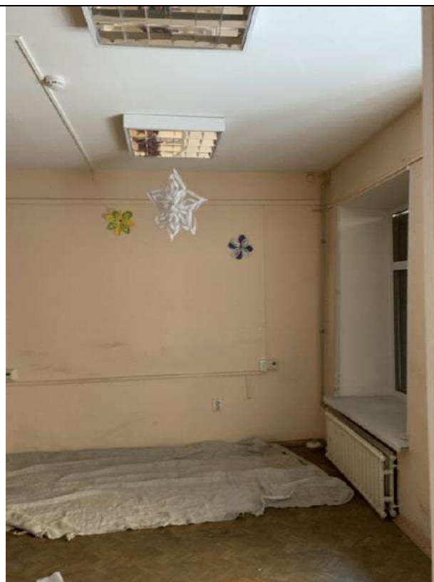
Фото 14. Состояние внутренней отделки пом. 3-Н (первый этаж)
