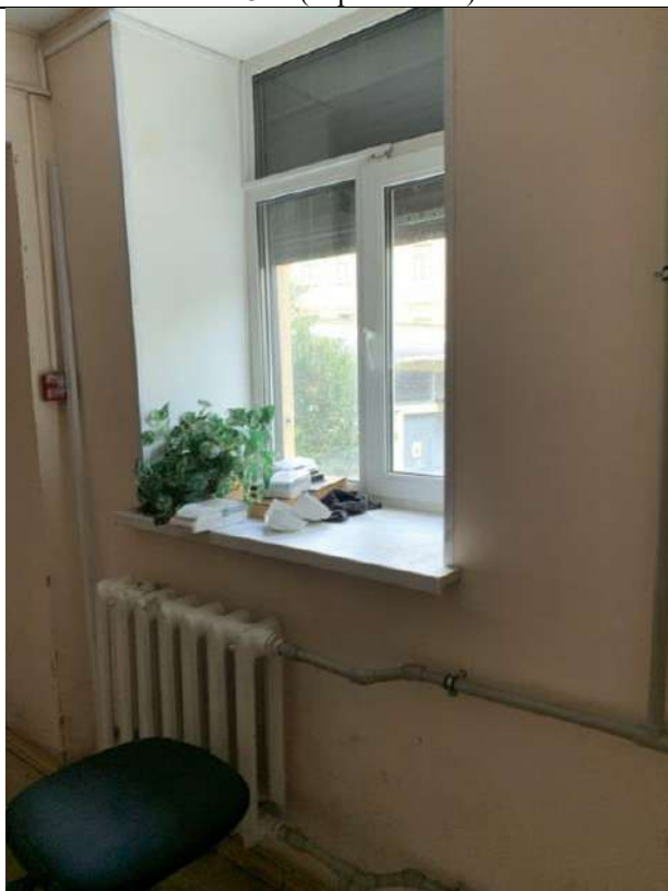
Фото 15. Состояние внутренней отделки пом. 3-Н (первый этаж)
