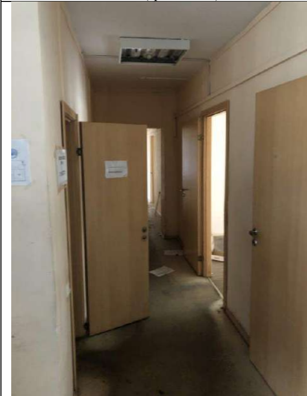
Фото 63. Состояние внутренней отделки пом. 3-Н (третий этаж)
