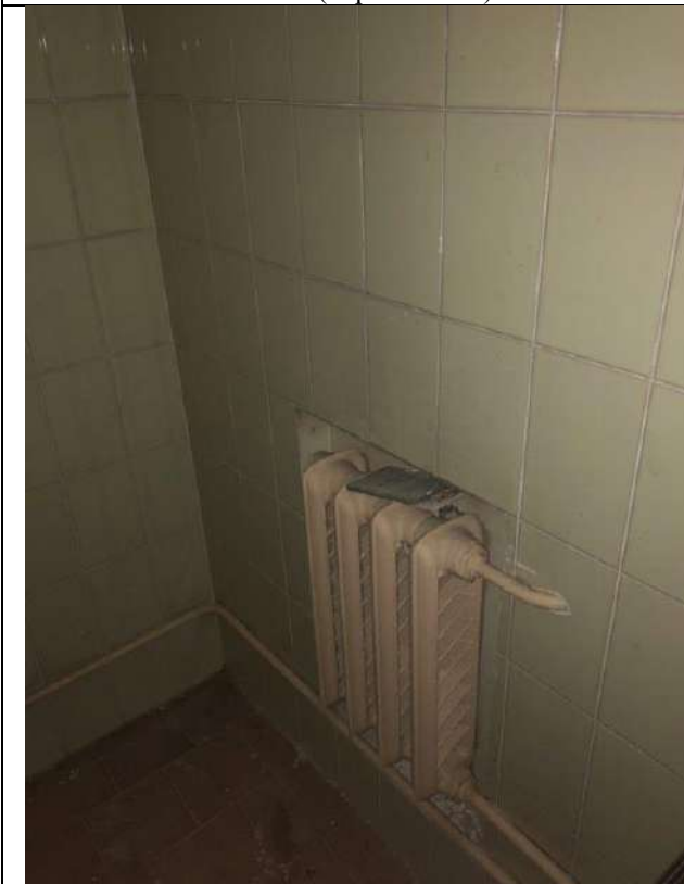
Фото 23. Состояние внутренней отделки пом. 3-Н (первый этаж)
