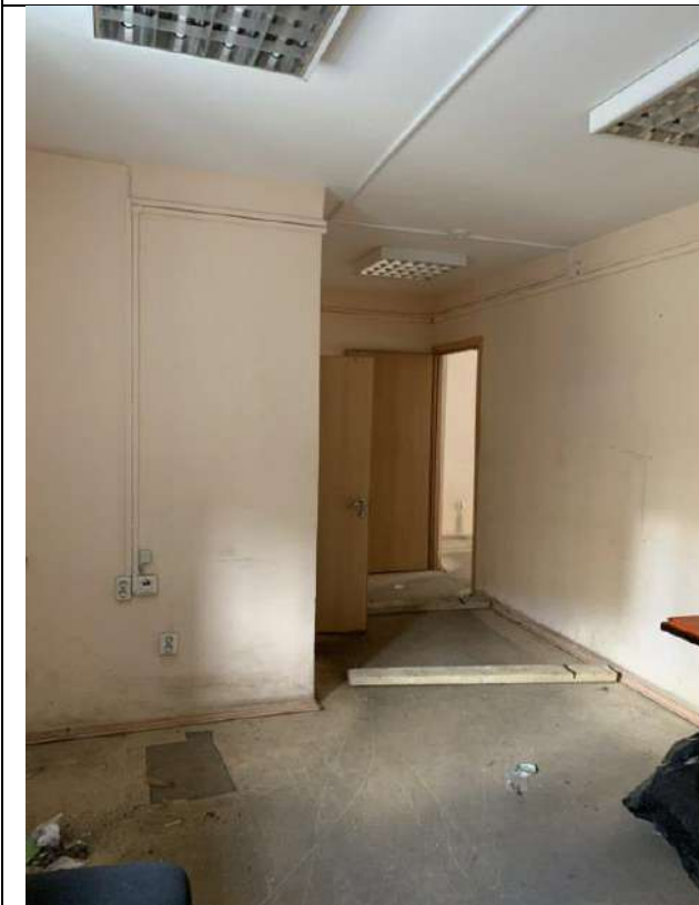
Фото 11. Состояние внутренней отделки пом. 3-Н (первый этаж)
