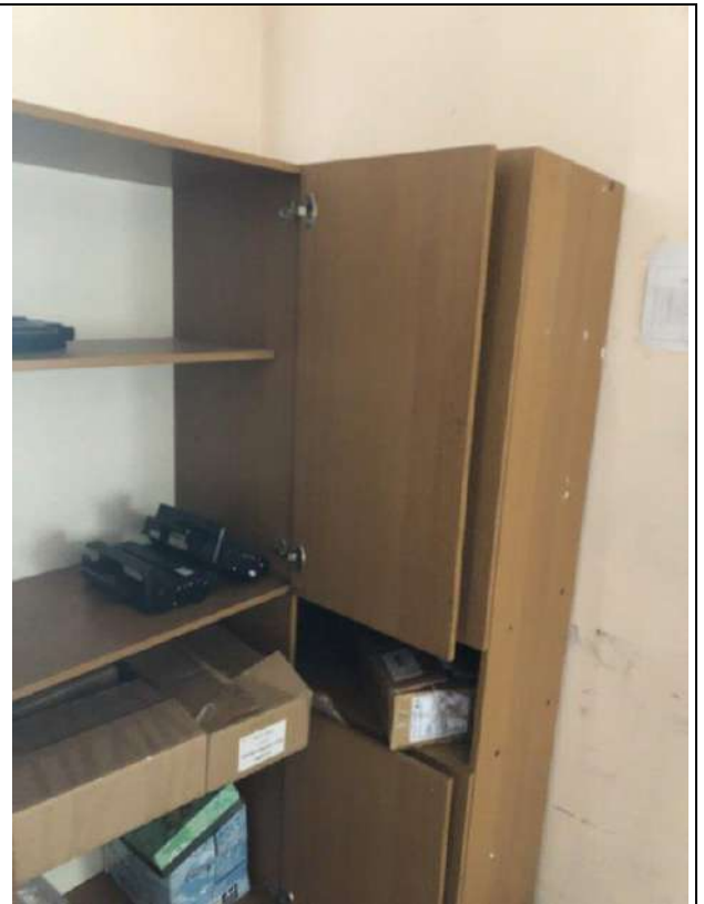
Фото 62. Состояние внутренней отделки пом. 3-Н (третий этаж)
