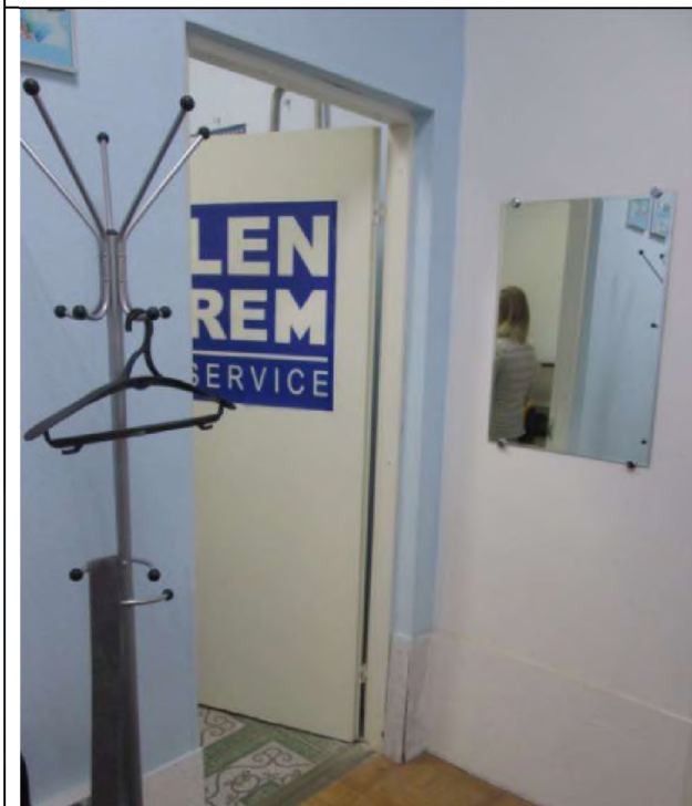
Фото 19. Состояние ч.п. 2 пом. 16-Н (проход в ч.п. 4 пом. 16-Н)
