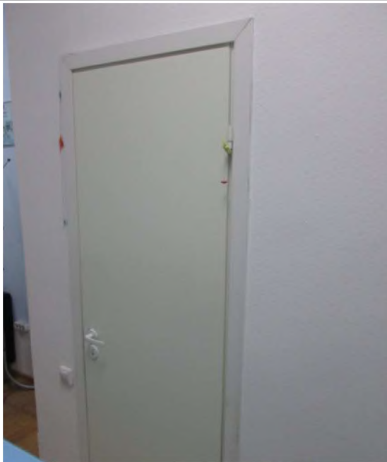
Фото 25. Вход в ч.п. 5 пом 16-Н
