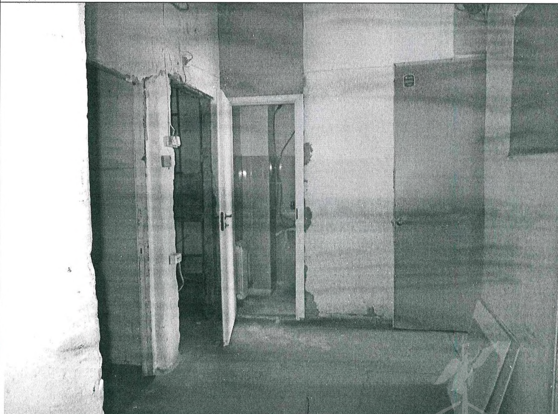
Описание: В ч.п. 5 Объекта установлена перегородка с дверным проемом
