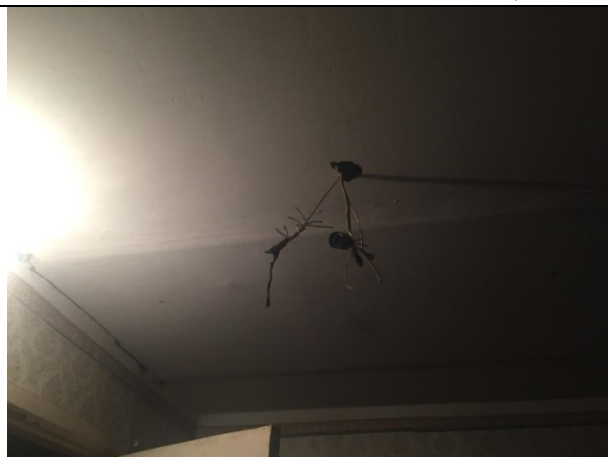
Фото 21. Типичное состояние Объекта оценки
