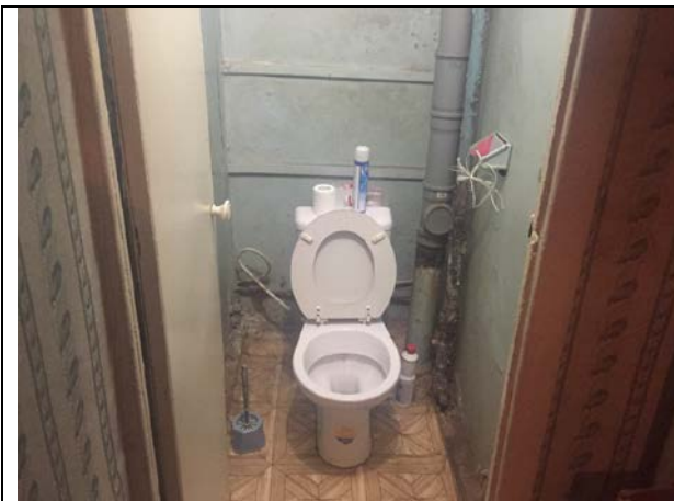
Фото 25. Типичное состояние Объекта оценки
