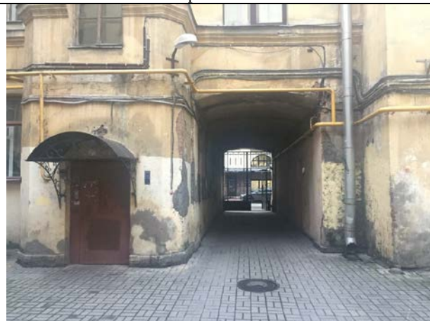
Фото 12. Внутриворобая территория здания расположения Объекта оценки
