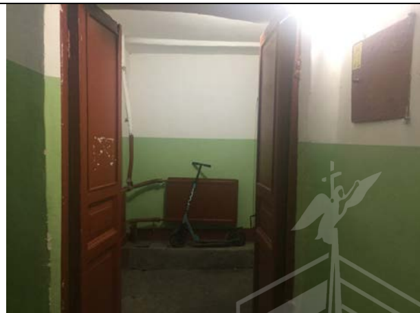
Фото 16. Вид входной группы Объекта оценки (общий вход со двора)
