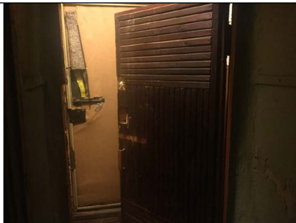
Фото 17. Типичное состояние Объекта оценки
