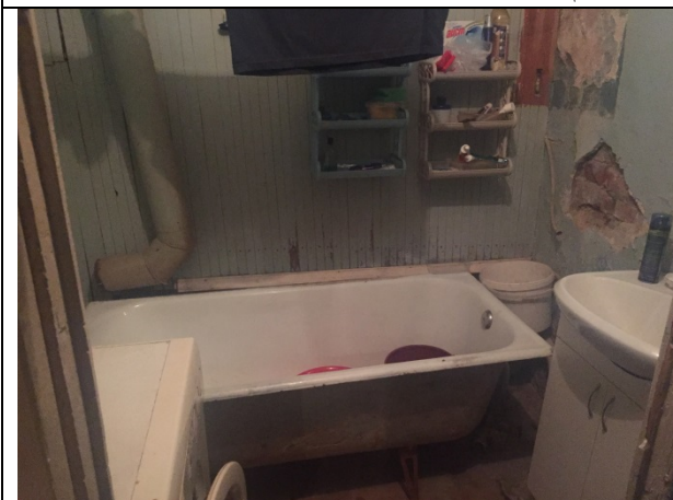
Фото 27. Типичное состояние Объекта оценки
