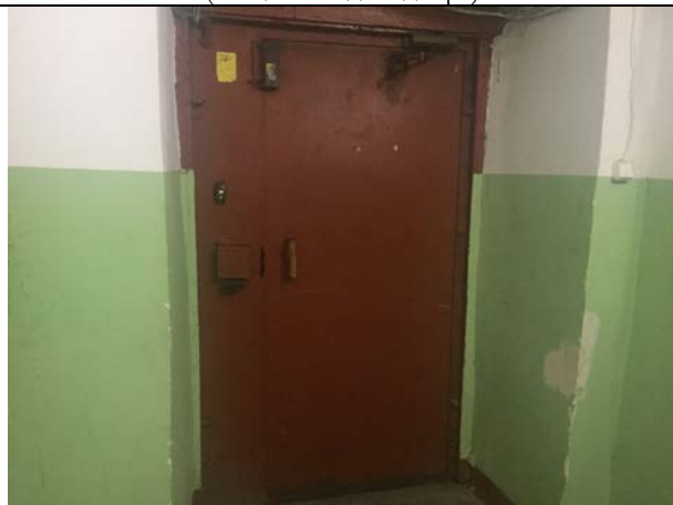
Фото 15. Вид входной группы Объекта оценки (общий вход со двора)
