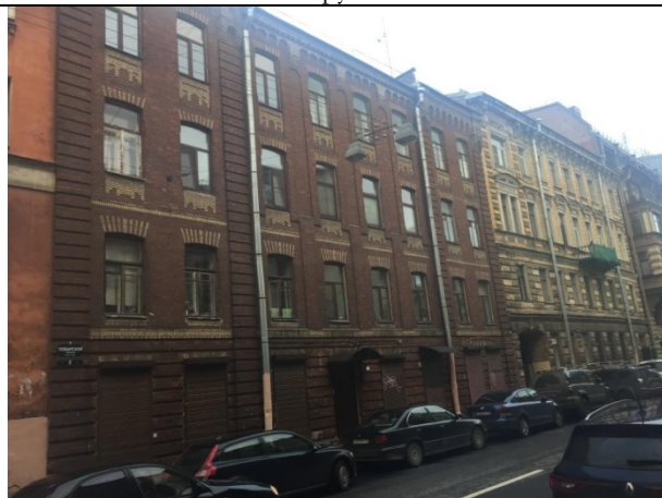
Фото 11. Вид здания расположения Объекта оценки
