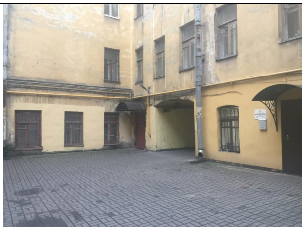
Фото 13. Вид входной группы Объекта оценки (общий вход со двора)
