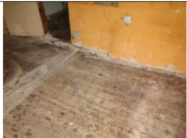
Фото 28 Общий вид и состояние помещений
