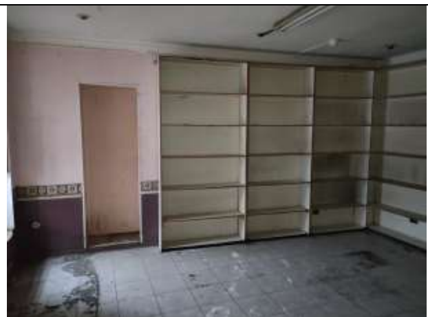
Фото 20 Общий вид и состояние помещения
