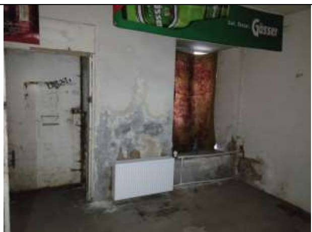
Фото 48 Общий вид и состояние помещения, выход на улицу
