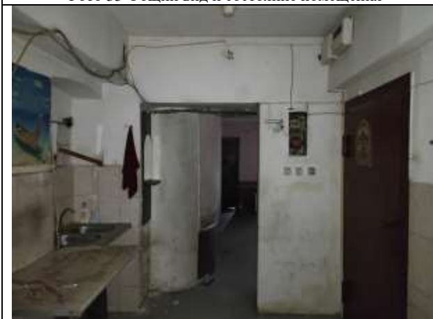
Фото 37 Общий вид и состояние помещения
