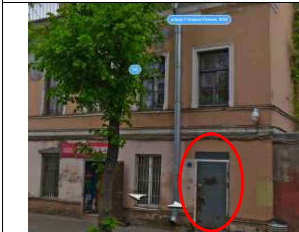
Фото 49 Общий вид, отдельный вход с улицы
