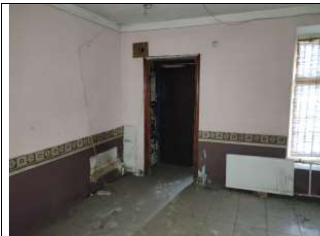
Фото 19 Общий вид и состояние помещения
