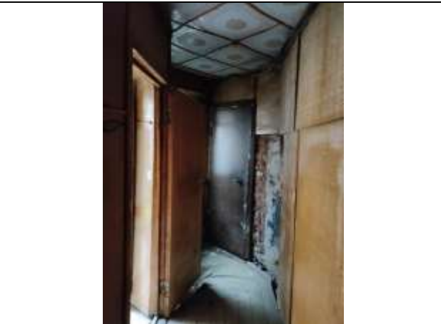
Фото 24 Вход в помещение 5-Н со двора
