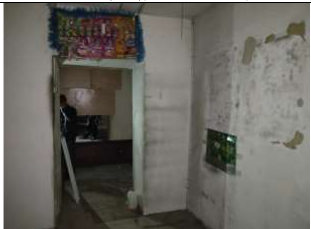
Фото 46 Общий вид и состояние помещения
