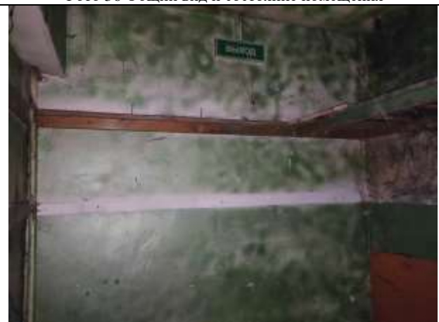
Фото 38 Общий вид и состояние помещения
