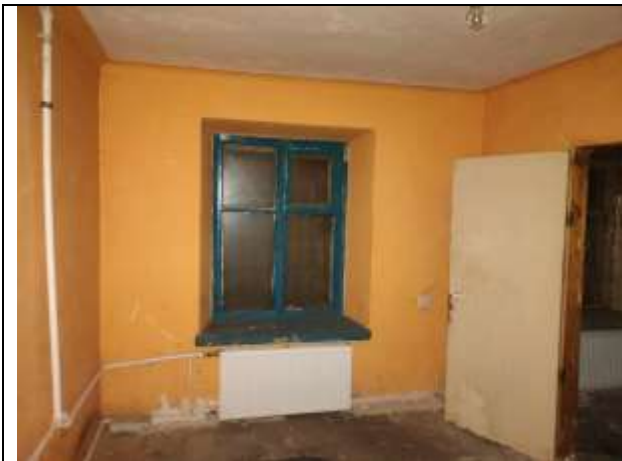
Фото 27 Общий вид и состояние помещений
