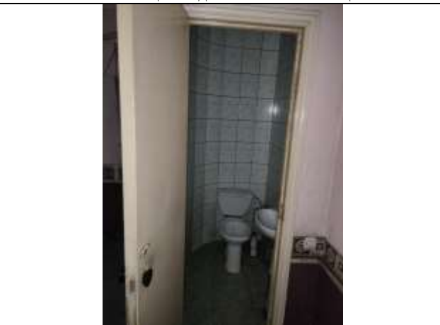
Фото 22 Общий вид и состояние помещения
