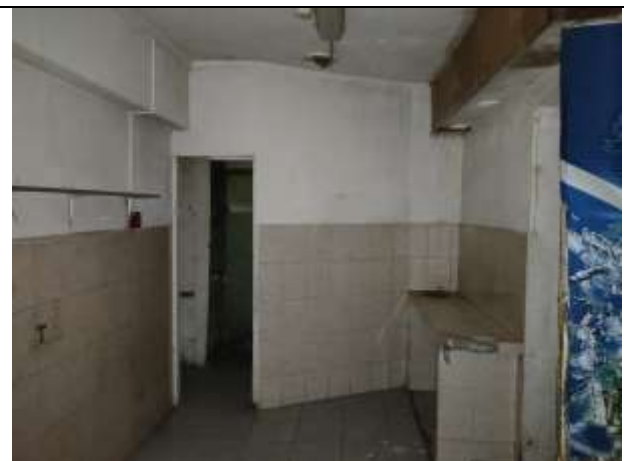
Фото 36 Общий вид и состояние помещения
