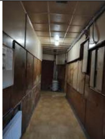
Фото 12 Вид на коридор, ведущий к помещению 4-Н
