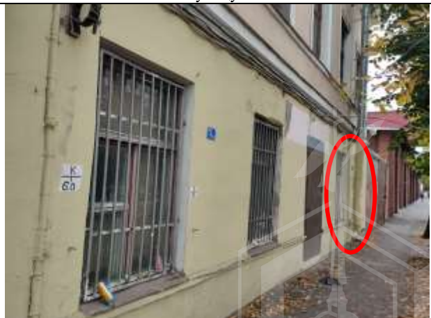
Фото 50 Общий вид, отдельный вход с улицы
