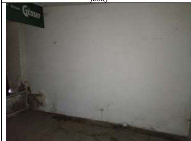
Фото 47 Общий вид и состояние помещения
