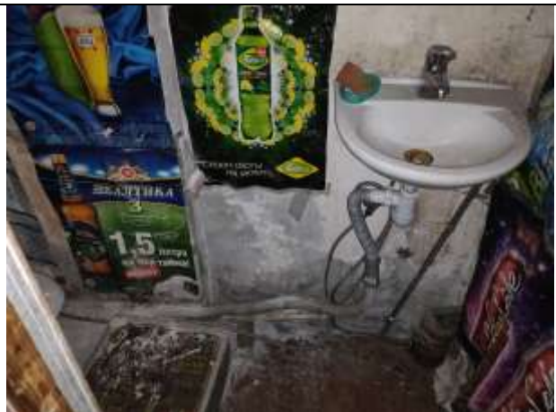
Фото 44 Общий вид и состояние помещения
