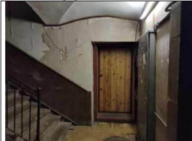
Фото 23 Вход в помещение 5-Н, через общий вход с улицы
