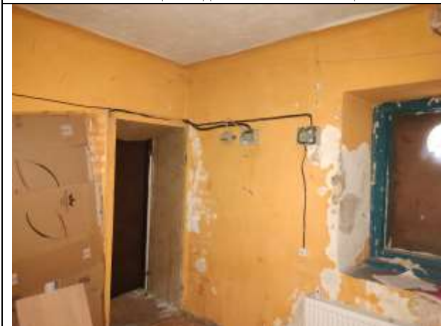
Фото 29 Общий вид и состояние помещения
