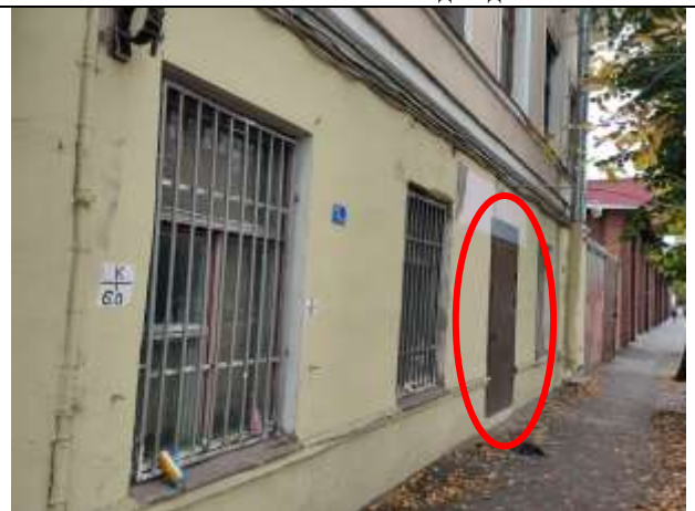
Фото 16 Общий вид, отдельный вход с улицы
