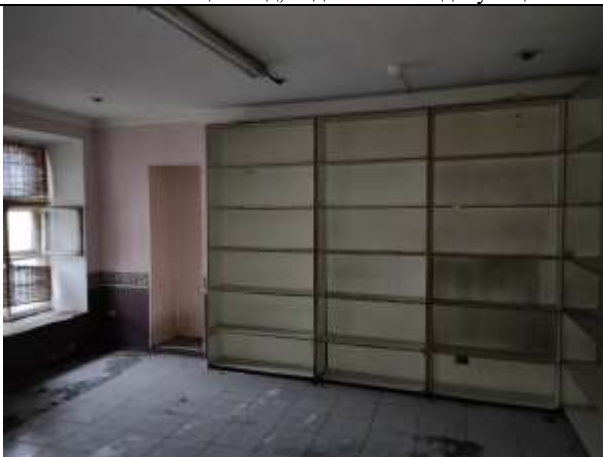
Фото 17 Общий вид и состояние помещений
