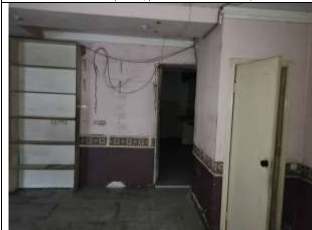
Фото 21 Общий вид и состояние помещения
