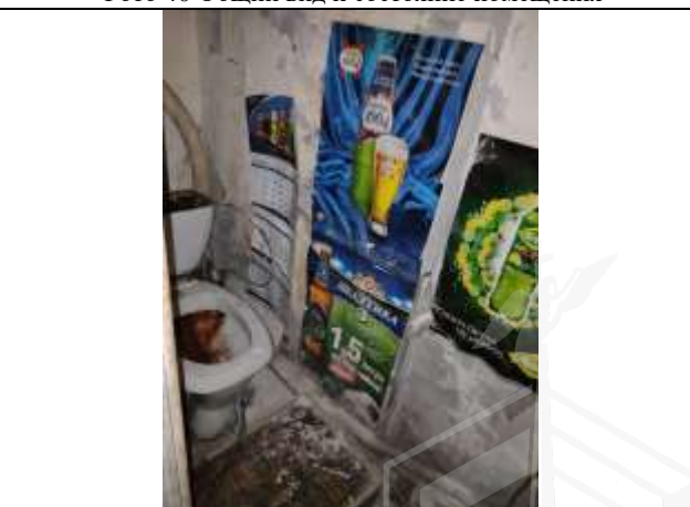
Фото 42 Общий вид и состояние помещения
