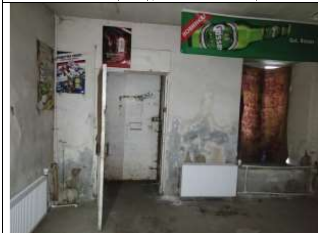
Фото 45 Общий вид и состояние помещения, выход на улицу
