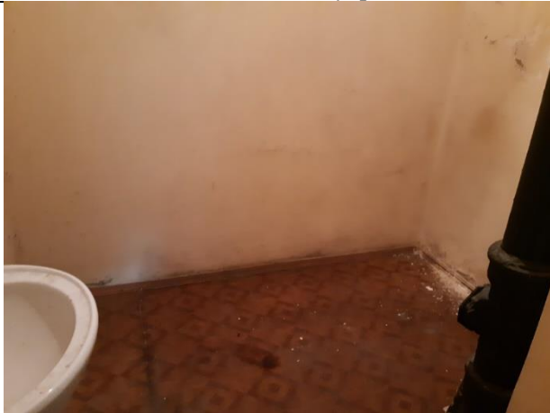
Фото 41. Состояние внутренней отделки.
