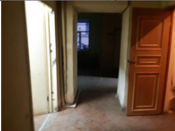
Фото 39. Состояние внутренней отделки.
