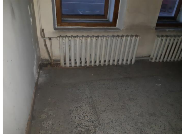
Фото 22. Состояние внутренней отделки.
