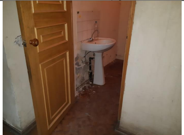
Фото 40. Состояние внутренней отделки.
