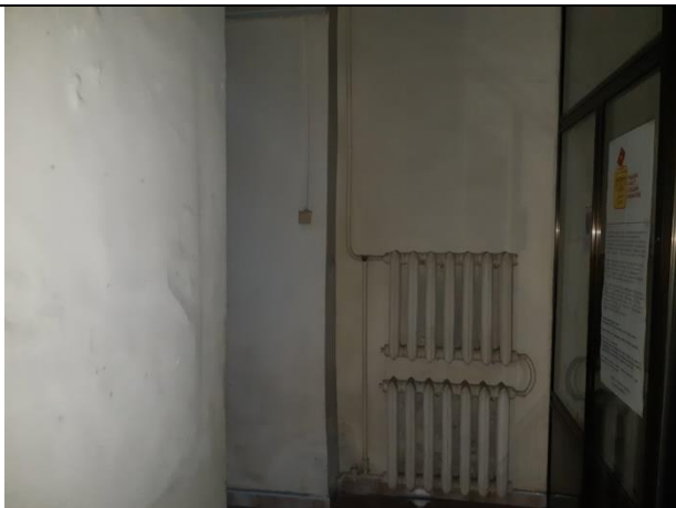
Фото 15. Состояние внутренней отделки.
