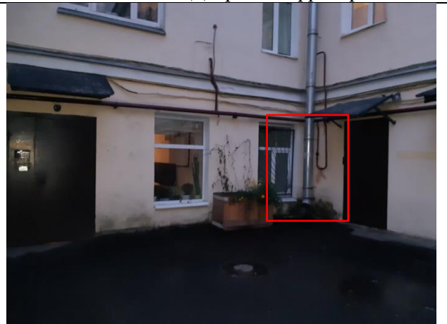
Фото 14. Вид на Объект оценки со двора. Оборудовано окно вместо отдельного входа со двора.
