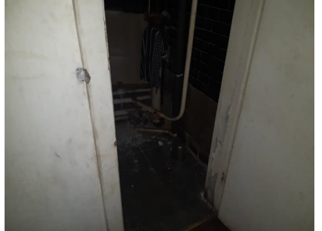
Фото 32. Состояние внутренней отделки.
