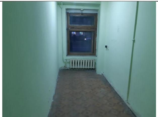
Фото 36. Состояние внутренней отделки.
