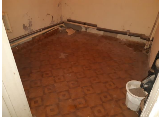
Фото 30. Состояние внутренней отделки.
