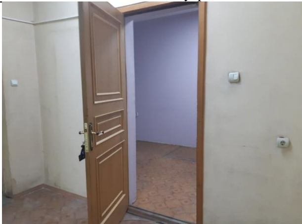
Фото 49. Состояние внутренней отделки.
