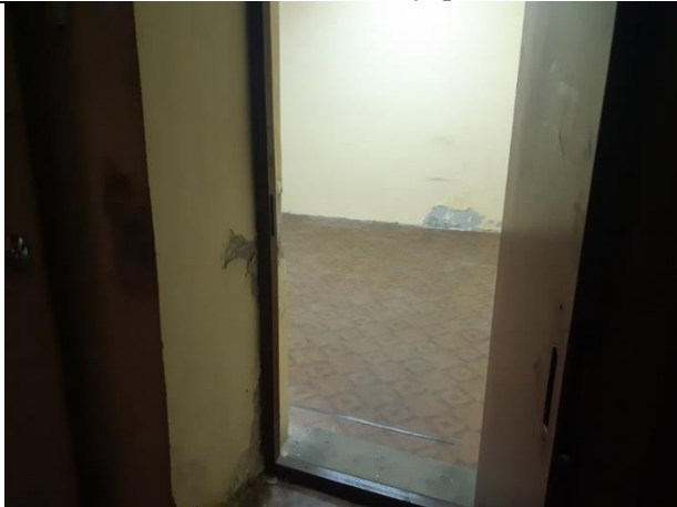
Фото 25. Состояние внутренней отделки.
