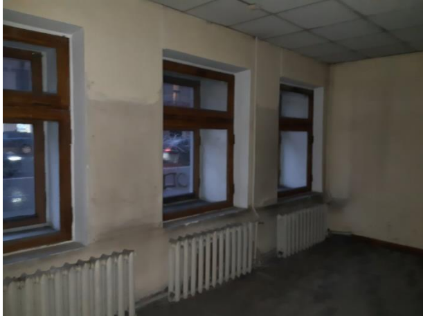
Фото 21. Состояние внутренней отделки.
