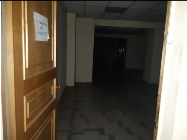
Фото 23. Состояние внутренней отделки.
