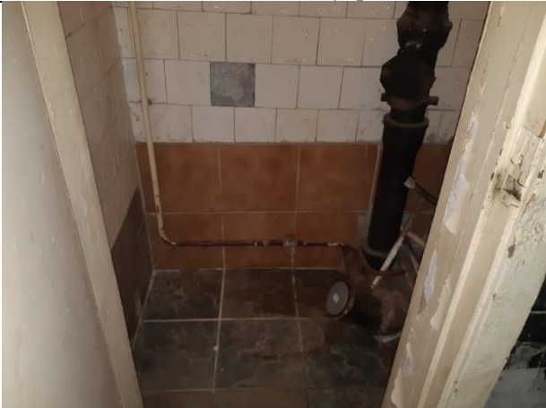
Фото 33. Состояние внутренней отделки.
