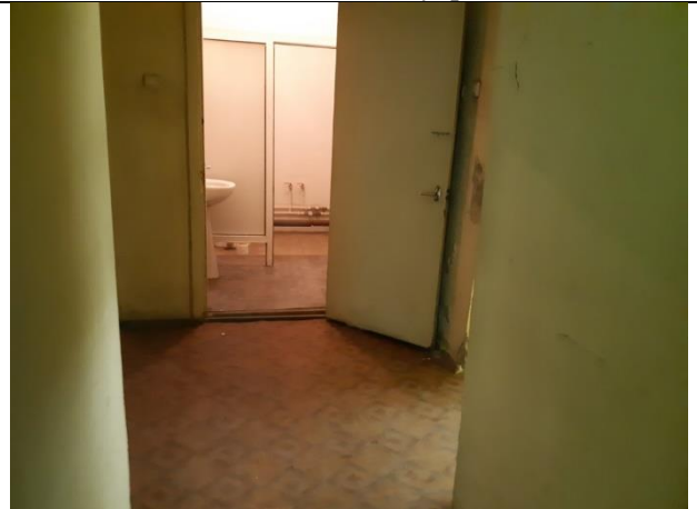
Фото 24. Состояние внутренней отделки.
