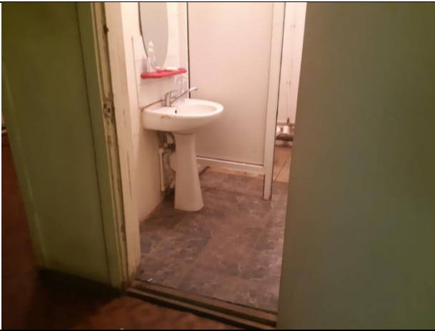
Фото 27. Состояние внутренней отделки.
