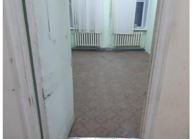
Фото 46. Состояние внутренней отделки.
