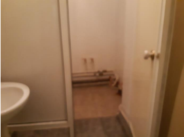
Фото 29. Состояние внутренней отделки.
