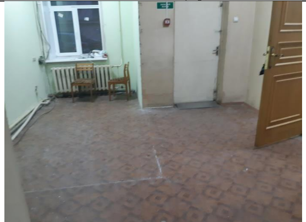
Фото 48. Состояние внутренней отделки.
