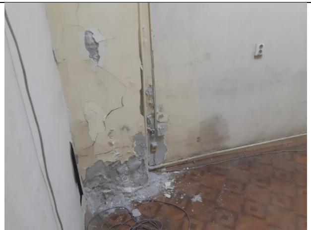
Фото 44. Состояние внутренней отделки.
