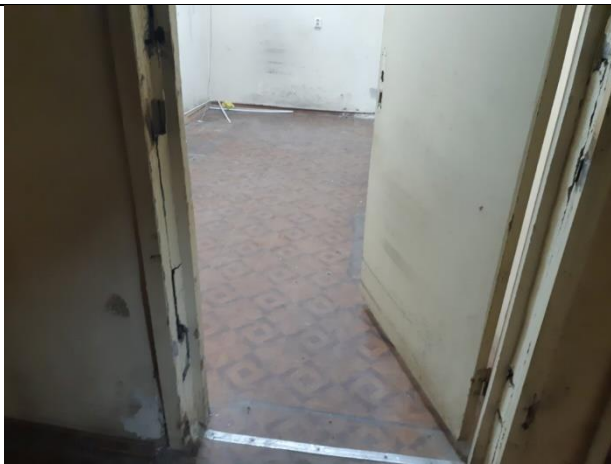
Фото 43. Состояние внутренней отделки.
