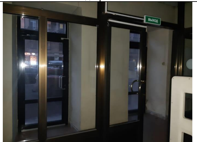
Фото 16. Состояние внутренней отделки.
