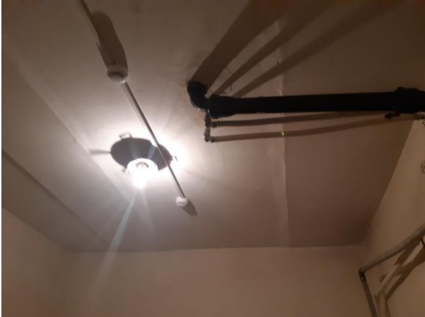
Фото 31. Состояние внутренней отделки.
