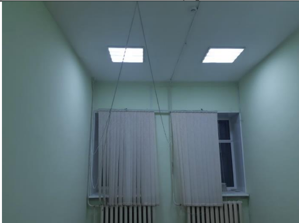
Фото 47. Состояние внутренней отделки.
