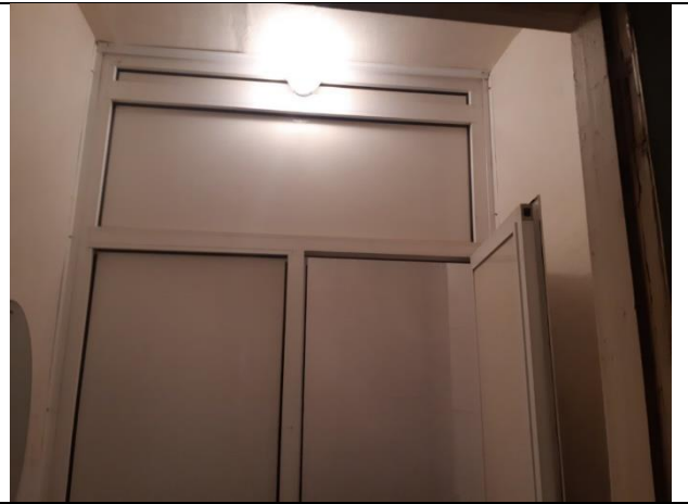
Фото 28. Состояние внутренней отделки.
