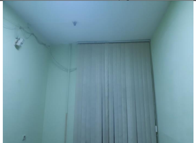
Фото 38. Состояние внутренней отделки.
