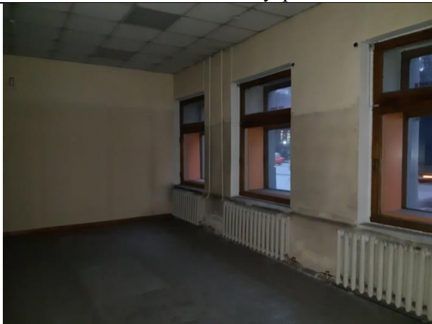
Фото 17. Состояние внутренней отделки.
