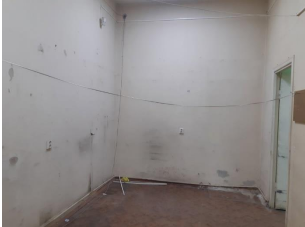
Фото 45. Состояние внутренней отделки.
