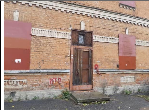
Фото 7. Вход в здание с улицы (с торца здания).
