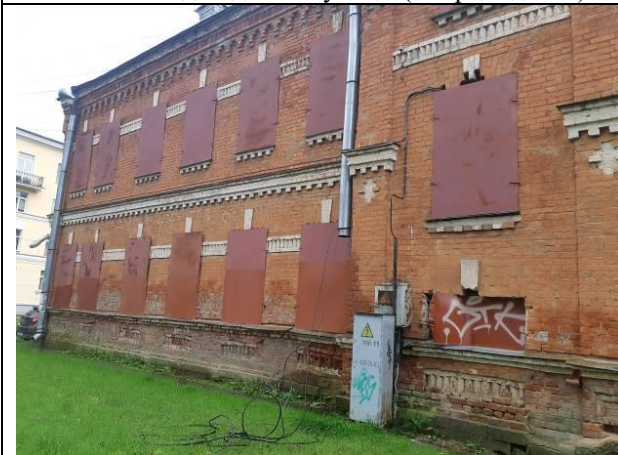
Фото 9. Состояние здания расположения Объекта оценки.
