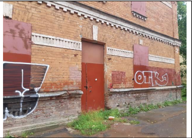
Фото 8. Вход в здание со двора (с торца здания).
