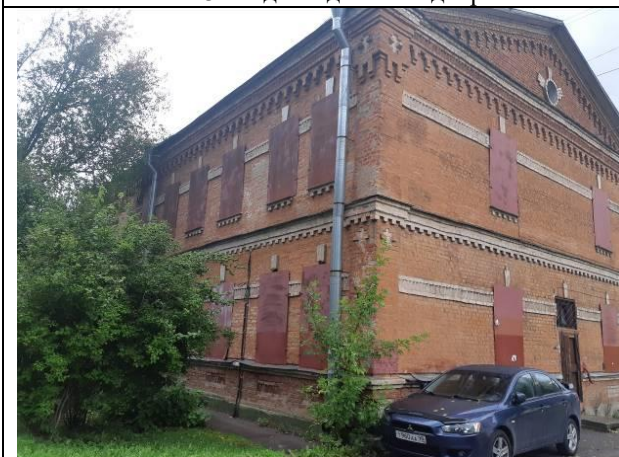
Фото 5. Вид на здание с улицы.
