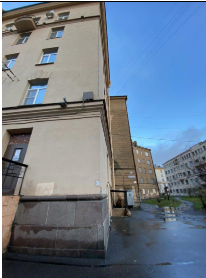
Фото 3. Вид на часть здания с ул. Швецова.
