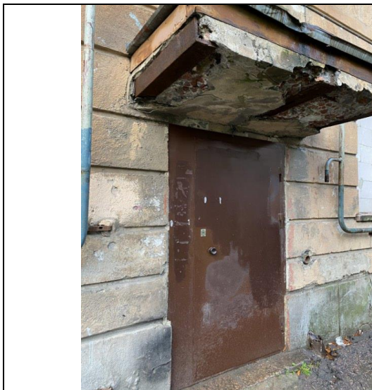
Фото 5. Состояние здания расположения Объекта оценки.
