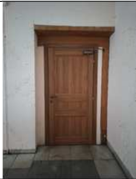
Фото 8. Вход в помещение 3-Н
