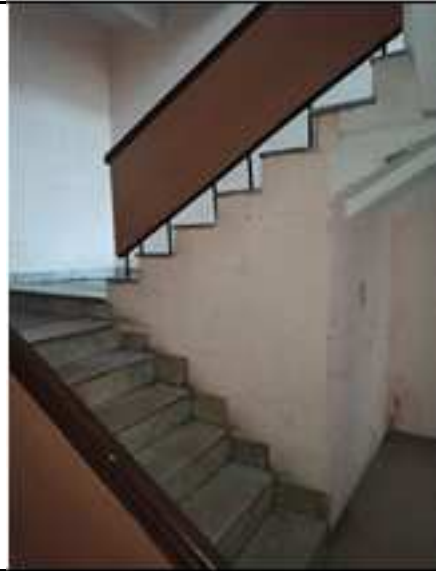
Фото 6. Лестница на 2 этаж помещения
