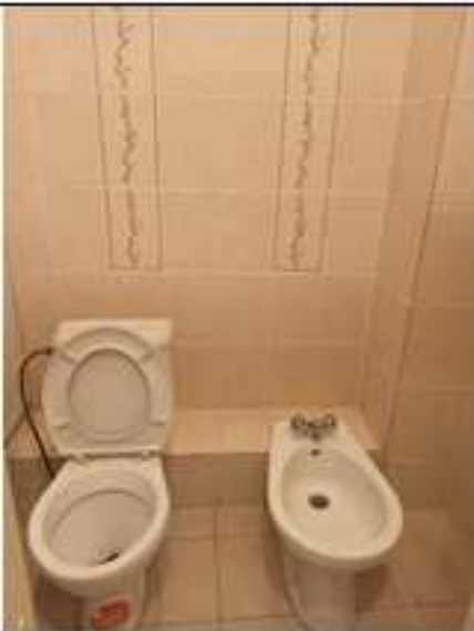
Фото 25. Помещение 3-Н. Санузел
