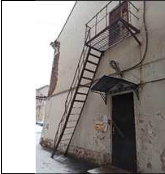
Фото 5. Отдельный вход в помещение по металлической лестнице
