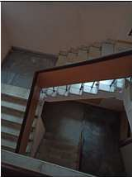
Фото 7. Лестница на 2 этаж помещения
