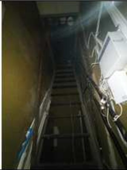
Фото 11. Выход на чердак
