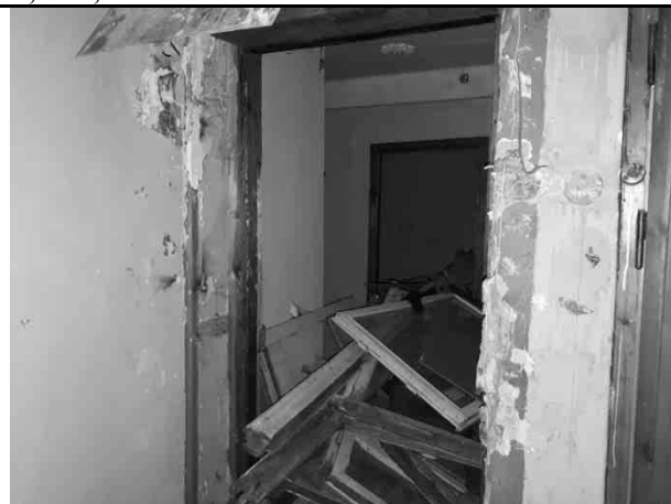
Фото 8. Типичное состояние пом. 4-Н
