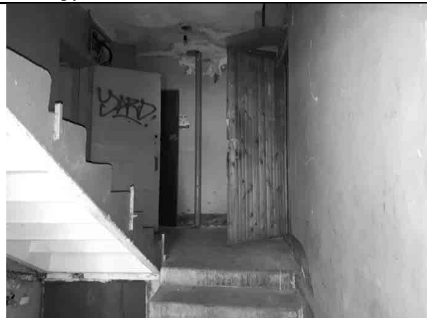
Фото 6. Лестничная клетка 1-го этажа
