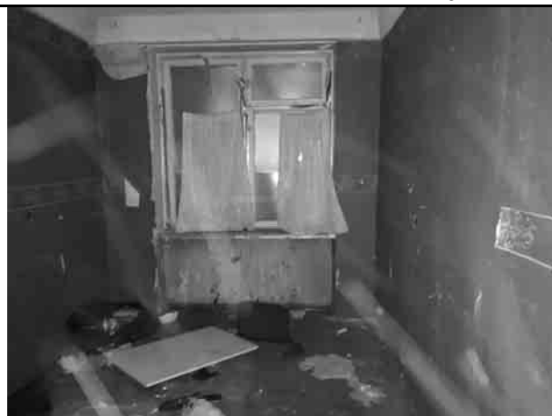
Фото 14. Типичное состояние пом. 9-Н
