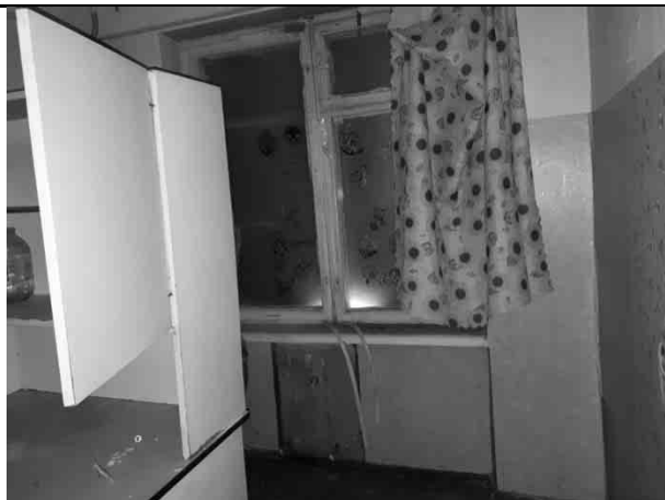
Фото 15. Типичное состояние пом. 10-Н
