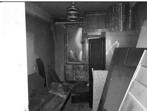
Фото 34. Типичное состояние пом. 21-Н
