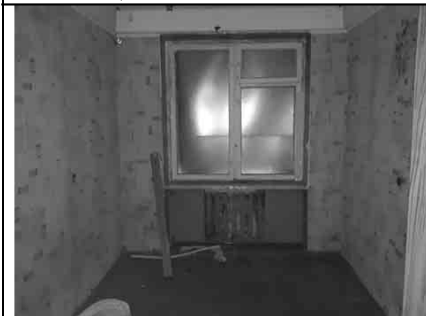
Фото 19. Типичное состояние пом. 13-Н
