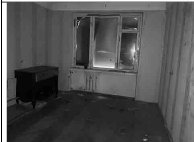
Фото 21. Типичное состояние пом. 15-Н
