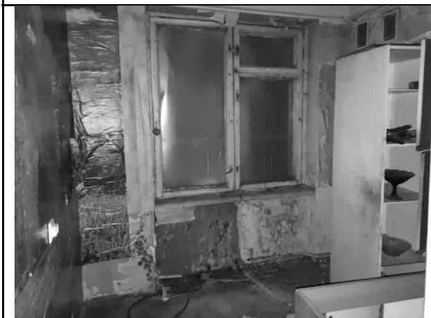
Фото 33. Типичное состояние пом. 21-Н
