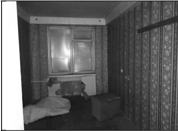
Фото 35. Типичное состояние пом. 22-Н
