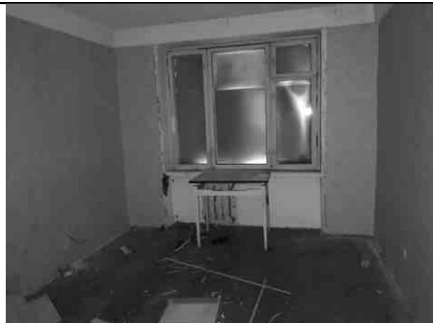
Фото 12. Типичное состояние пом. 8-Н
