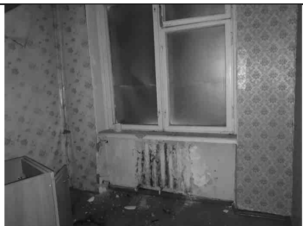
Фото 24. Типичное состояние пом. 16-Н
