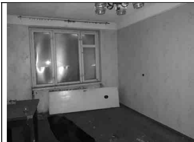
Фото 23. Типичное состояние пом. 16-Н
