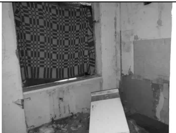
Фото 13. Типичное состояние пом. 8-Н
