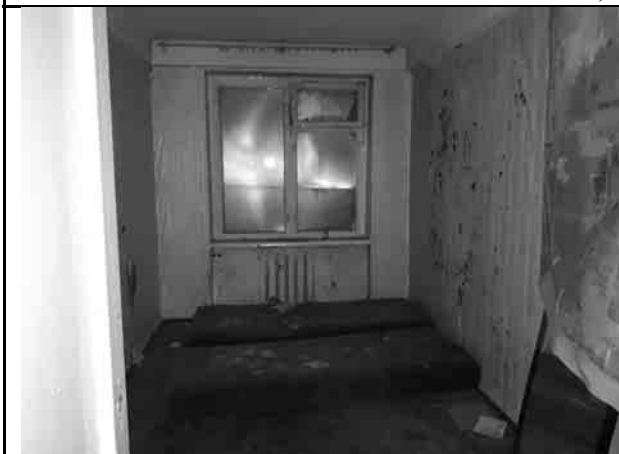
Фото 17. Типичное состояние пом. 11-Н
