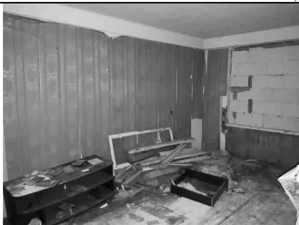
Фото 7. Типичное состояние пом. 3-Н
