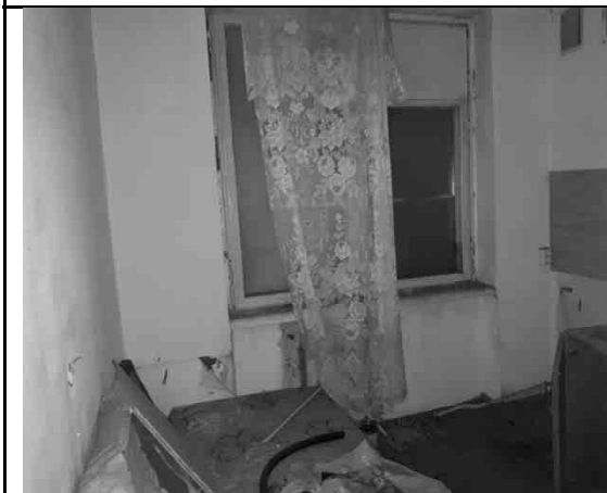
Фото 29. Типичное состояние пом. 19-Н
