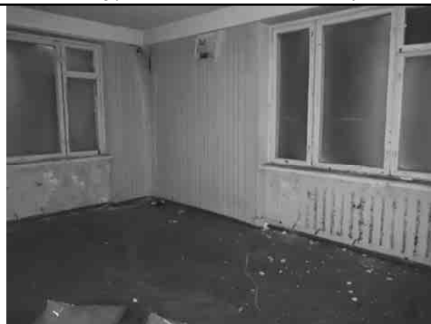
Фото 32. Типичное состояние пом. 20-Н
