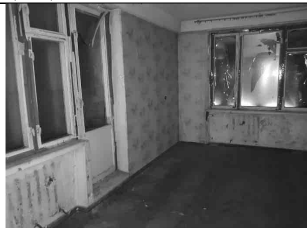
Фото 22. Типичное состояние пом. 15-Н
