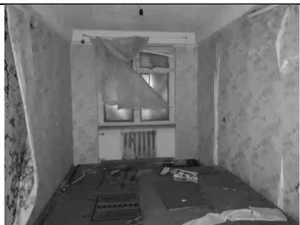
Фото 28. Типичное состояние пом. 18-Н
