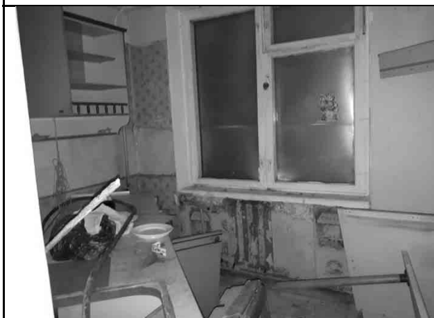
Фото 27. Типичное состояние пом. 18-Н
