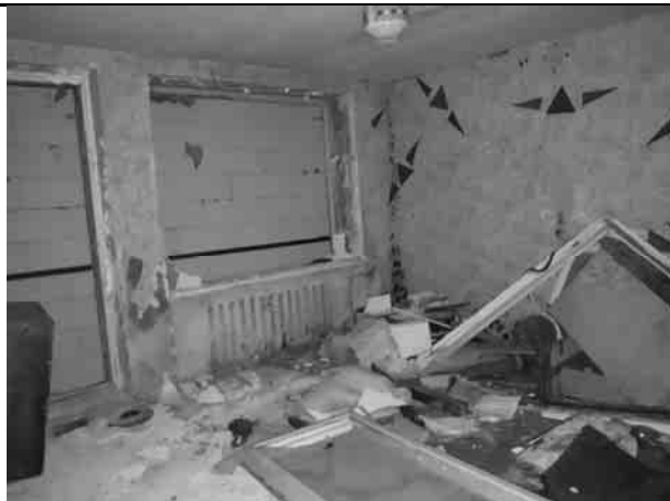
Фото 11. Типичное состояние пом. 7-Н
