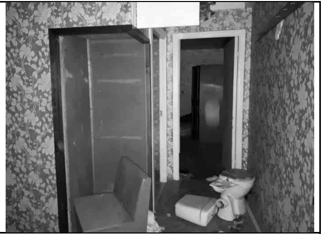
Фото 36. Типичное состояние пом. 22-Н
