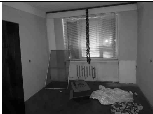
Фото 30. Типичное состояние пом. 19-Н
