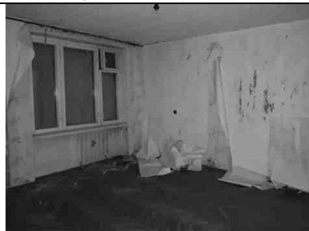
Фото 20. Типичное состояние пом. 13-Н
