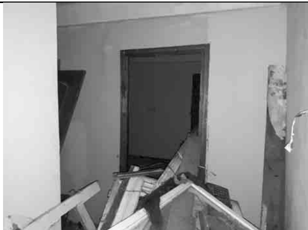
Фото 9. Типичное состояние пом.5-Н
