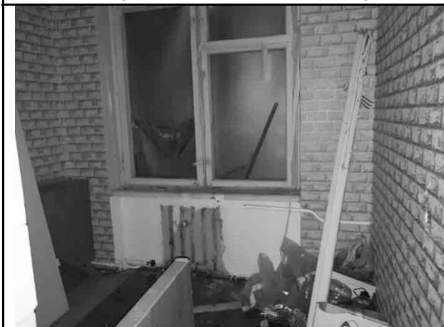
Фото 31. Типичное состояние пом. 20-Н
