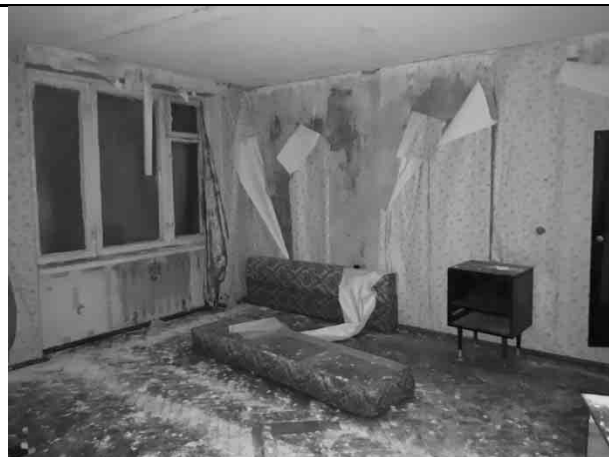
Фото 16. Типичное состояние пом. 10-Н
