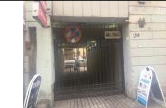
Фото 6. Вид арки входа во двор Объекта оценки
