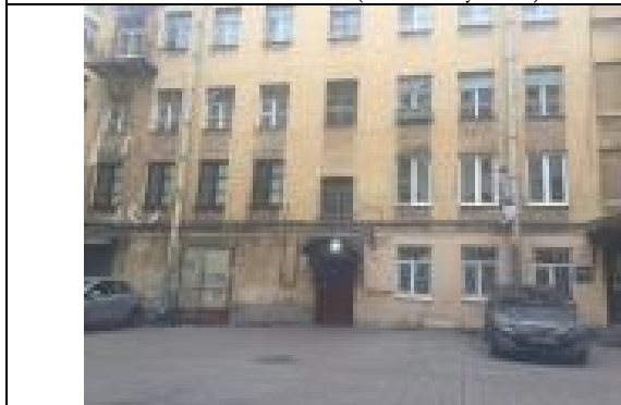
Фото 7. Внутривдворовая территория здания расположения Объекта оценки
