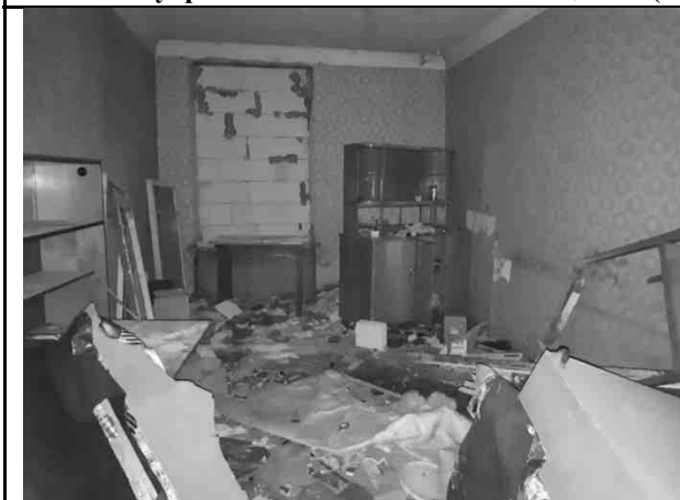
Фото 9. Типичное состояние пом. 5-Н
