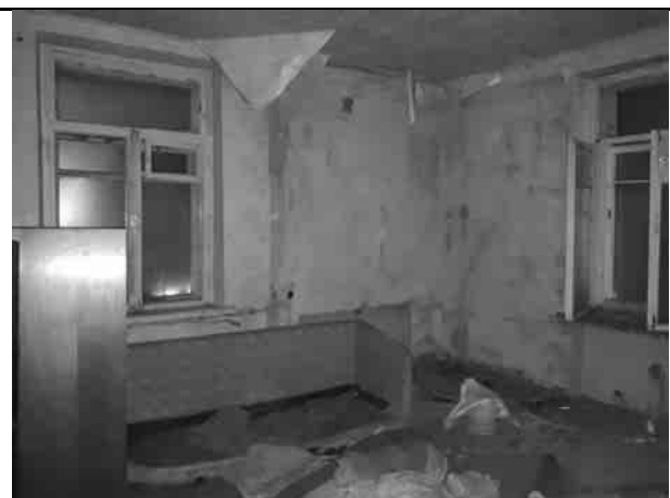
Фото 12. Типичное состояние пом. 8-Н
