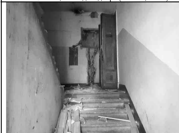
Фото 7. Лестничная клетка 1-го этажа (ЛК № 1)
