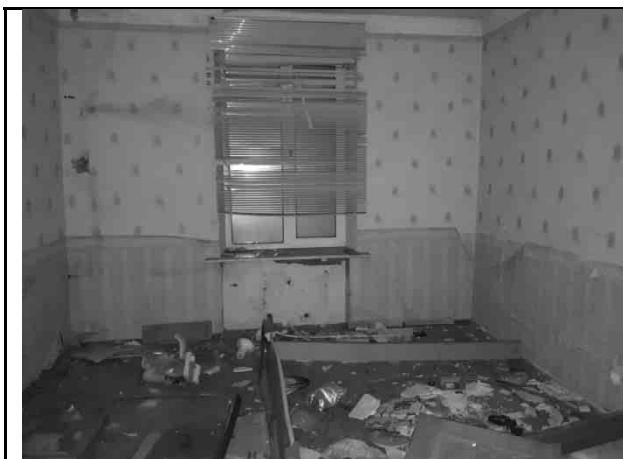
Фото 11. Типичное состояние пом. 7-Н
