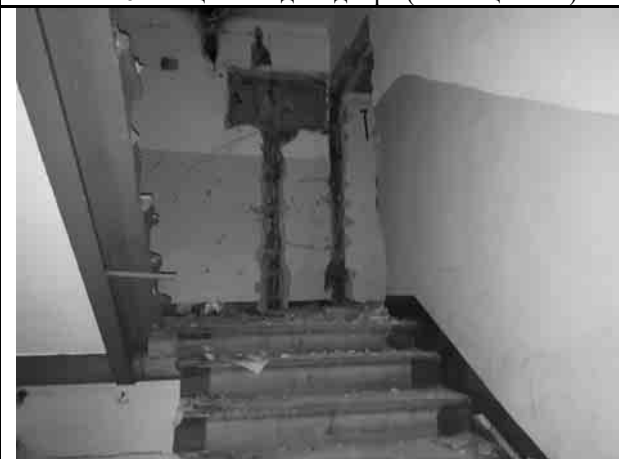
Фото 8. Лестничная клетка 2-го этажа (ЛК № 1)
