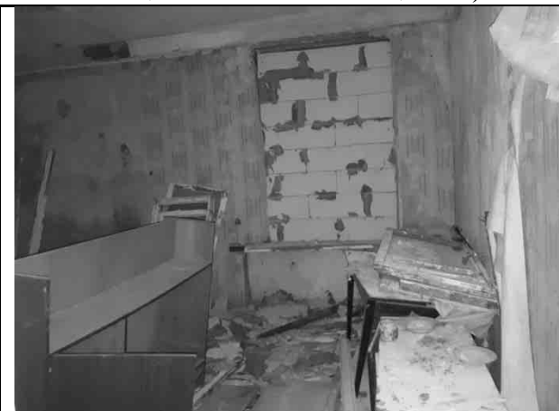
Фото 10. Типичное состояние пом. 6-Н
