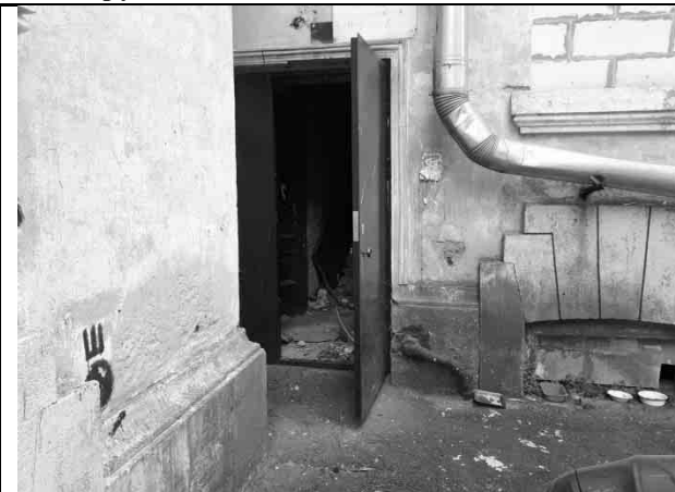
Фото 6. Общий вход со двора (лестница № 2)
