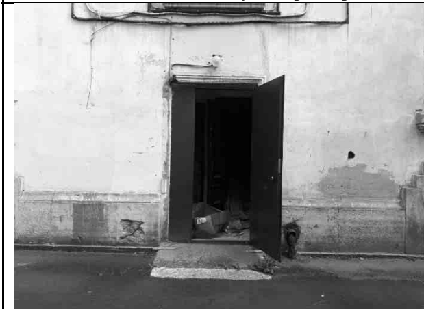
Фото 5. Общий вход со двора (лестница № 1)
