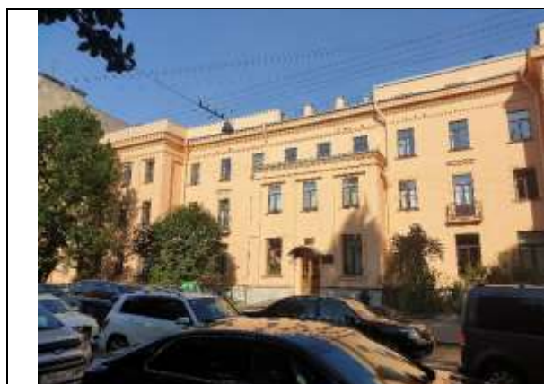
Фото №1 Здание, в котором располагается Объект оценки
