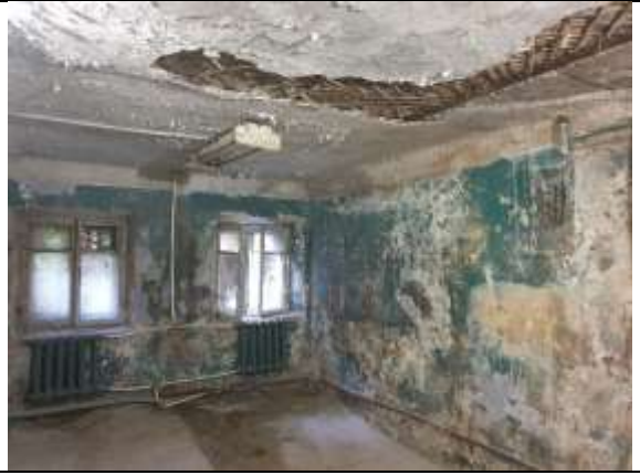
Фото №16 Внутренний вид ч.п. 4
