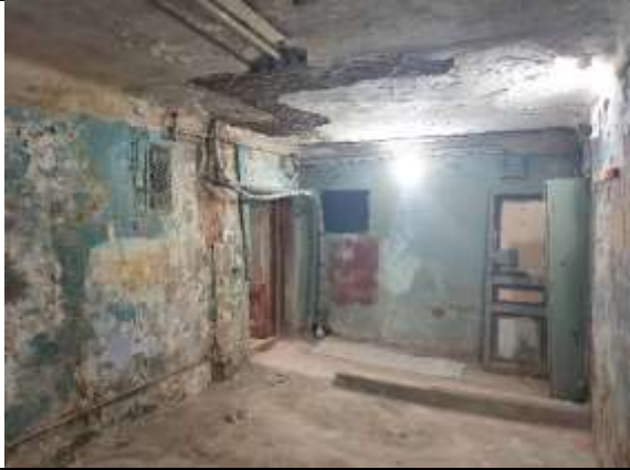
Фото №17 Внутренний вид ч.п. 4
