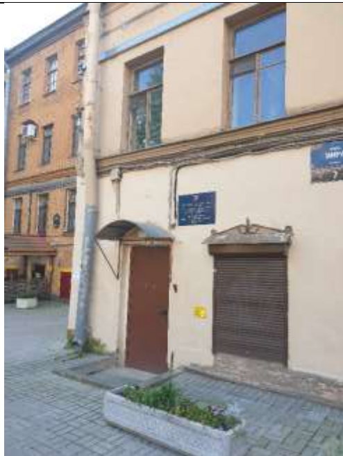
Фото №6. Внешнее окружение
