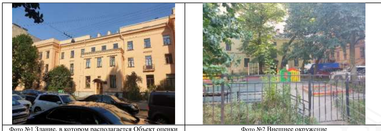
Фото №1 Здание, в котором располагается Объект оценки
