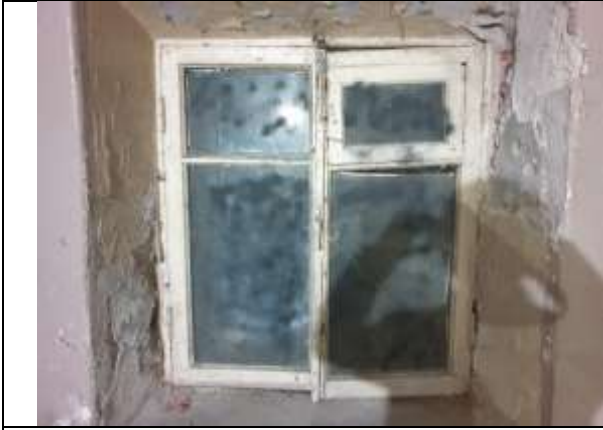
Фото №15 Оконный проем в ч.п. 5
