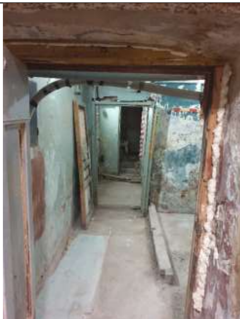
Фото №10 Вход в помещение ч.п. 1
