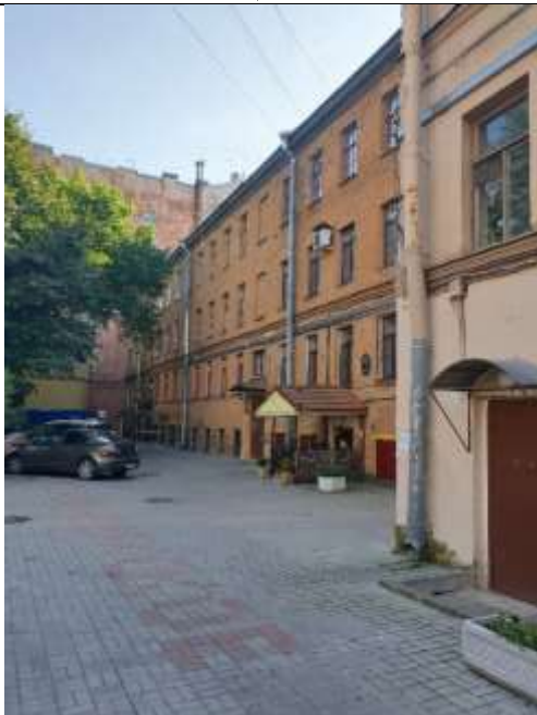
Фото №5 Внешнее окружение
