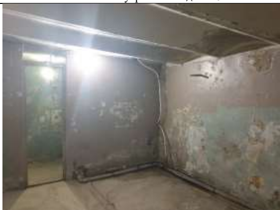
Фото №13 Внутренний вид ч.п. 5
