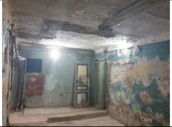
Фото №18 Внутренний вид ч.п. 4
