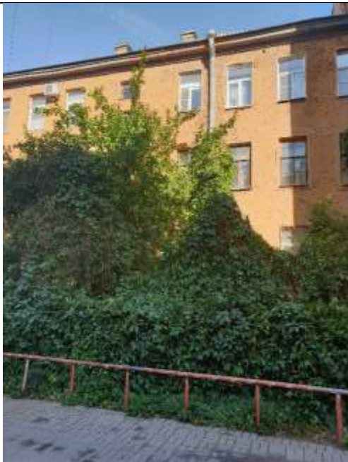
Фото №3 Жилой дом, в котором располагается Объект оценки
