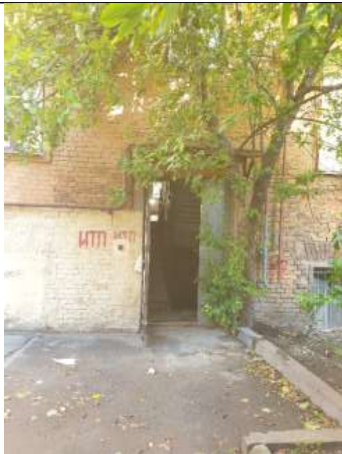
Фото №4. Вход со двора с улицы
