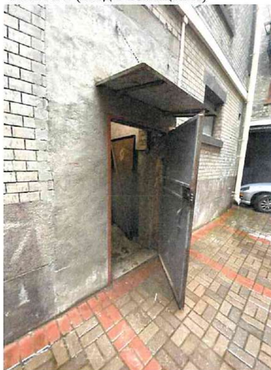
Фото № 2 (вход в помещение)
