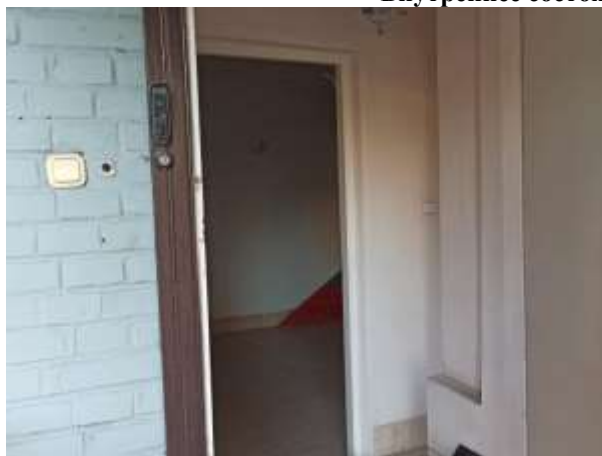
Фото 17. Отдельный вход в помещение
