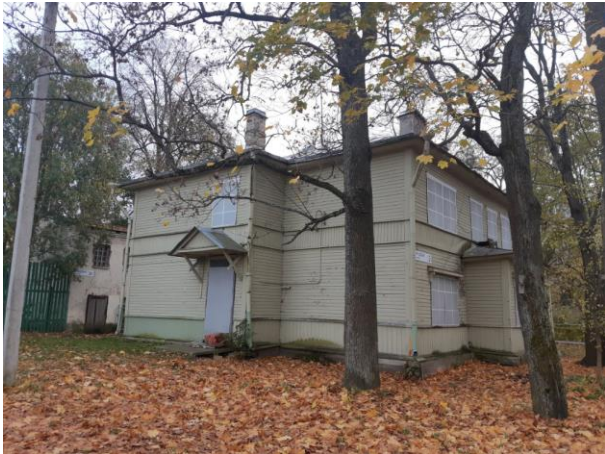
Фото 5. Вид здания, в котором расположен Объект оценки
