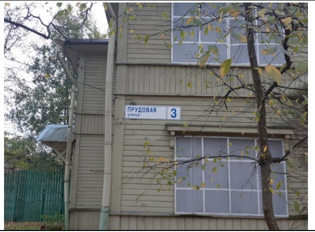
Фото 4. Вид здания, в котором расположен Объект оценки
