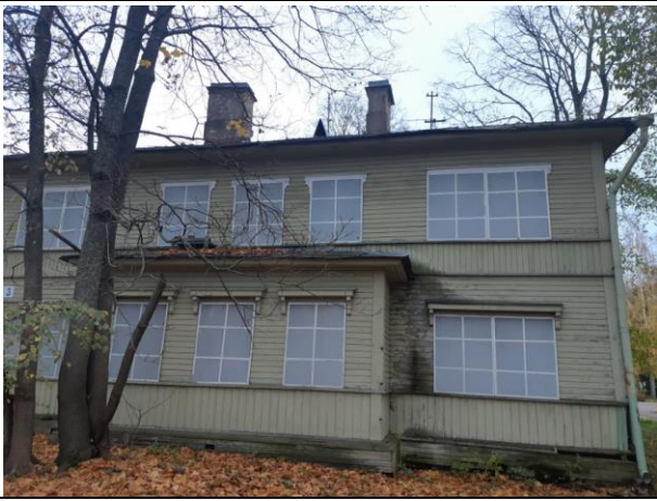
Фото 3. Вид здания, в котором расположен Объект оценки
