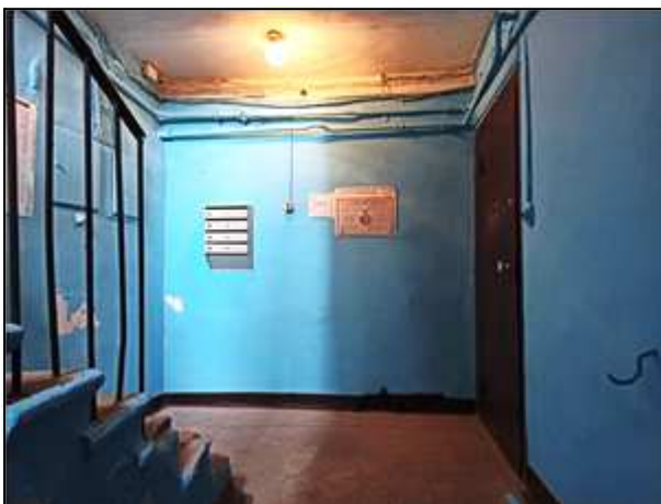
Фото 13. Вход в пом. 3-Н
