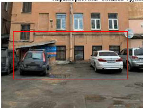
Фото 11. Общий вход со двора и оконные проемы пом. 3-Н
