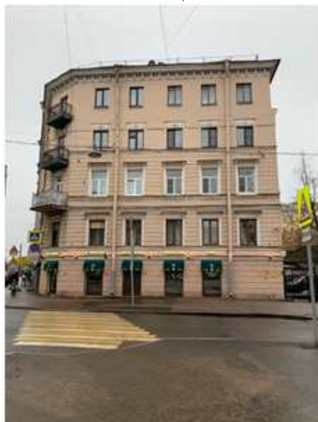
Фото 3. Вид здания, в котором расположен Объект оценки
