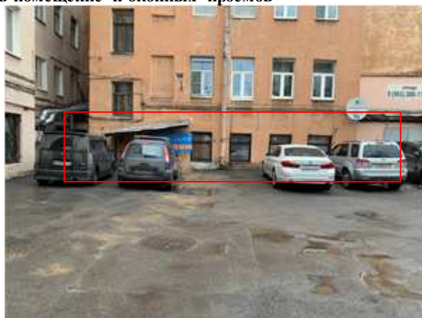
Фото 12. Общий вход со двора и оконные проемы пом. 3-Н
