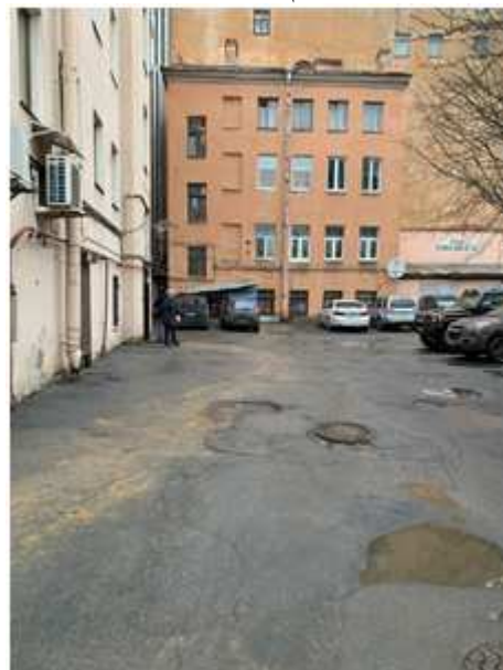
Фото 4. Вид здания, в котором расположен Объект оценки
