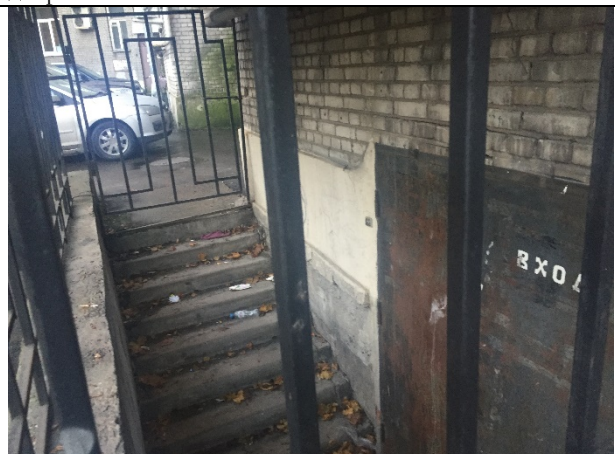
Фото 14. Вход в здание Объекта оценки
