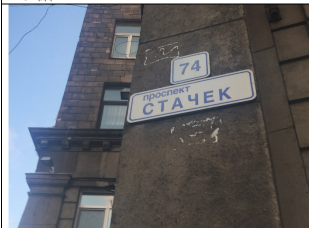
Фото 9. Адрес Объекта оценки
