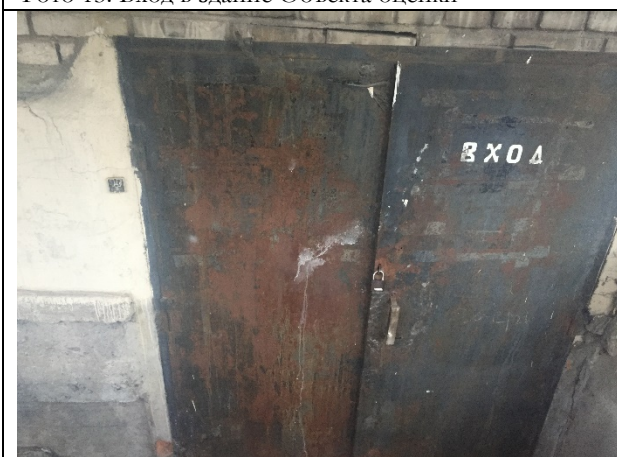
Фото 15. Вход в здание Объекта оценки
