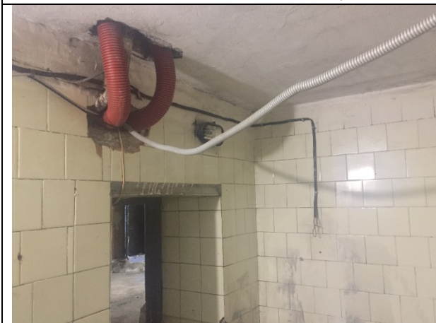
Фото 29. Типичное состояние Объекта оценки
