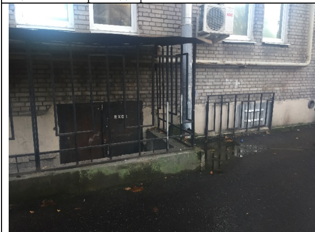
Фото 13. Вход в здание Объекта оценки
