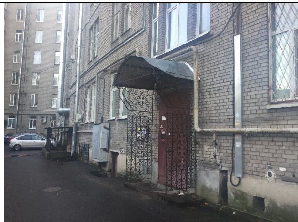
Фото 12. Вид здания Объекта оценки со стороны двора
