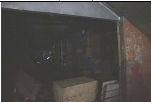
Фото 23. Типичное состояние Объекта оценки
