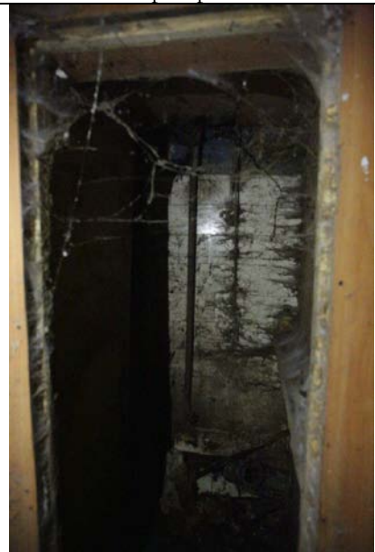
Фото 22. В ч.п. 1 установлены перегородки, образующие новую ч.п.
