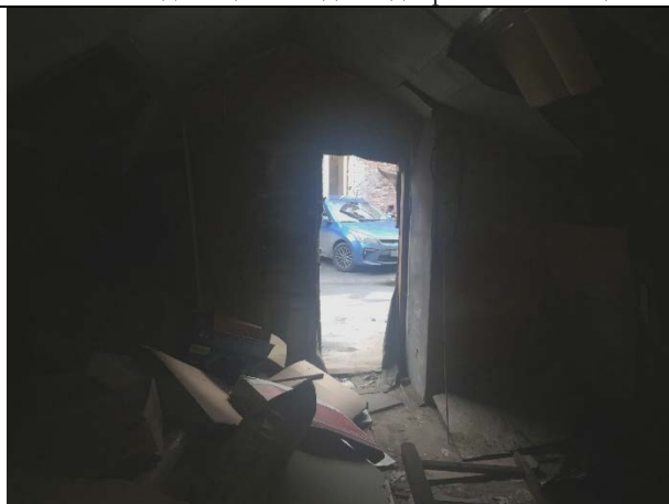
Фото 15. Вид МОП, здания расположения Объекта оценки
