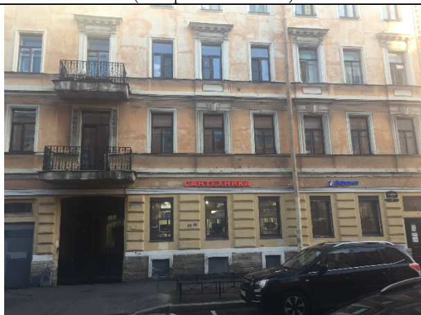
Фото 8. Вид фасада здания, расположения Объекта оценки
