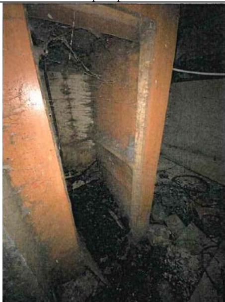
Фото 21. В ч.п. 1 установлены перегородки, образующие новую ч.п.
