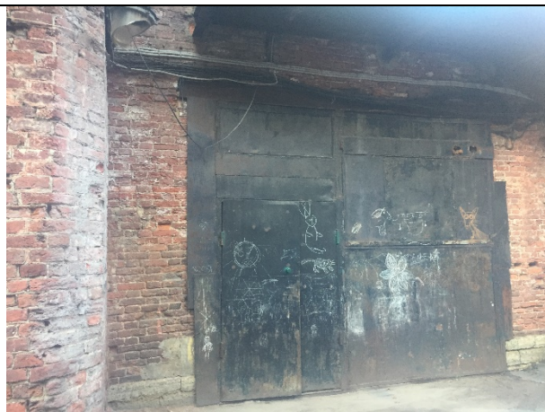
Фото 14. Вид общего входа со двора Объекта оценки
