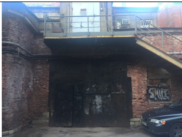
Фото 13. Вид общего входа со двора Объекта оценки
